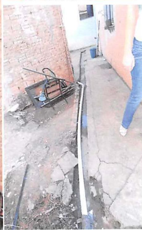
ÁREA DE SERVIÇO DESCOBERTA, TUBULAÇÃO DE ESGOTO DA COZINHA AO AR LIVRE.
