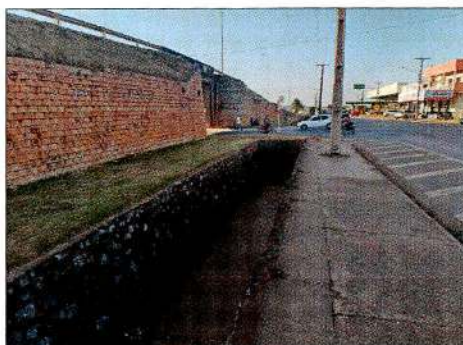
Localização Descrição BR-163/MT KM 753+400 NORTE. Limpeza do canal de escoamento de água pluvial.
