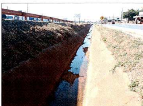
Localização Descrição BR-163/MT KM 751+200 NORTE. Limpeza do canal de escoamento de água pluvial.
