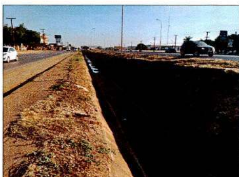
Localização Descrição BR-163/MT KM 751+500 NORTE. Limpeza do canal de escoamento de água pluvial.
