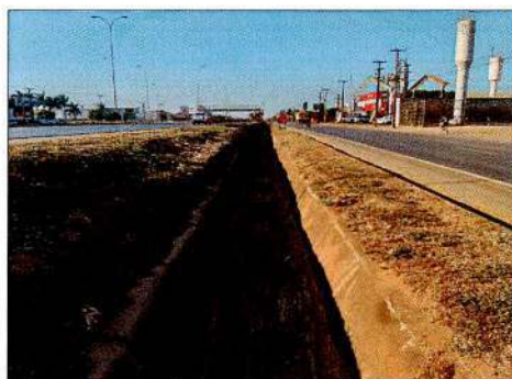
Localização Descrição BR-163/MT KM 750+600 NORTE. Limpeza do canal de escoamento de água pluvial.
