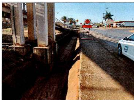
Localização Descrição BR-163/MT KM 751+000 NORTE. Limpeza do canal de escoamento de água pluvial.
