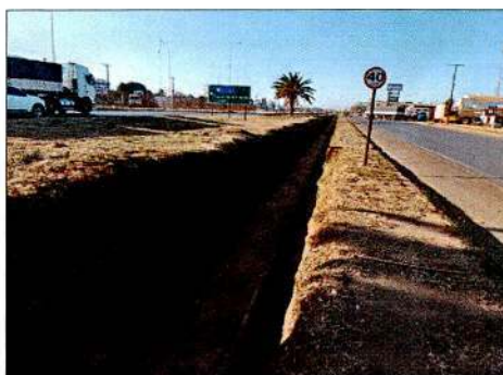
Localização Descrição BR-163/MT KM 751+100 NORTE. Limpeza do canal de escoamento de água pluvial.
