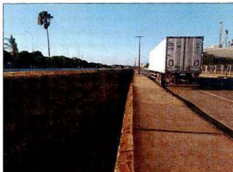
Localização Descrição BR-163/MT KM 753+000 NORTE. Limpeza do canal de escoamento de água pluvial.
