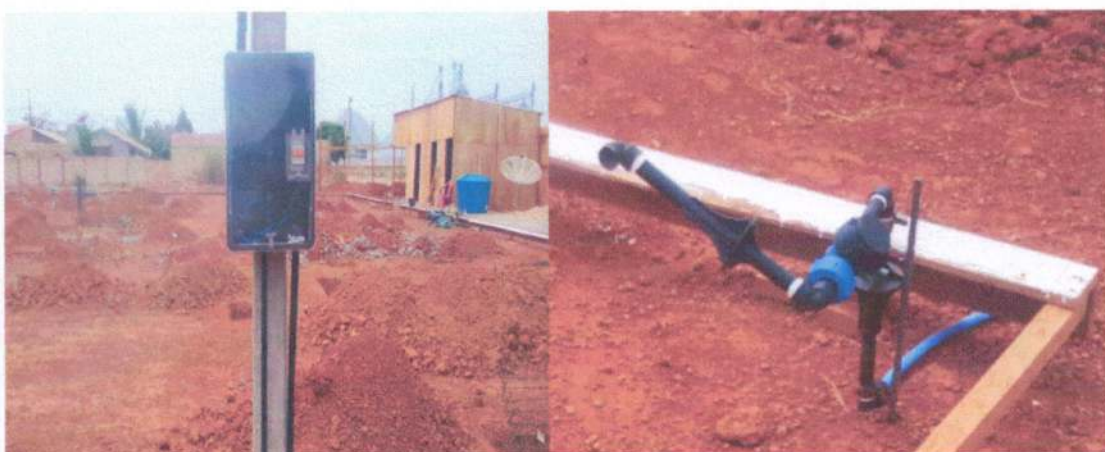
Figura 2: Instalação de água e energia elétrica.
