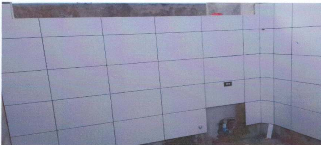
Figura 10: 12/02/2019 – revestimento de paredes
