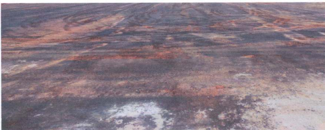
Figura 1: serviço de sondagem, terraplanagem e imprimação do terreno dezembro de 2013. Serviço realizado pelo município.
