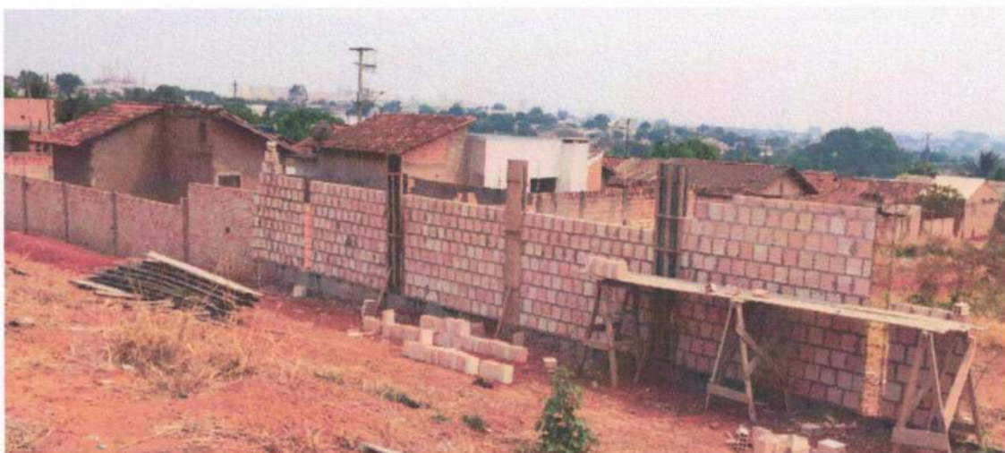
Figura 3: Muro de arrimo.
