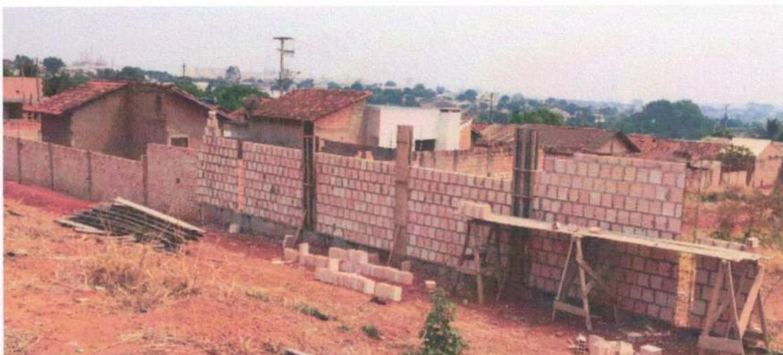
*Figura 3: Muro de arrimo.*
