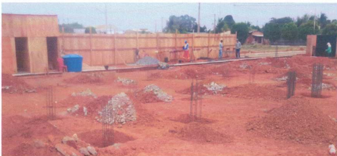
Figura 4: Início da obra em 15/09/2016.
