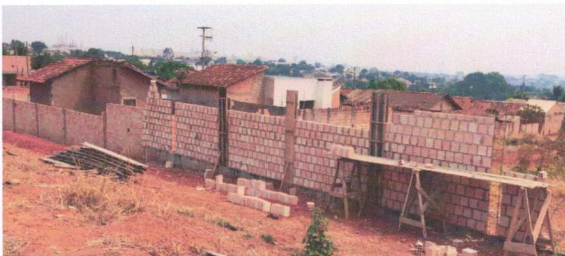
Figura 3: Muro de arrimo.
