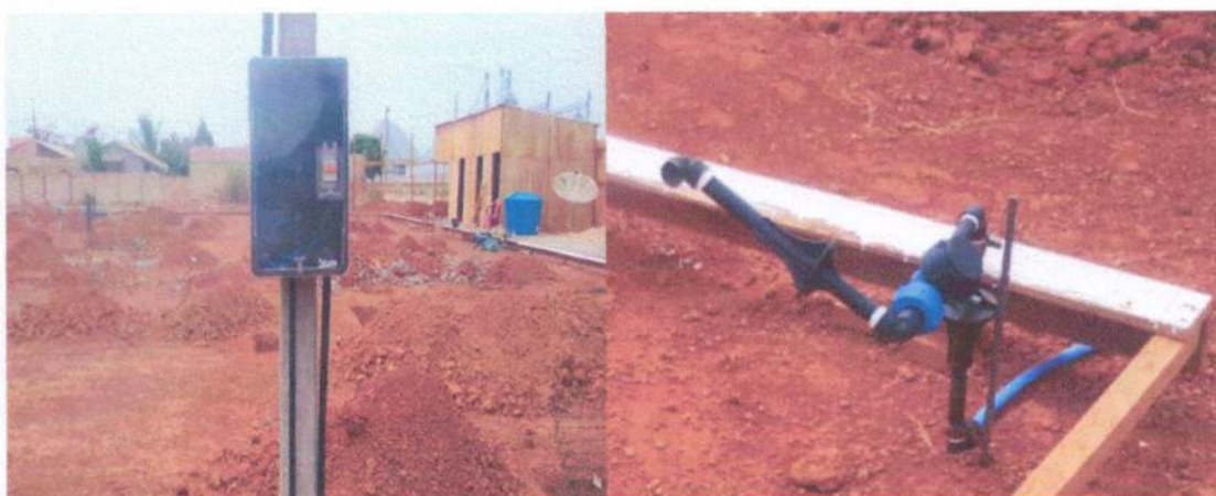
Figura 2: Instalação de água e energia elétrica.
