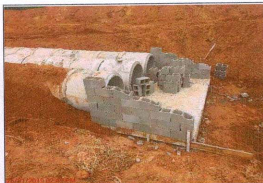
Localização Descrição KM 755+000 Norte BR - 163 Execução da ala de jusante.
