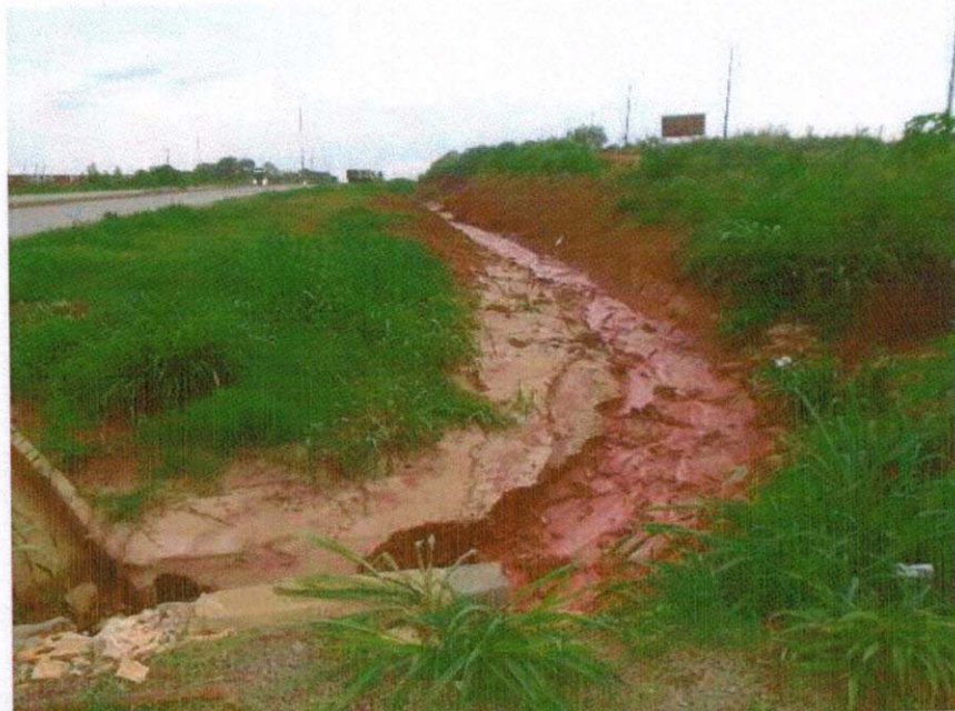
Figura 1: km 755+500m, sentido norte.
