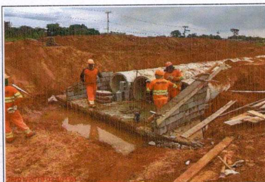
Localização Descrição KM 755+000 Norte BR - 163 Execução da ala de montante.
