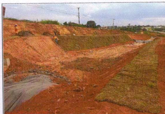
Localização Descrição KM 755+000 Norte BR - 163 Plantio de grama no talude interno da valeta onde foi recuperada a erosão.
