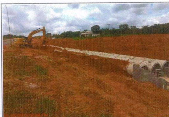
Localização Descrição KM 755+000 Norte BR - 163 Execução de drenagem pluvial. Início do reaterro do BTTC.
