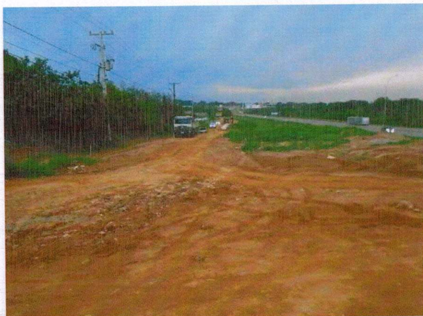
Figura 2: km 755+500m, sentido norte.
