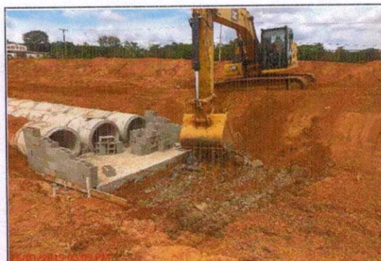
Localização Descrição KM 755+000 Norte BR - 163 Adição de rocha na jusante do bueiro para dissipar energia da água e evitar erosão.
