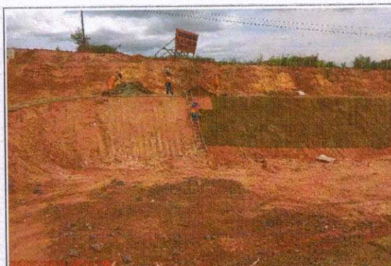
Localização Descrição KM 755+000 Norte BR - 163 Plantio de grama no talude interno da valeta onde foi recuperada a erosão.
