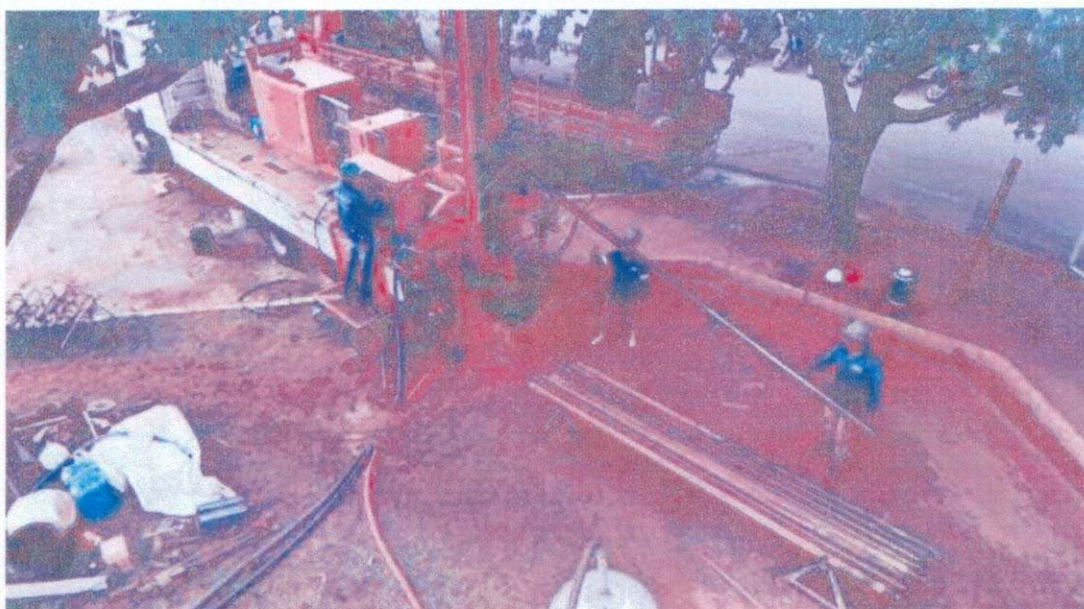
Foto 04 – Poço sendo perfurado
