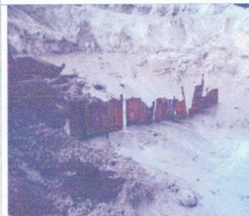
Foto 07 – Escoramento para contenção de areia
