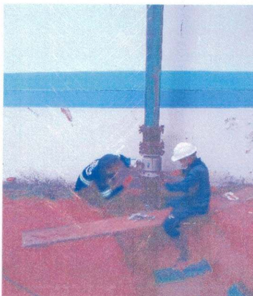
Figura 22 – Instalação do medidor na entrada da ETE
