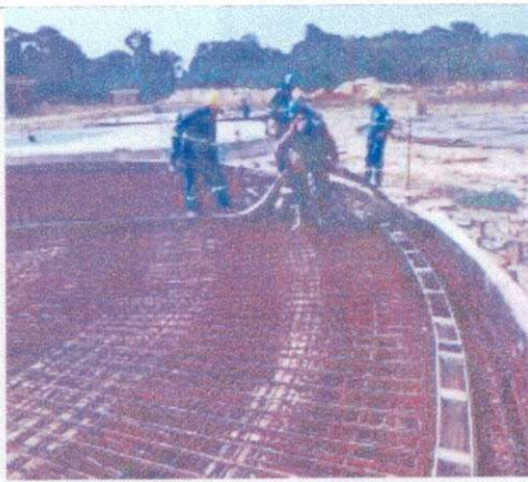
Foto 02 – Concretagem Base Tanque Aerado
