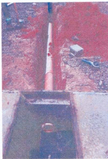
Figura 20 – Implantação de Rede coletora de Esgoto
