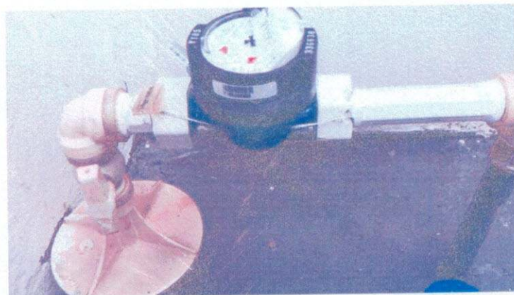
Figura 14 – Hidrômetro novo instalado
