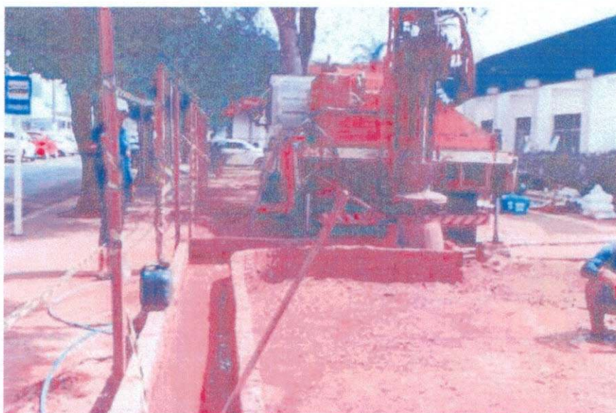
Foto 02 – Poço sendo perfurado
