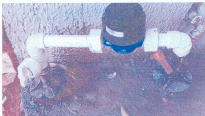
Figura 13 – Hidrômetro novo instalado
