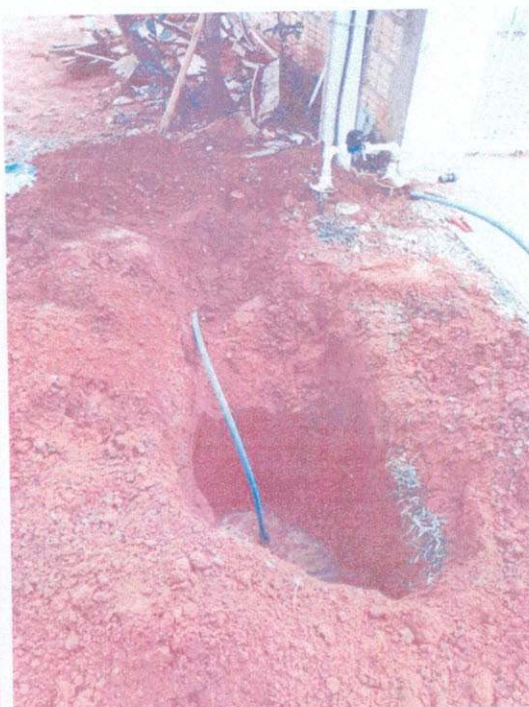
Figura 8 – Ligação nova de água
