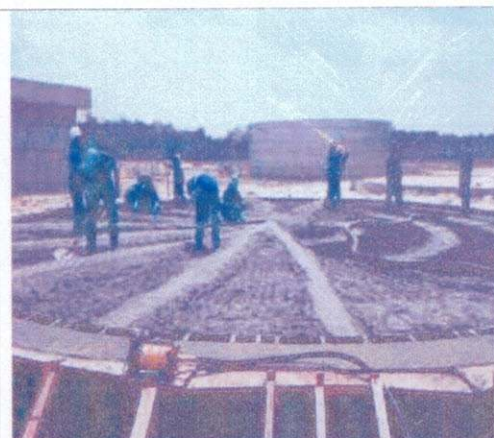
Foto 03 – Concretagem Base Tanque Aerado
