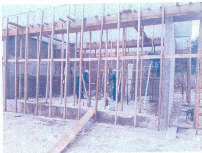
Figura 19 – Construção da ETE Teles Pires
