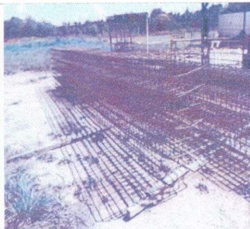
Foto 06 – Fabricação de ferragens para vigas e radier
