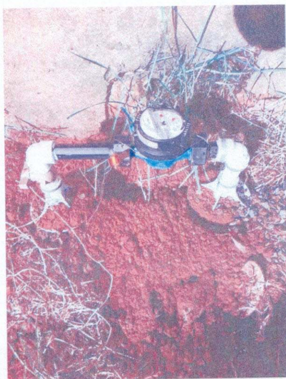
Figura 15 – Hidrômetro novo instalado
