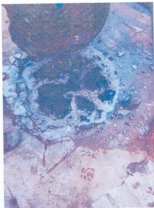
Figura 18 – Desobstrução em um PV
