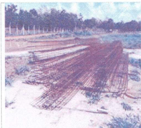
Foto 05 – Fabricação de ferragens para vigas e radier
