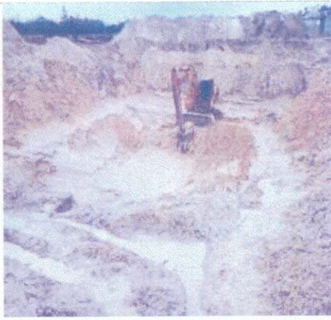
Foto 06 – Escavação de Elevatória de esgoto bruto
