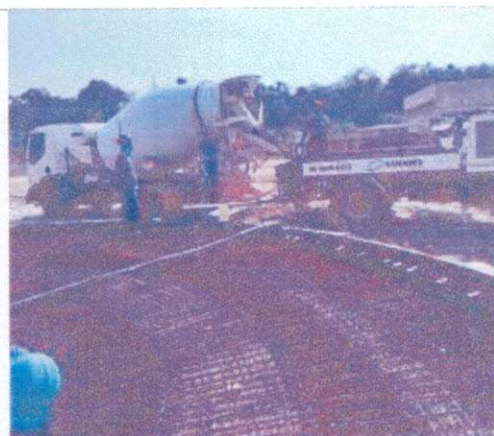
Foto 01 – Concretagem Base Tanque Aerado
