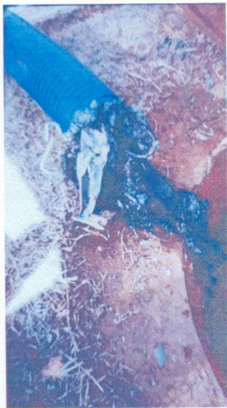
Figura 16 – Desobstrução em um PV
