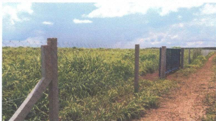
Figura 7: Instalação dos portões
