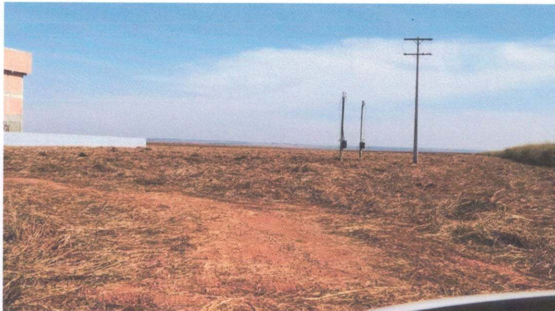
Figura 5: Limpeza da área
