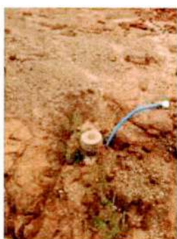
Pontos de espera da rede de esgoto estão recebendo areia para evitar acúmulo de água da chuva
