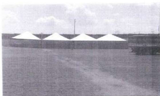
Foto 02: Armazenamento de defensivos agrícolas em local inadequado, conforme a NBR 9843-1.
