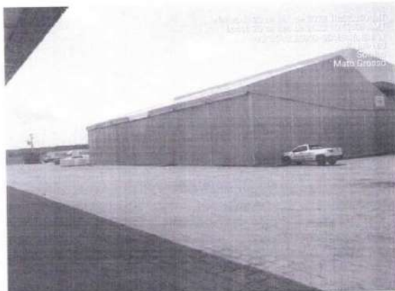
Foto 01: Armazenamento de defensivos agrícolas em local inadequado, conforme a NBR 9843-1.
