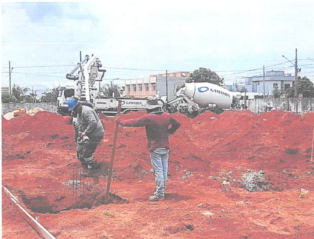
Foto 06: Concretagem de sapatas.
