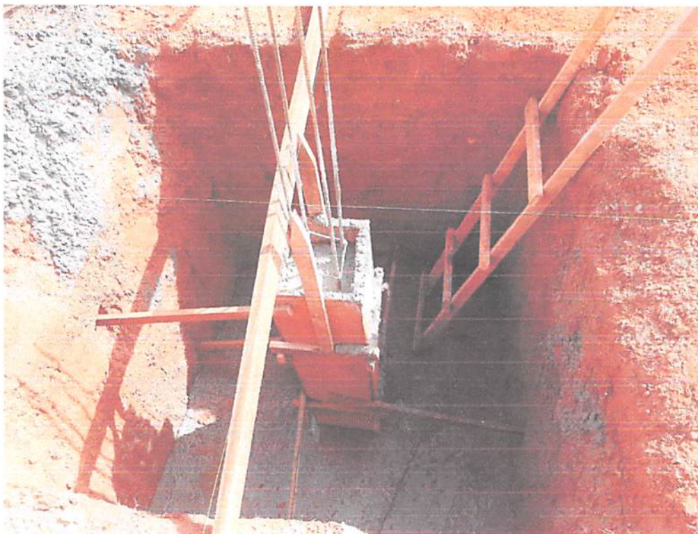
Foto 08: Sapatas e pilares de arranque concretados.
