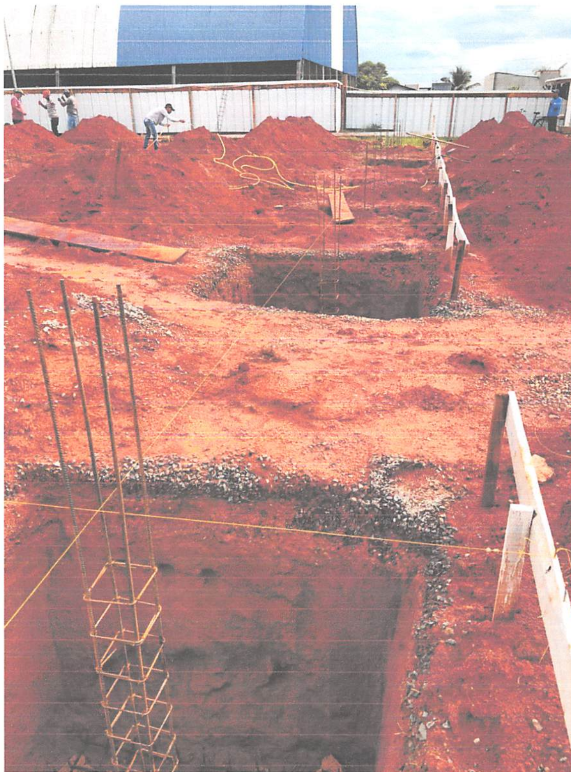
Foto 02: Armação de base de sapatas e arranque de pilares.
