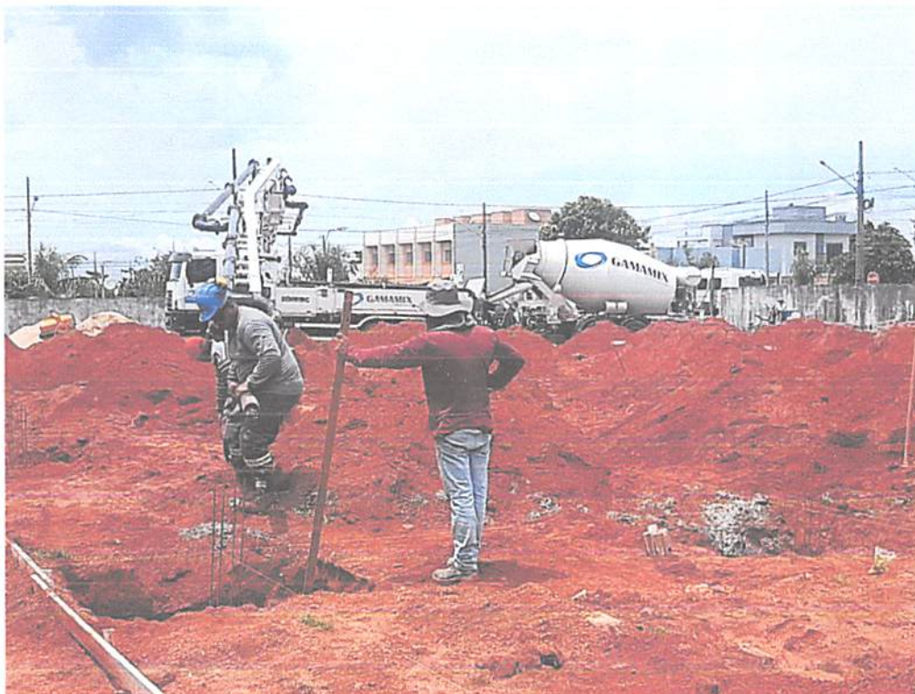
Foto 06: Concretagem de sapatas.
