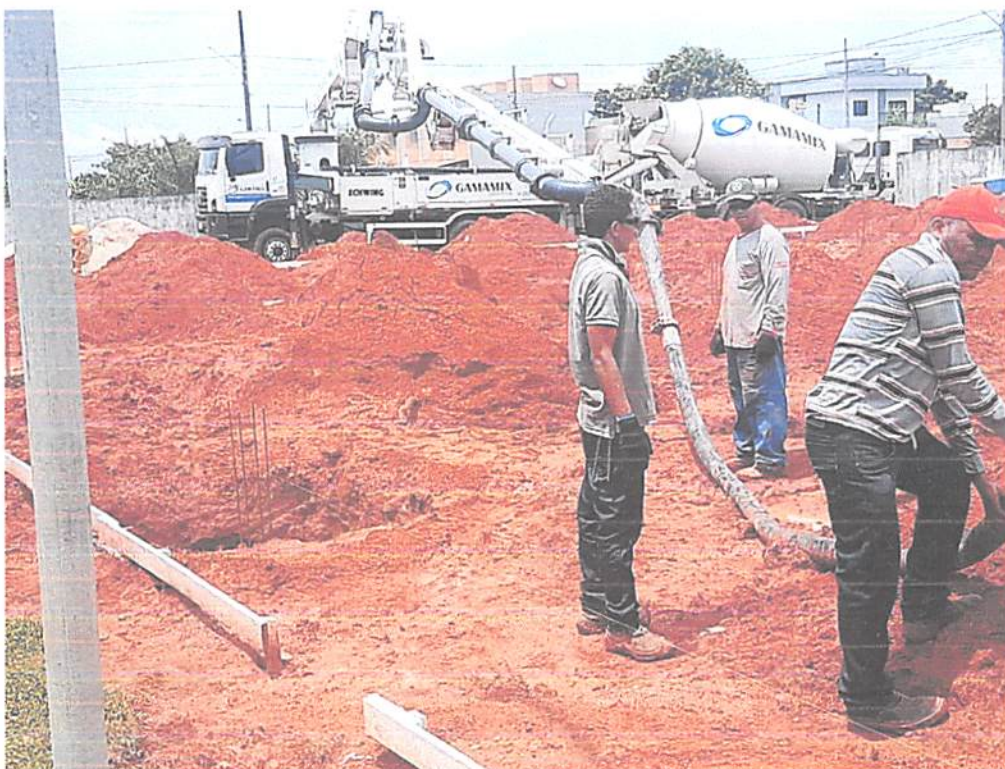
Foto 04: Concretagem de sapatas.
