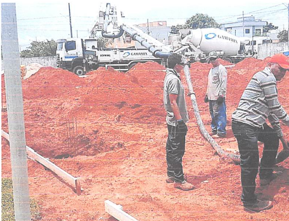
Foto 04: Concretagem de sapatas.
