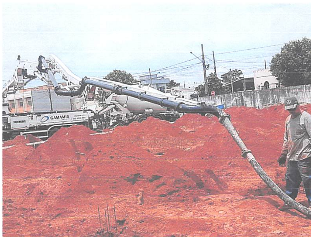
Foto 05: Concretagem de sapatas.
