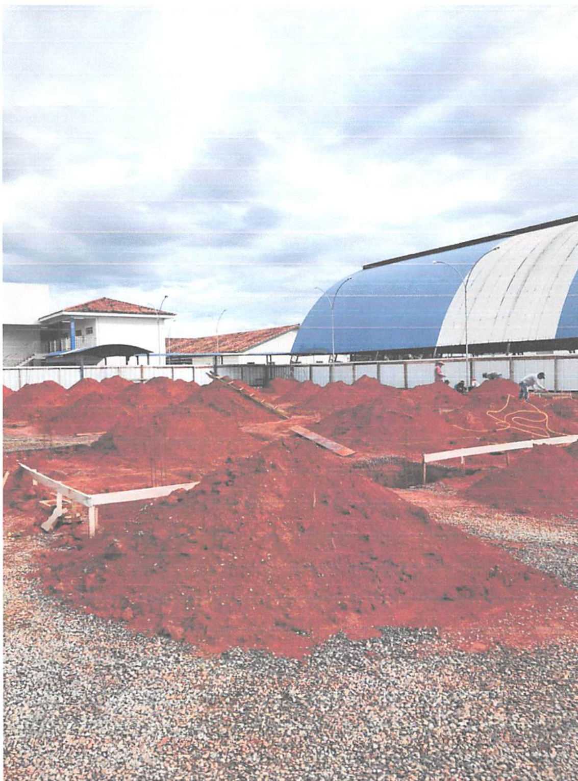
Foto 01: Escavação de sapatas.
