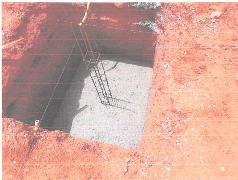
Foto 07: Sapatas concretadas.
