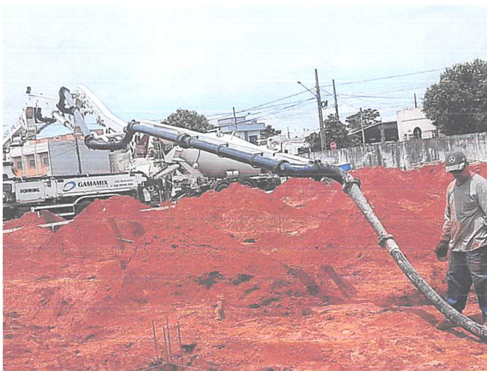
Foto 05: Concretagem de sapatas.
