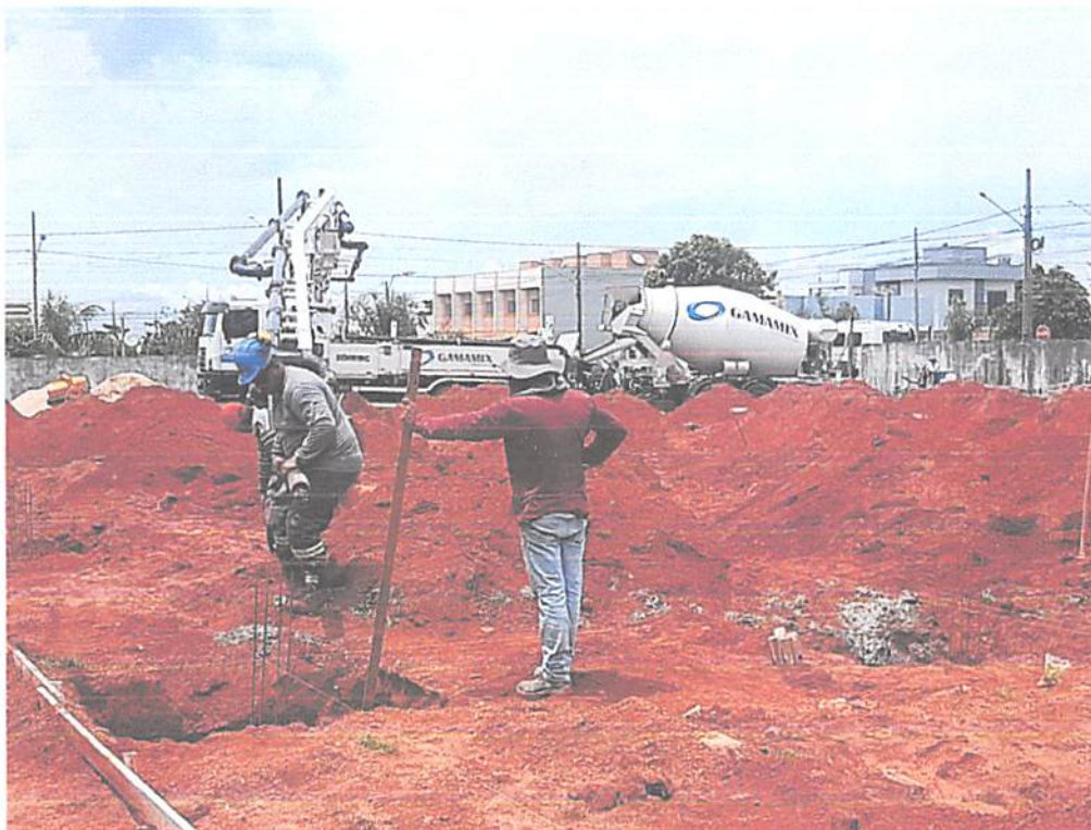
Foto 06: Concretagem de sapatas.
