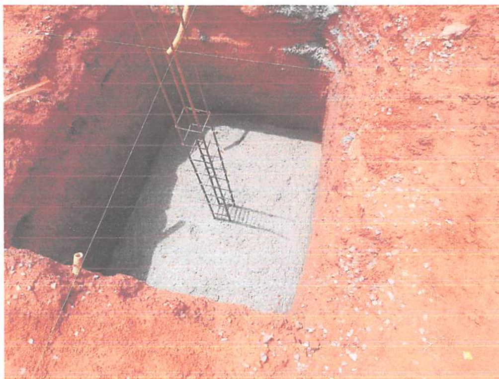
Foto 07: Sapatas concretadas.
