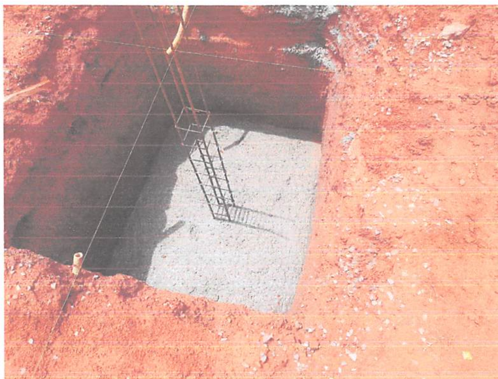
Foto 07: Sapatas concretadas.
