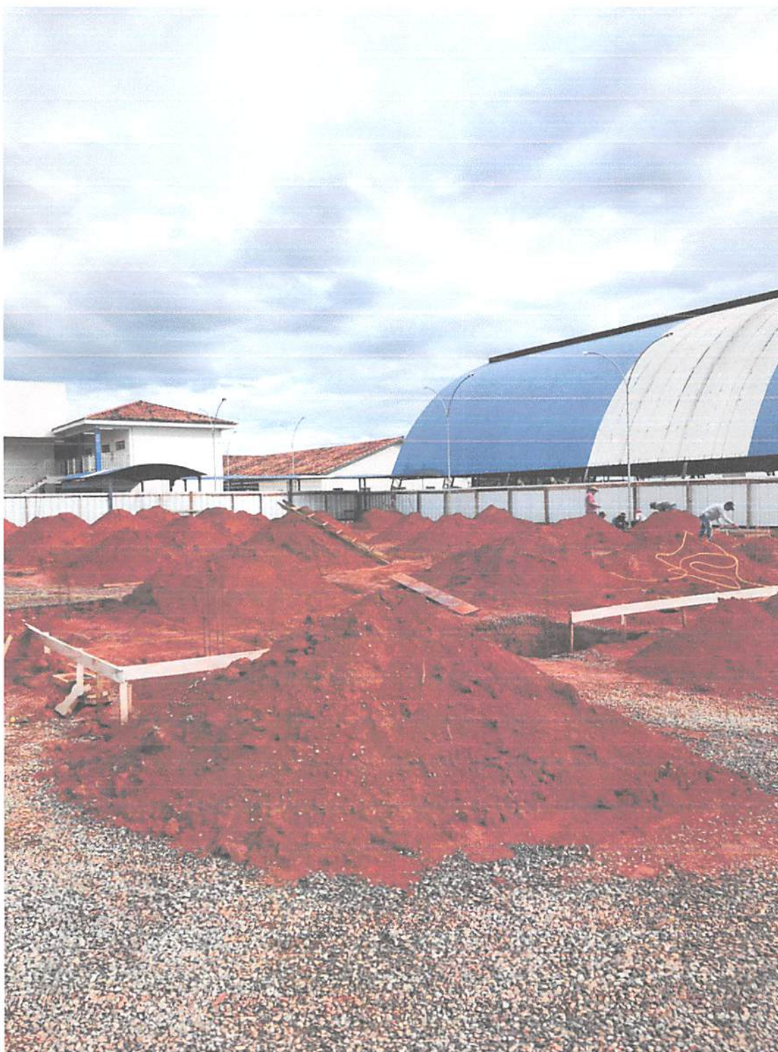
Foto 01: Escavação de sapatas.
