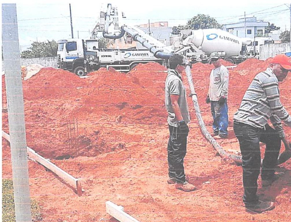
Foto 04: Concretagem de sapatas.
