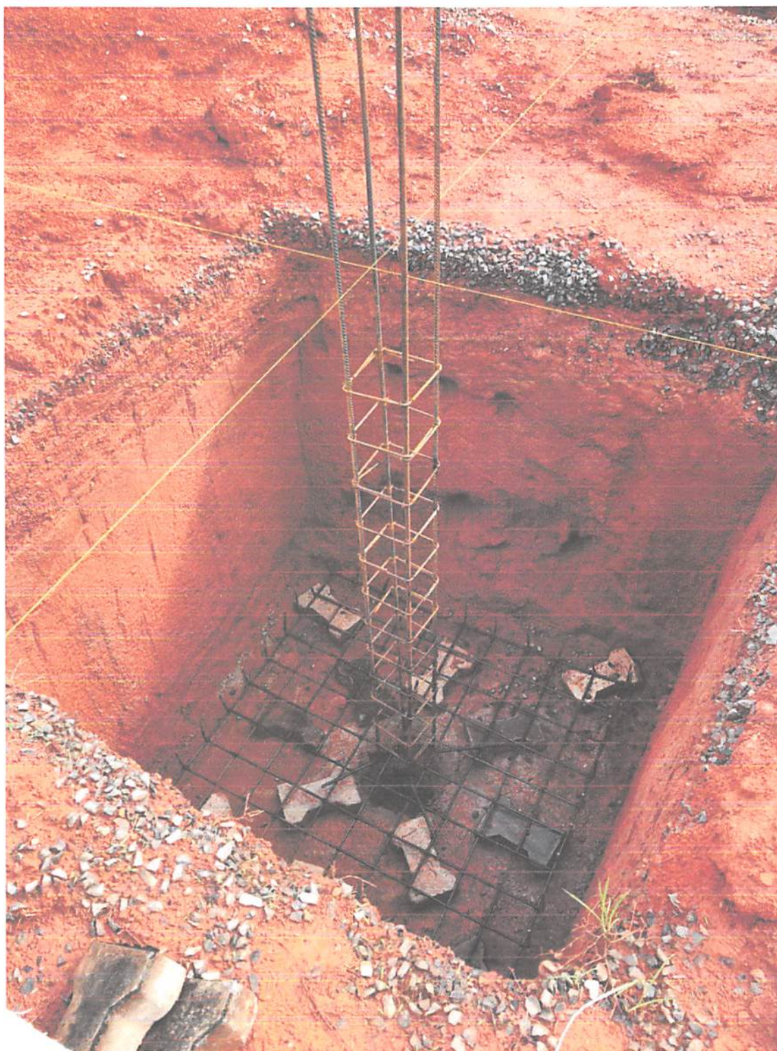
Foto 03: Armação de base de sapatas e arranque de pilares.
