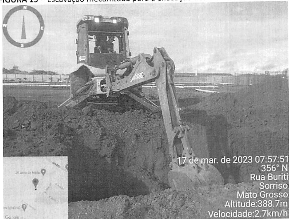
FIGURA 19 – Escavação mecanizada para a execução dos blocos de coroamento
