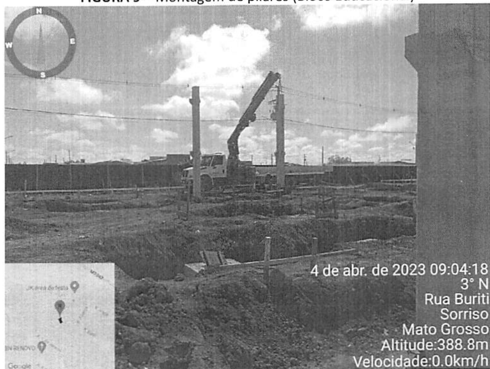
FIGURA 9 – Montagem de pilares (Bloco Educacional)
