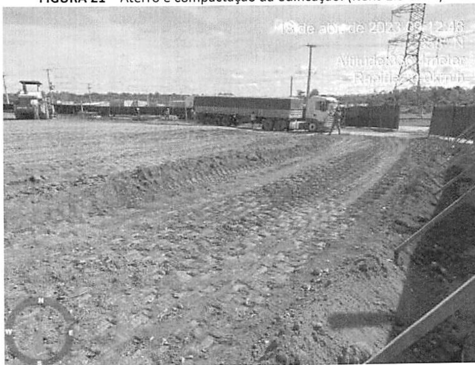
FIGURA 21 – Aterro e compactação da edificação. (Itens 2.3 e 2.4)
