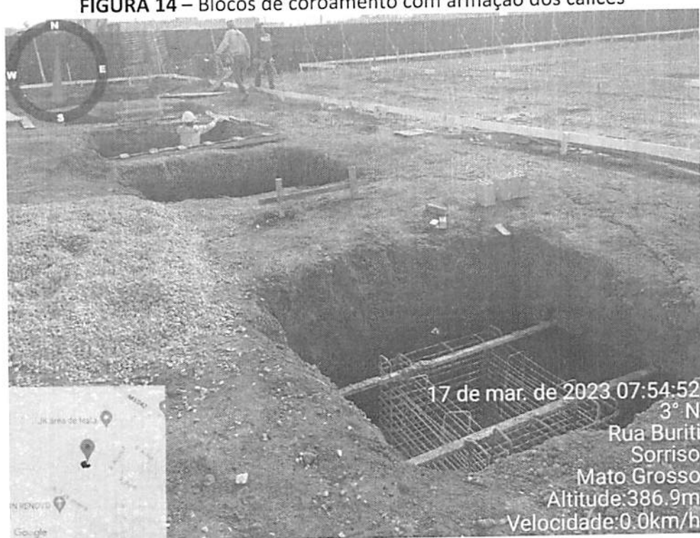
FIGURA 14 – Blocos de coroamento com armação dos cálices
