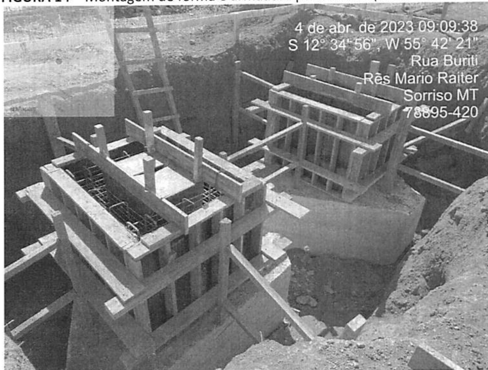
FIGURA 14 – Montagem de fôrma e armadura para cálices (Bloco Educacional)
