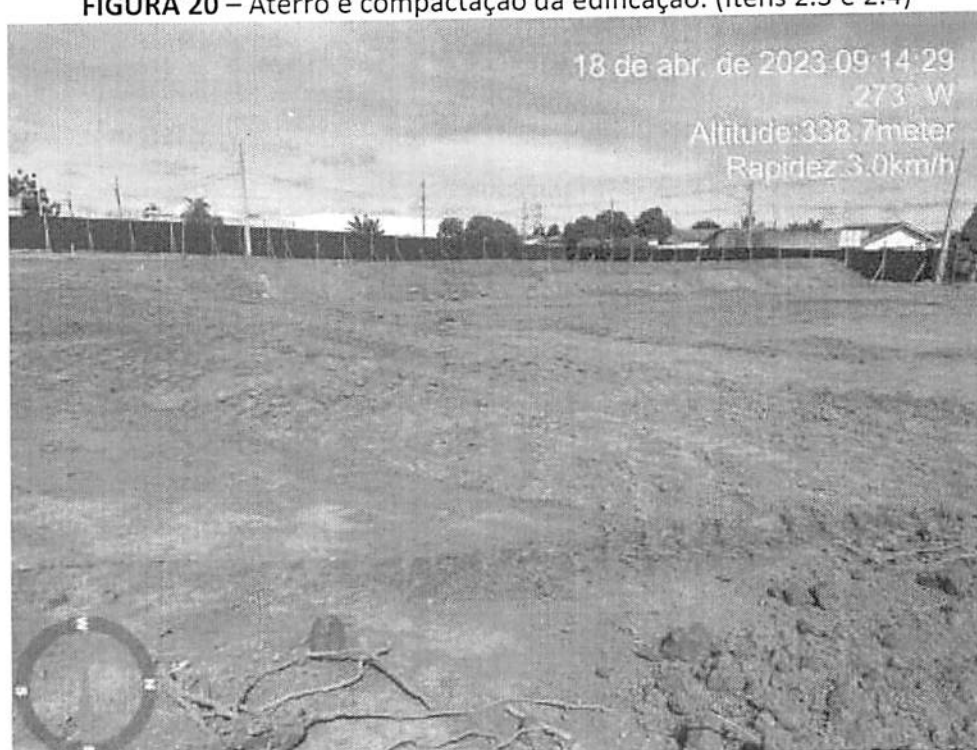
FIGURA 20 – Aterro e compactação da edificação. (Itens 2.3 e 2.4)
