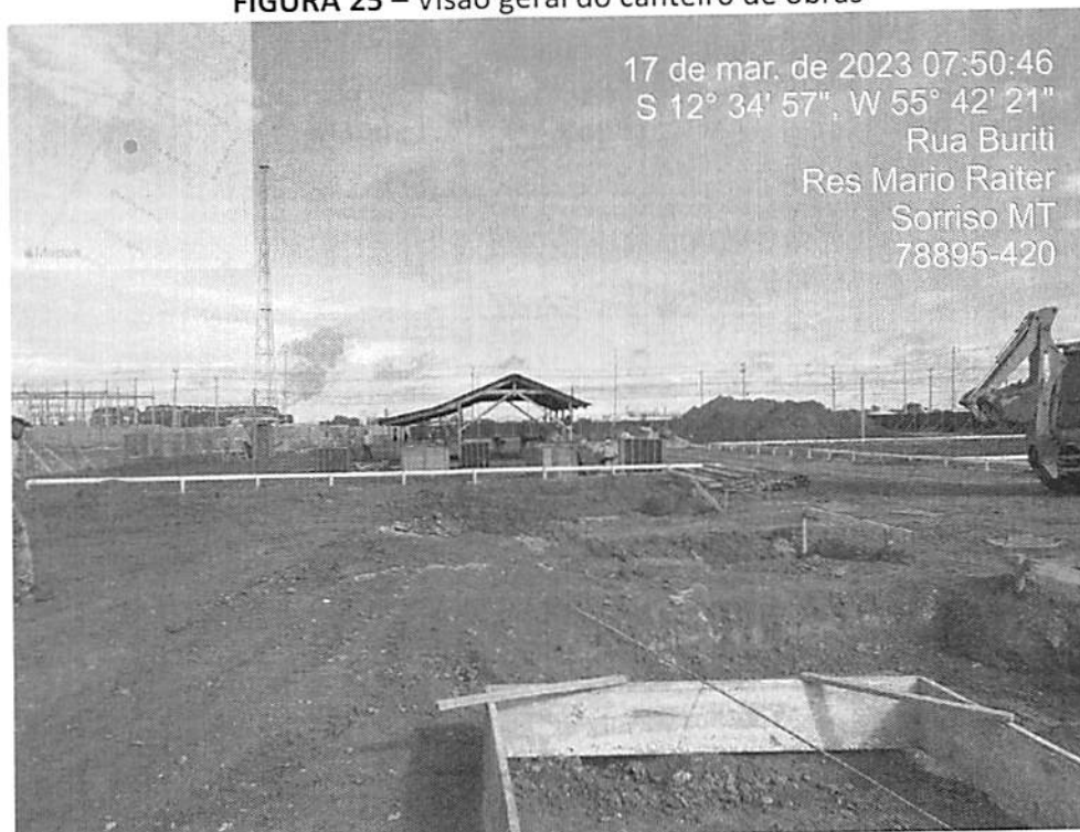
FIGURA 25 – Visão geral do canteiro de obras
