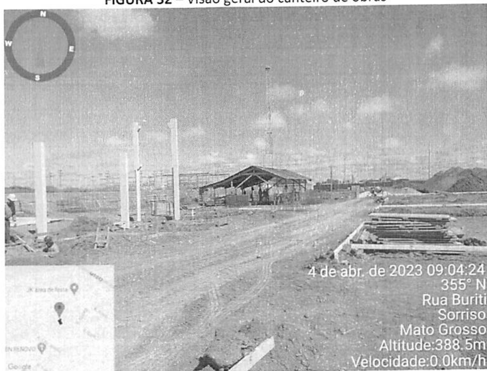
FIGURA 32 – Visão geral do canteiro de obras
