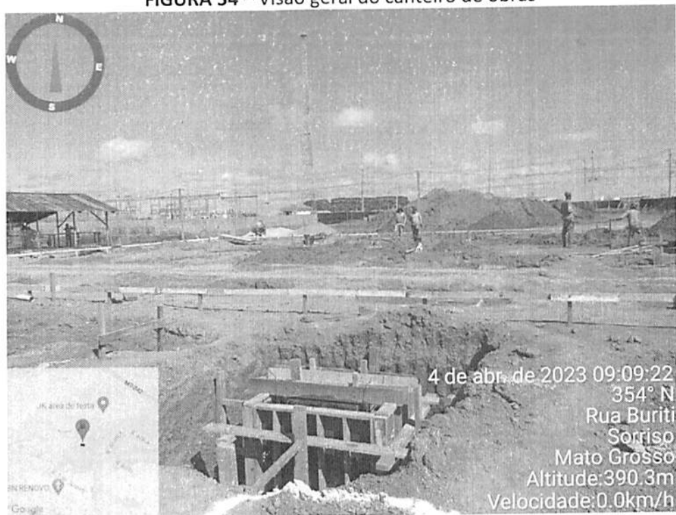
FIGURA 34 – Visão geral do canteiro de obras
