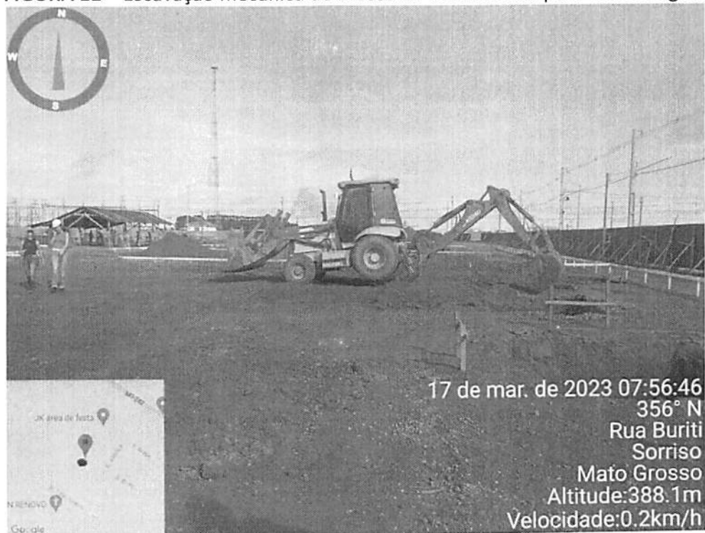
FIGURA 11 – Escavação mecânica de blocos de coroamento para concretagem
