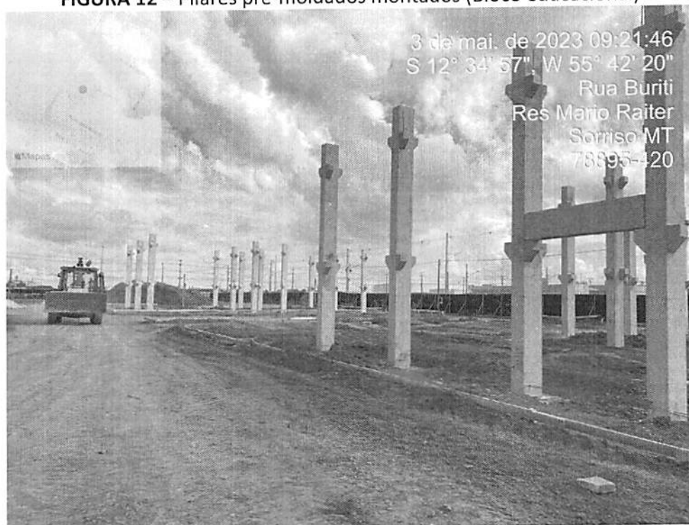
FIGURA 12 – Pilares pré-moldados montados (Bloco educacional)
