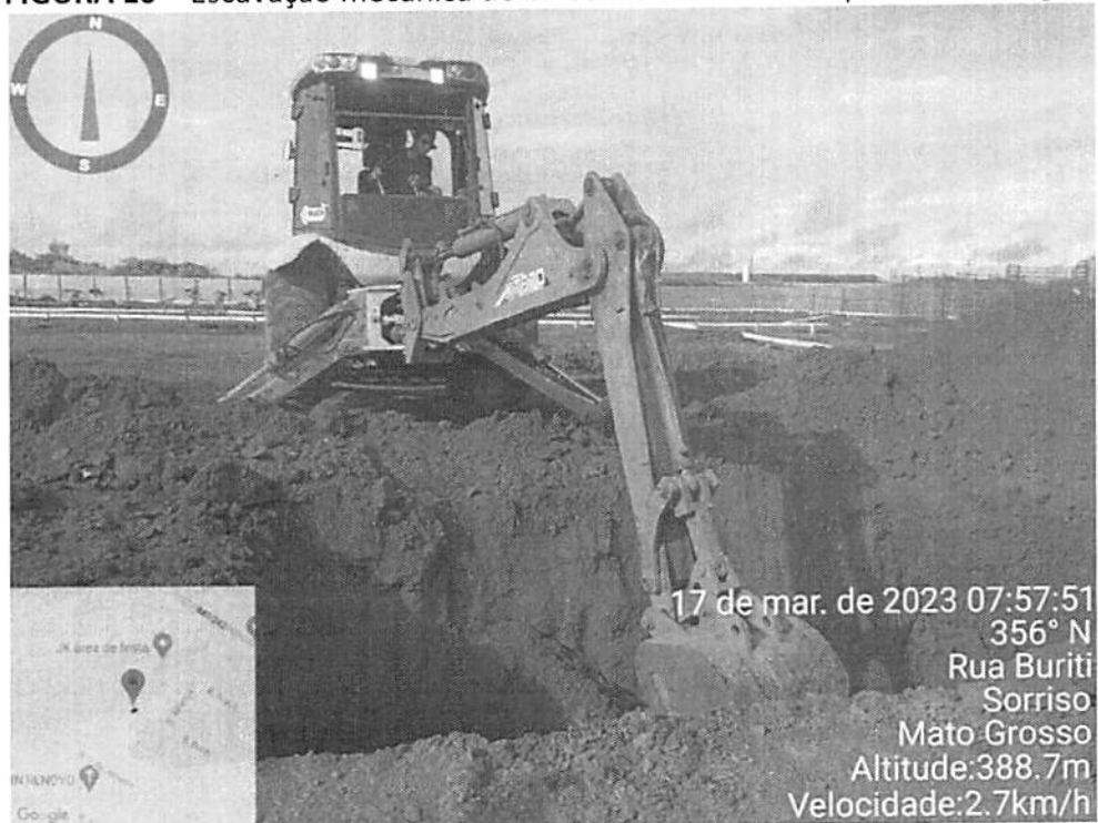
FIGURA 10 – Escavação mecânica de blocos de coroamento para concretagem
