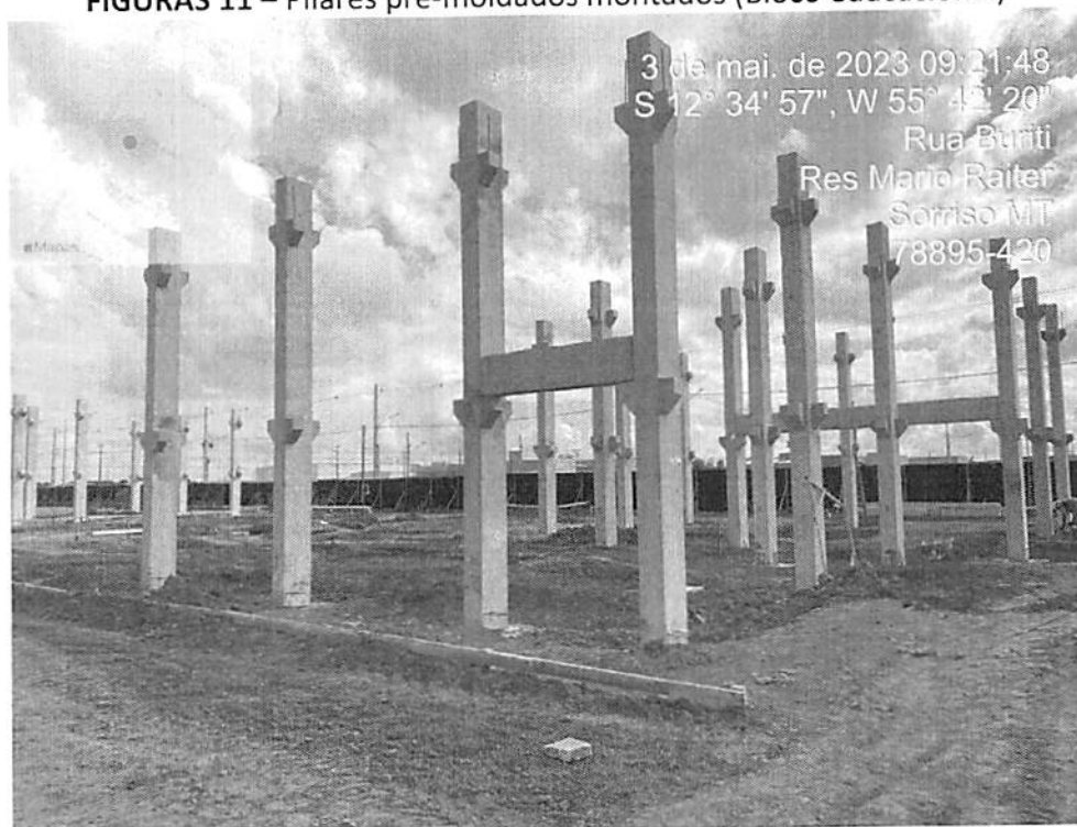
FIGURAS 11 – Pilares pré-moldados montados (Bloco educacional)
