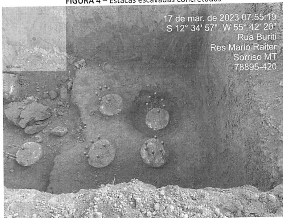
FIGURA 4 – Estacas escavadas concretadas
