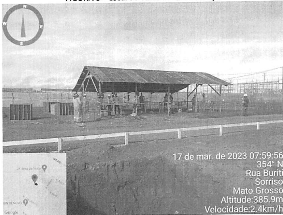
FIGURA 8 – Local de corte de dobra de aço
