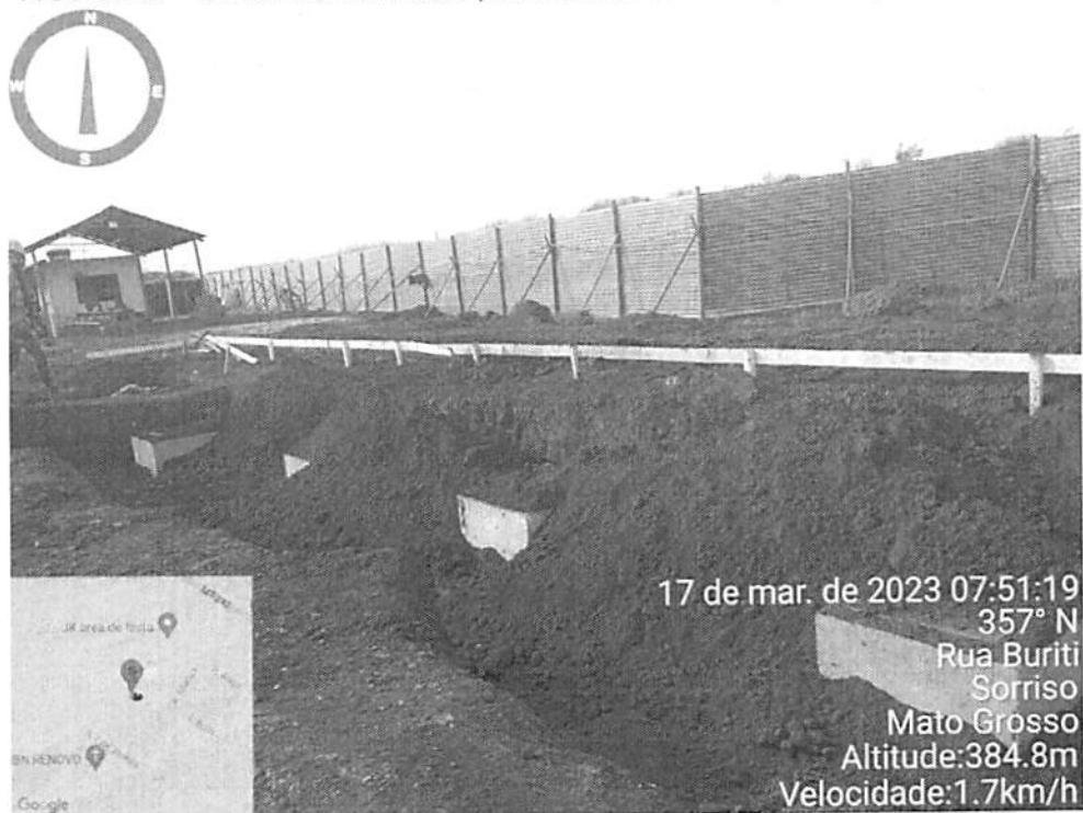
FIGURA 17 – Cálices de concreto para recebimento de pilares pré-moldados
