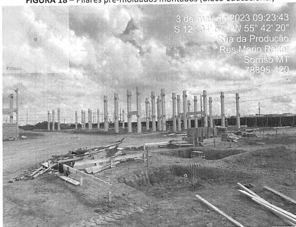
FIGURA 18 – Pilares pré-moldados montados (Bloco educacional)
