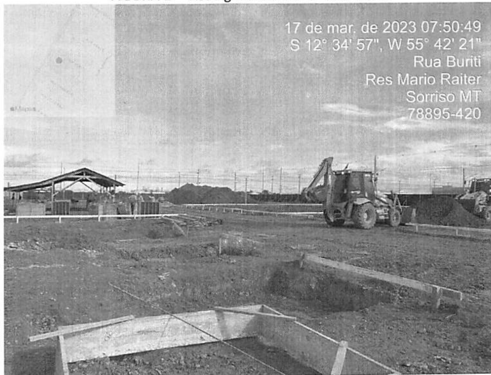
FIGURA 1 – Visão geral do canteiro de obras
