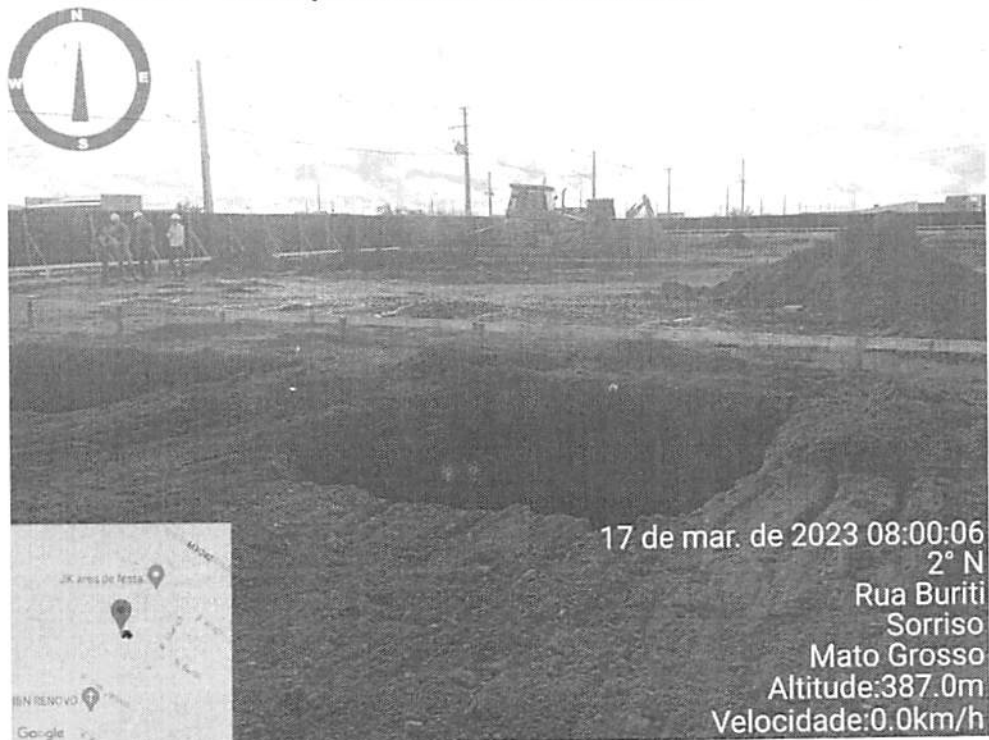
FIGURA 7 – Escavação de blocos de coroamento para concretagem
