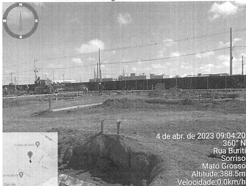
FIGURA 7 – Visão geral do canteiro de obras
