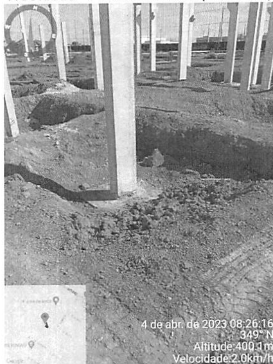
FIGURA 16 – Pilares montados (Refeitório)
