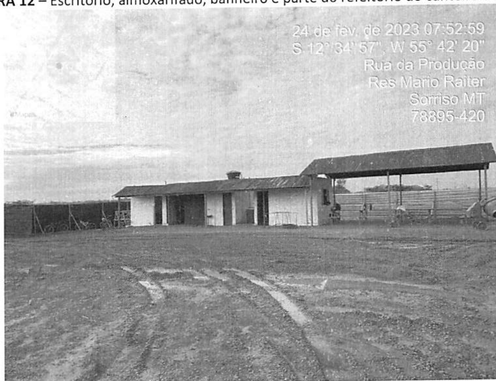
FIGURA 12 – Escritório, almoxarifado, banheiro e parte do refeitório do canteiro de obras
