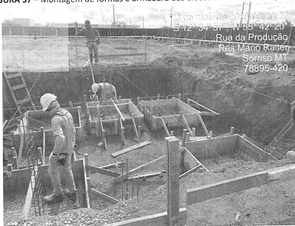
FIGURA 37 – Montagem de fôrmas e armadura dos blocos de coroamento (Quadra)
