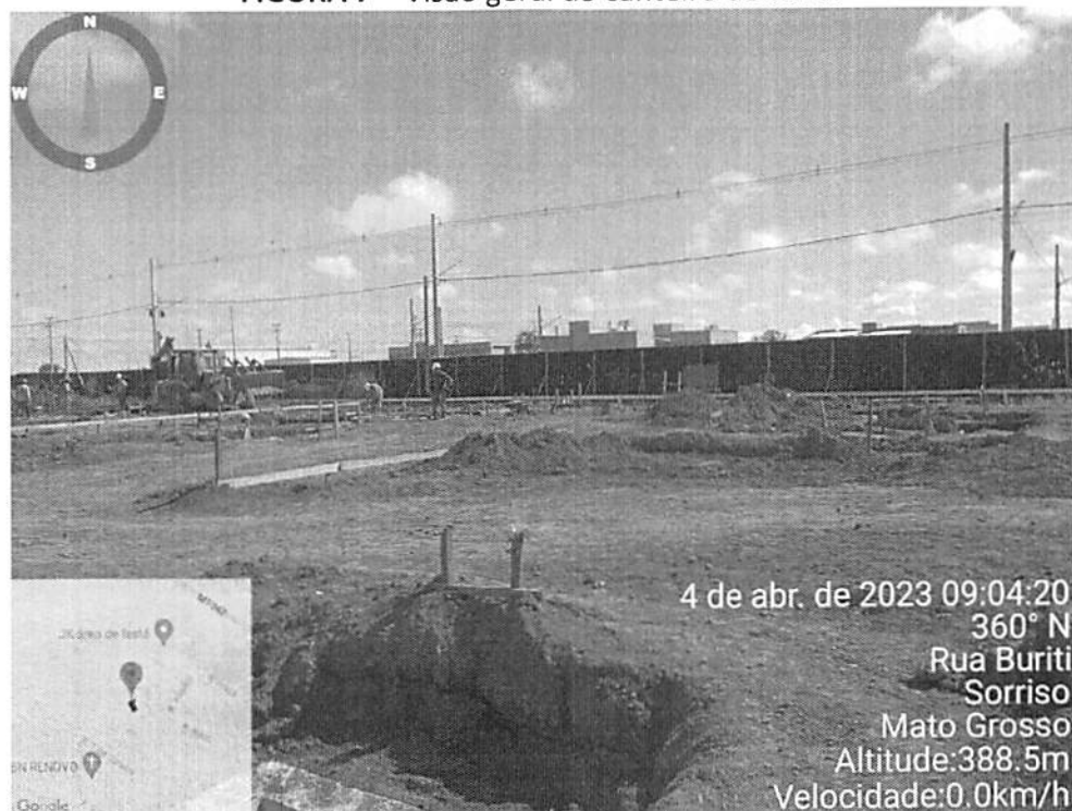
FIGURA 7 – Visão geral do canteiro de obras
