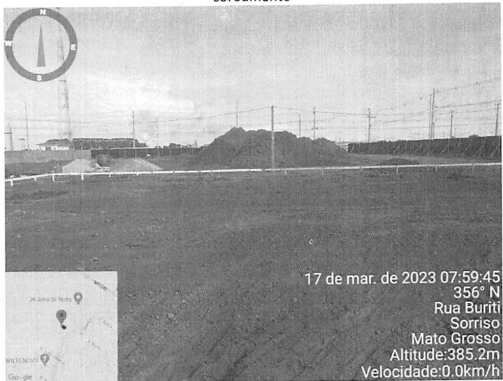
FIGURA 9 – Visão do canteiro e material granular oriundo da escavação dos blocos de coroamento
