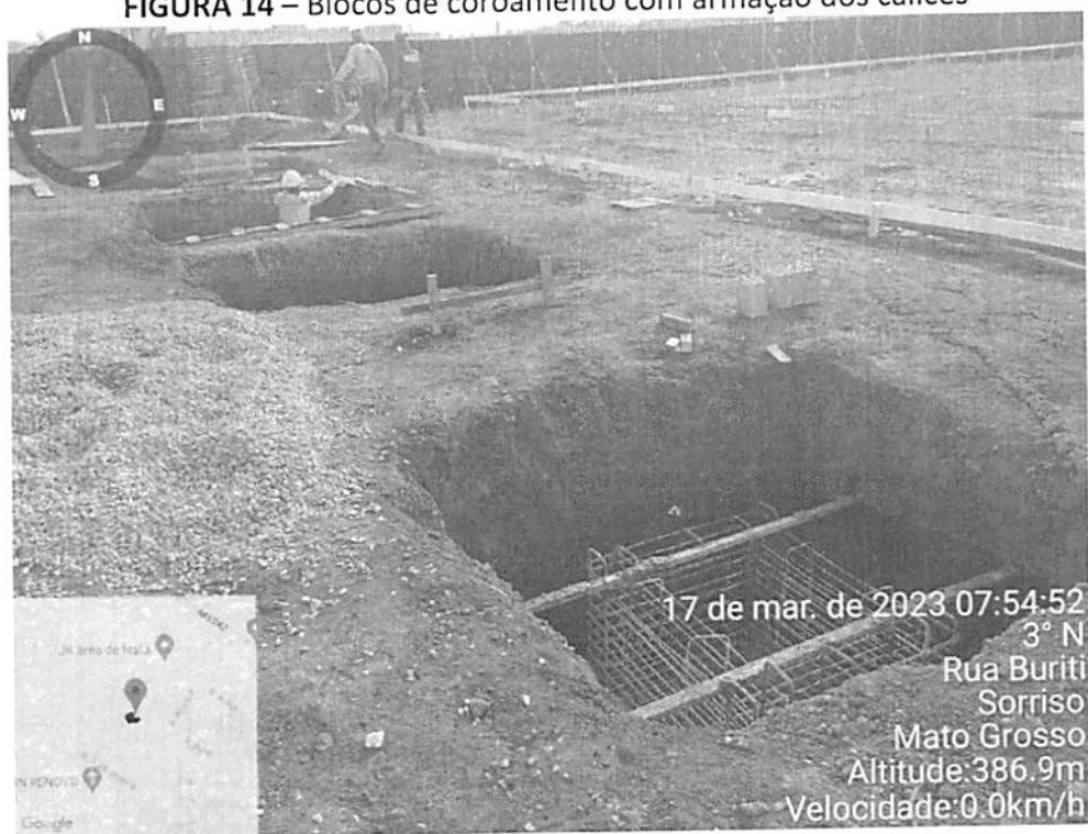
FIGURA 14 – Blocos de coroamento com armação dos cálices
