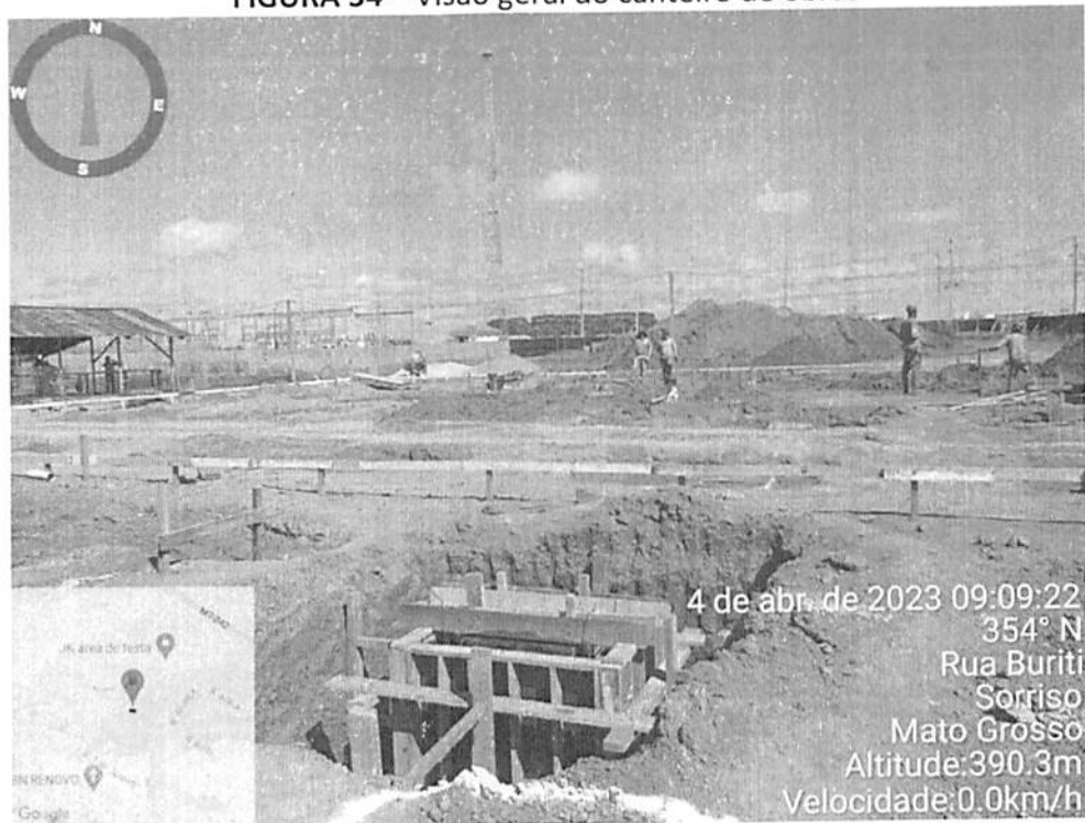
FIGURA 34 – Visão geral do canteiro de obras
