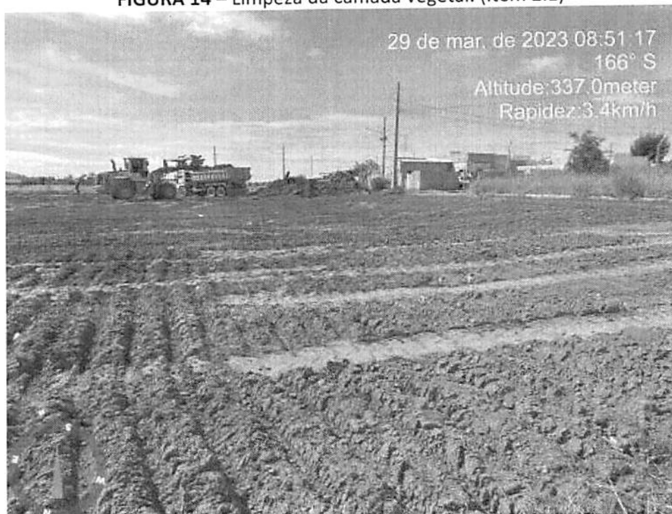
FIGURA 14 – Limpeza da camada vegetal. (Item 2.1)
