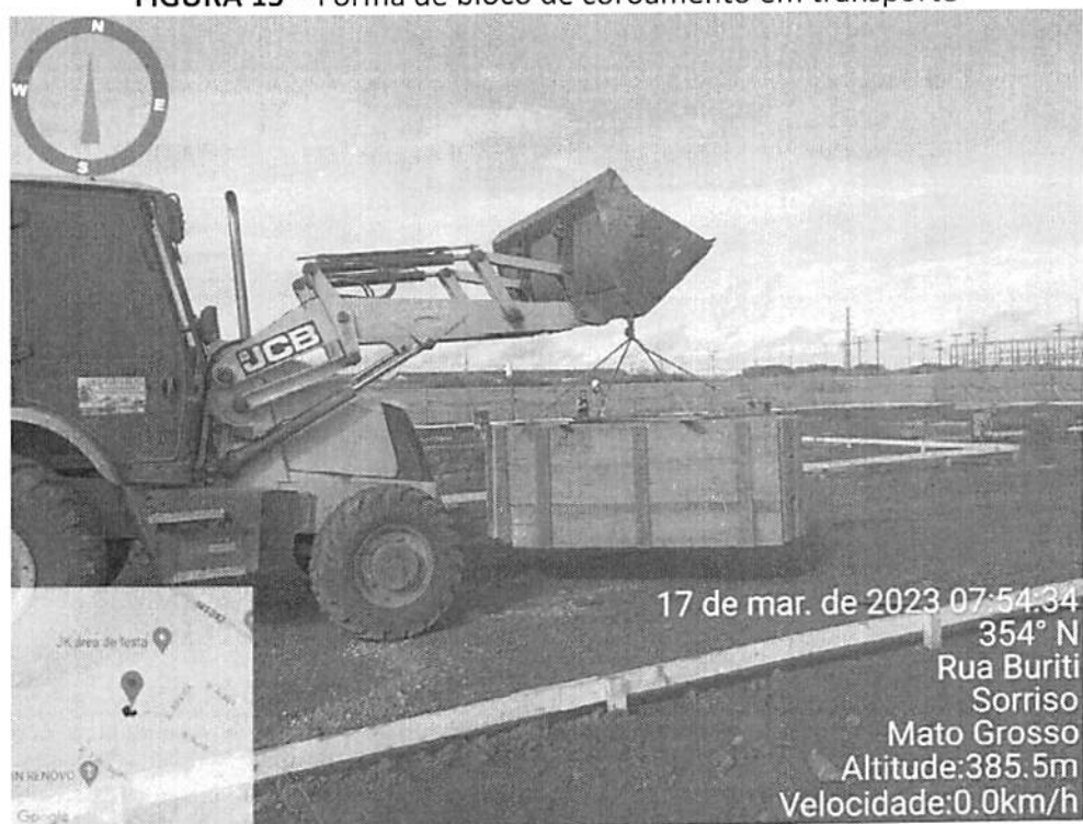
FIGURA 15 – Fôrma de bloco de coroamento em transporte
