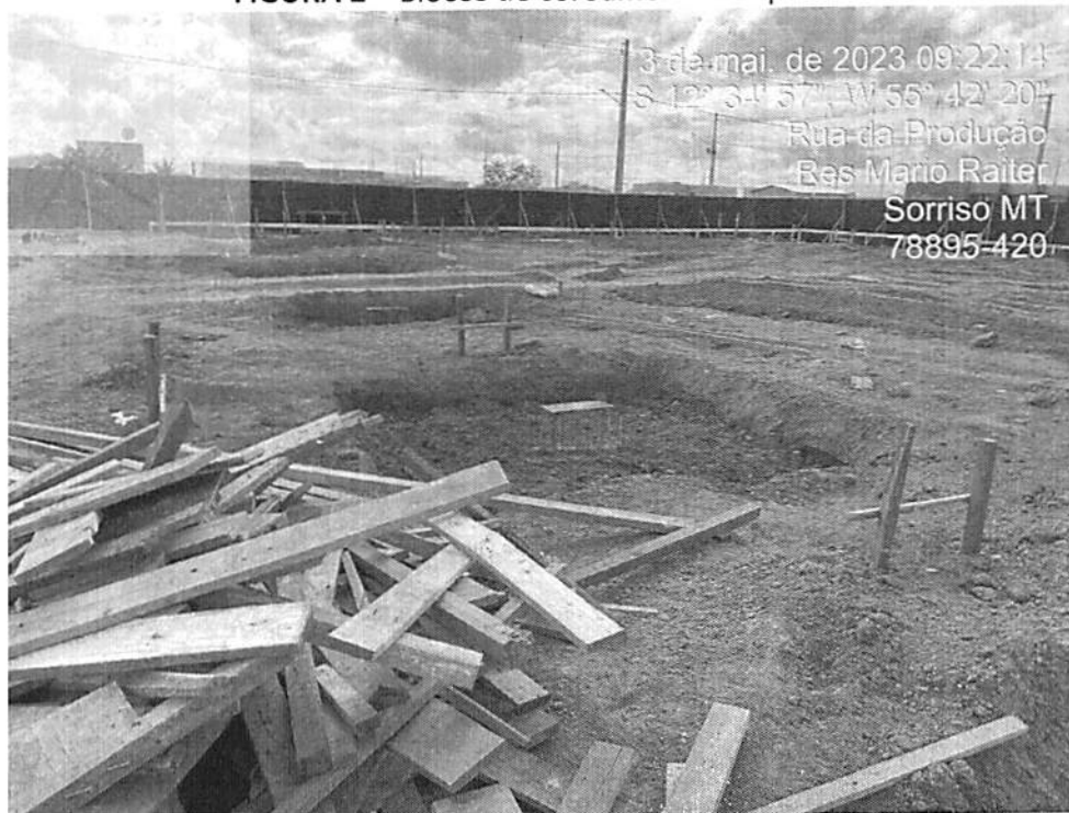
FIGURA 2 – Blocos de coroamento da quadra
