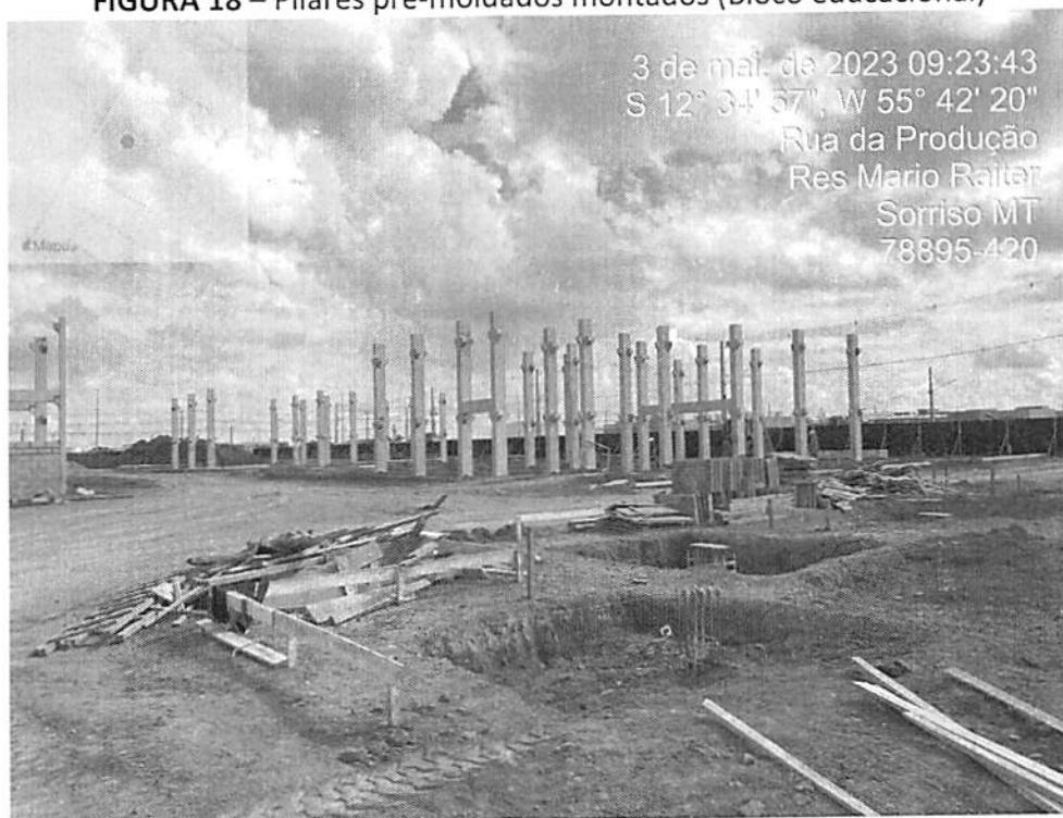
FIGURA 18 – Pilares pré-moldados montados (Bloco educacional)
