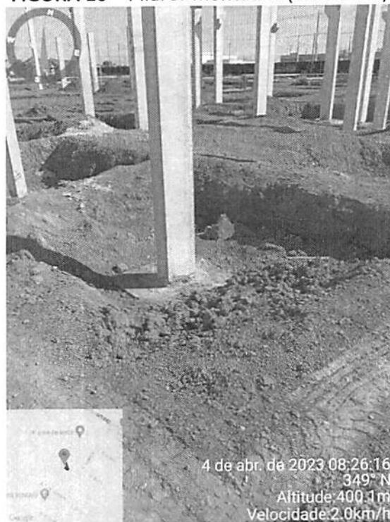
FIGURA 16 – Pilares montados (Refeitório)
