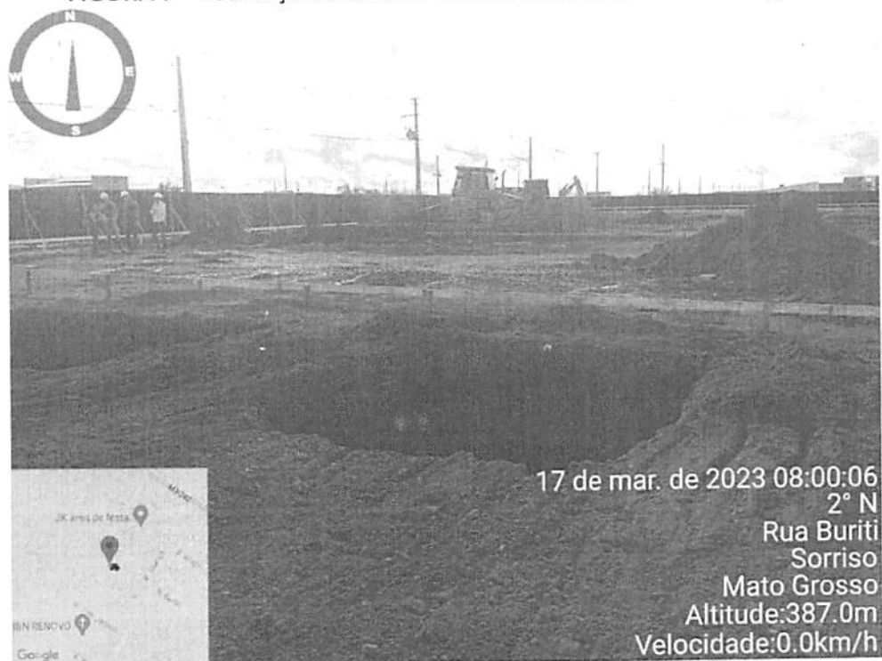
FIGURA 7 – Escavação de blocos de coroamento para concretagem
