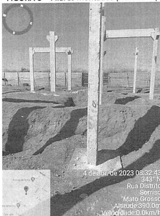
FIGURA 8 – Pilares montados (Refeitório)
