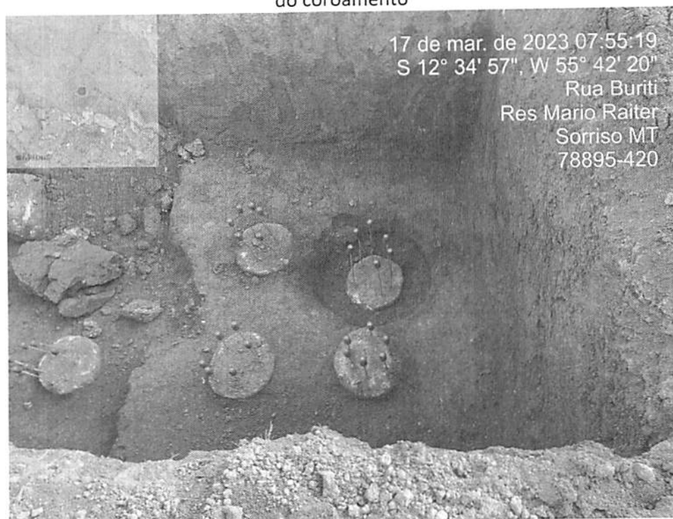
FIGURA 27 – Estacas concretadas e arrasadas com escavação para recebimento dos blocos do coroamento
