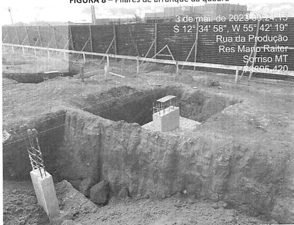
FIGURA 8 – Pilares de arranque da quadra
