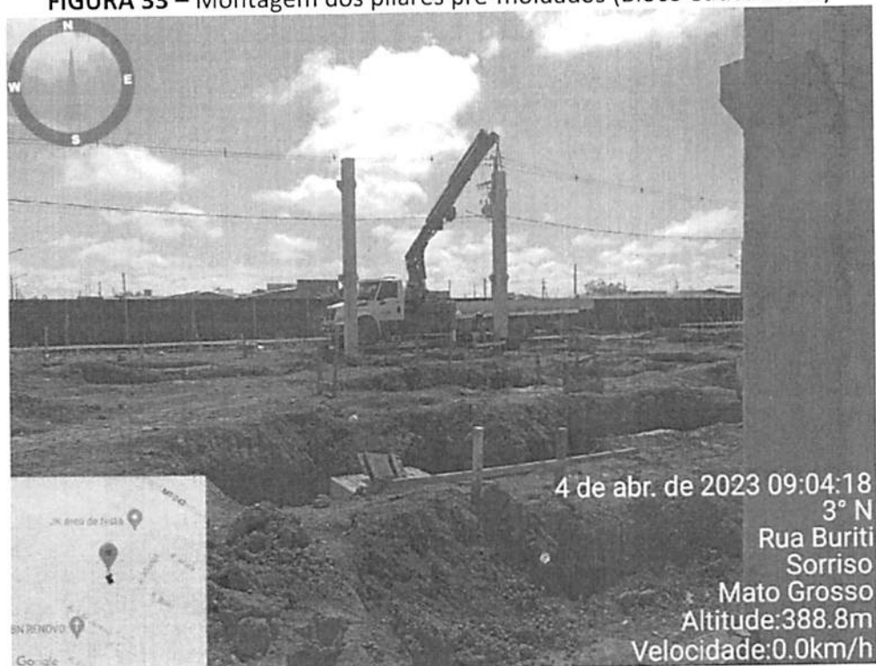
FIGURA 33 – Montagem dos pilares pré-moldados (Bloco educacional)
