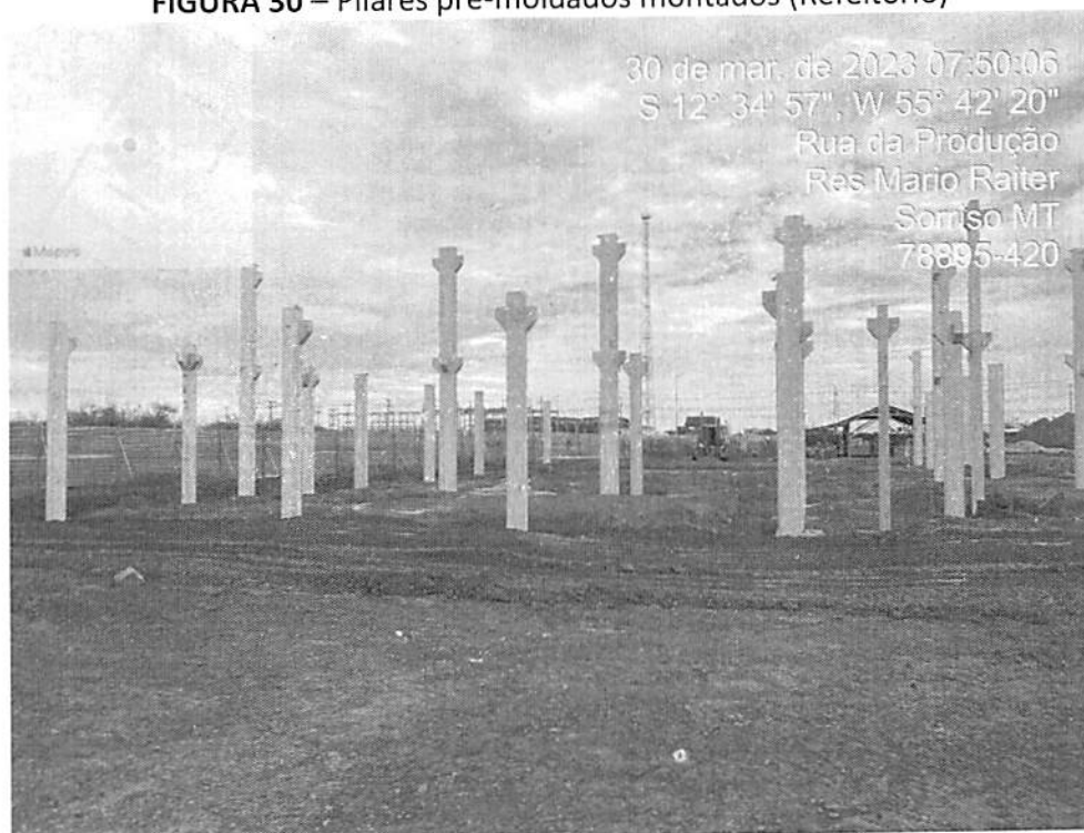
FIGURA 30 – Pilares pré-moldados montados (Refeitório)
