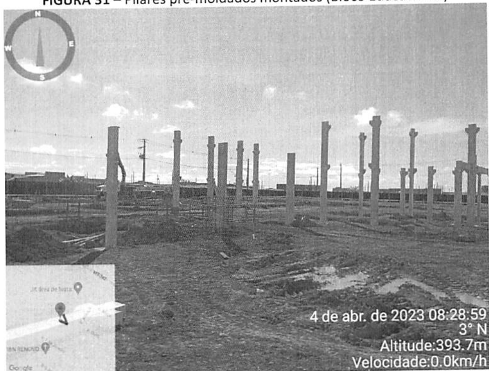
FIGURA 31 – Pilares pré-moldados montados (Bloco Educacional)
