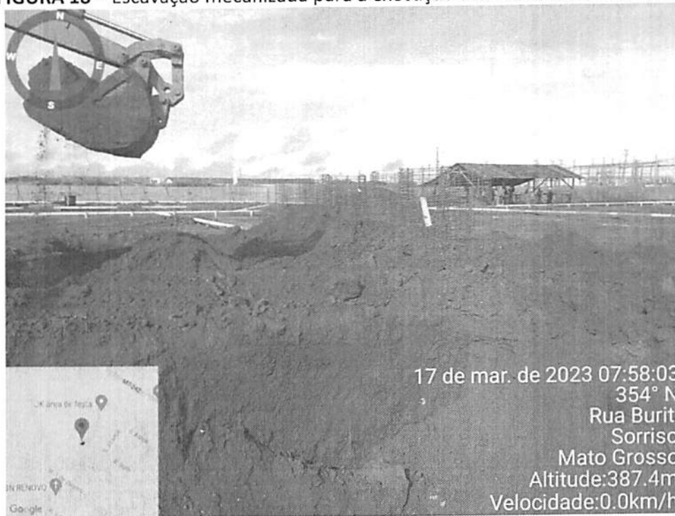
FIGURA 18 – Escavação mecanizada para a execução dos blocos de coroamento
