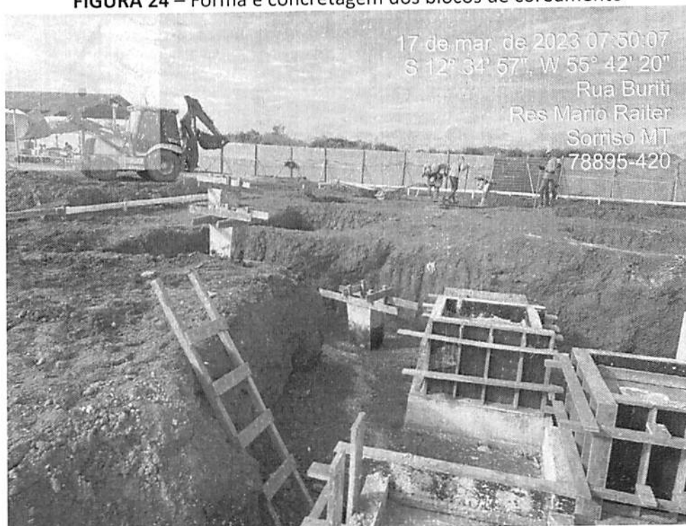
FIGURA 24 – Fôrma e concretagem dos blocos de coroamento
