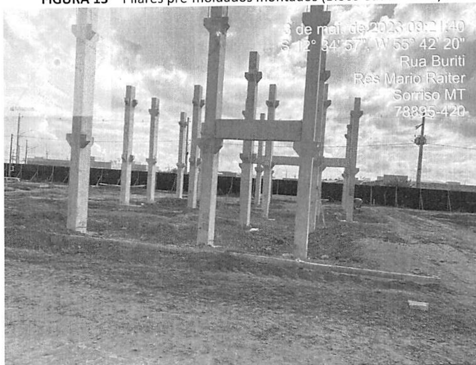
FIGURA 13 – Pilares pré-moldados montados (Bloco educacional)
