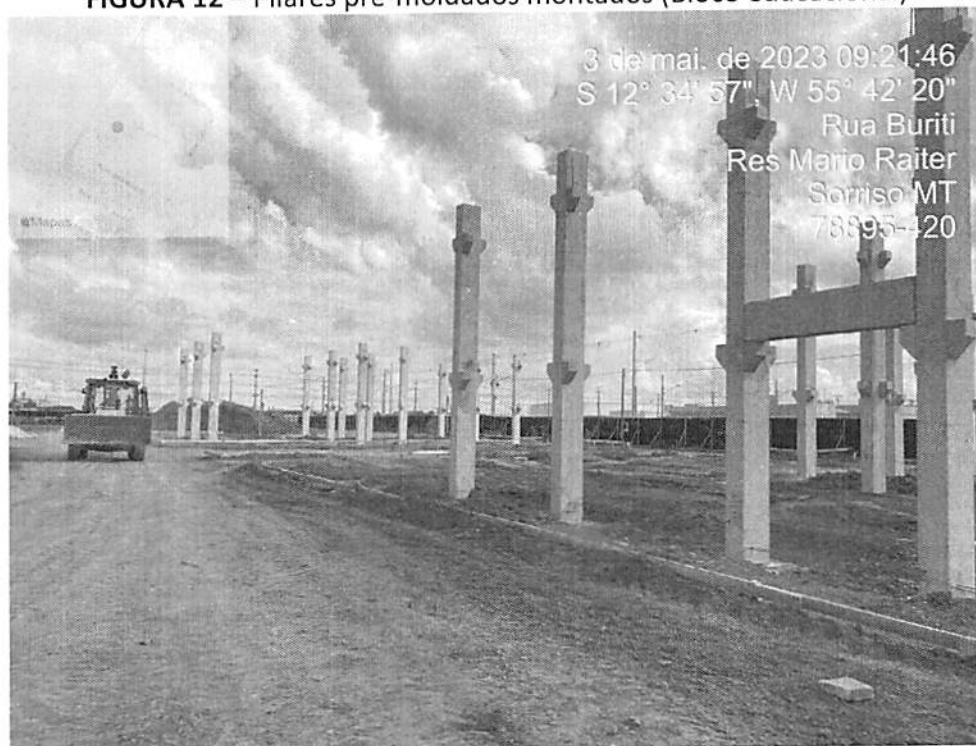
FIGURA 12 – Pilares pré-moldados montados (Bloco educacional)
