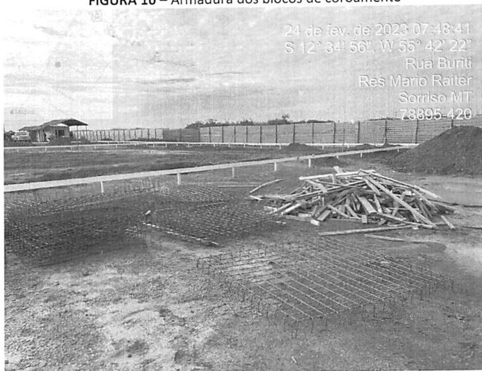
FIGURA 10 – Armadura dos blocos de coroamento
