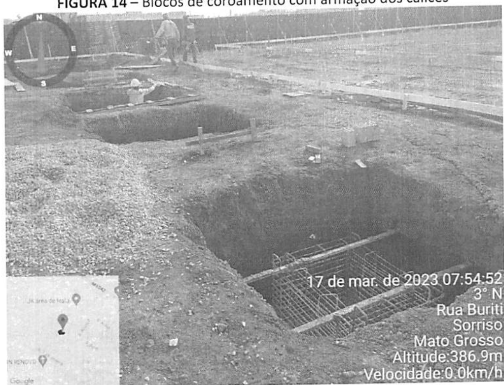
FIGURA 14 – Blocos de coroamento com armação dos cálices
