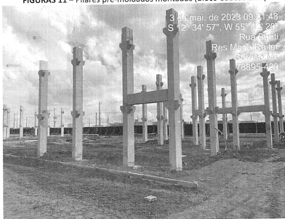
FIGURAS 11 – Pilares pré-moldados montados (Bloco educacional)
