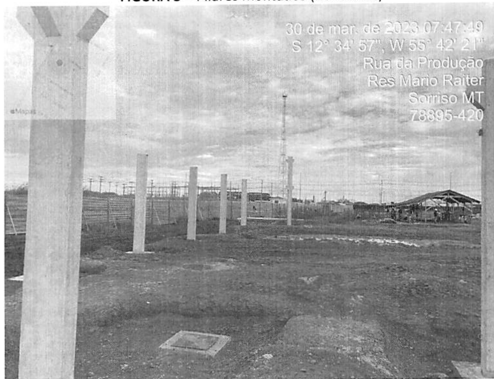
FIGURA 3 – Pilares montados (Refeitório)
