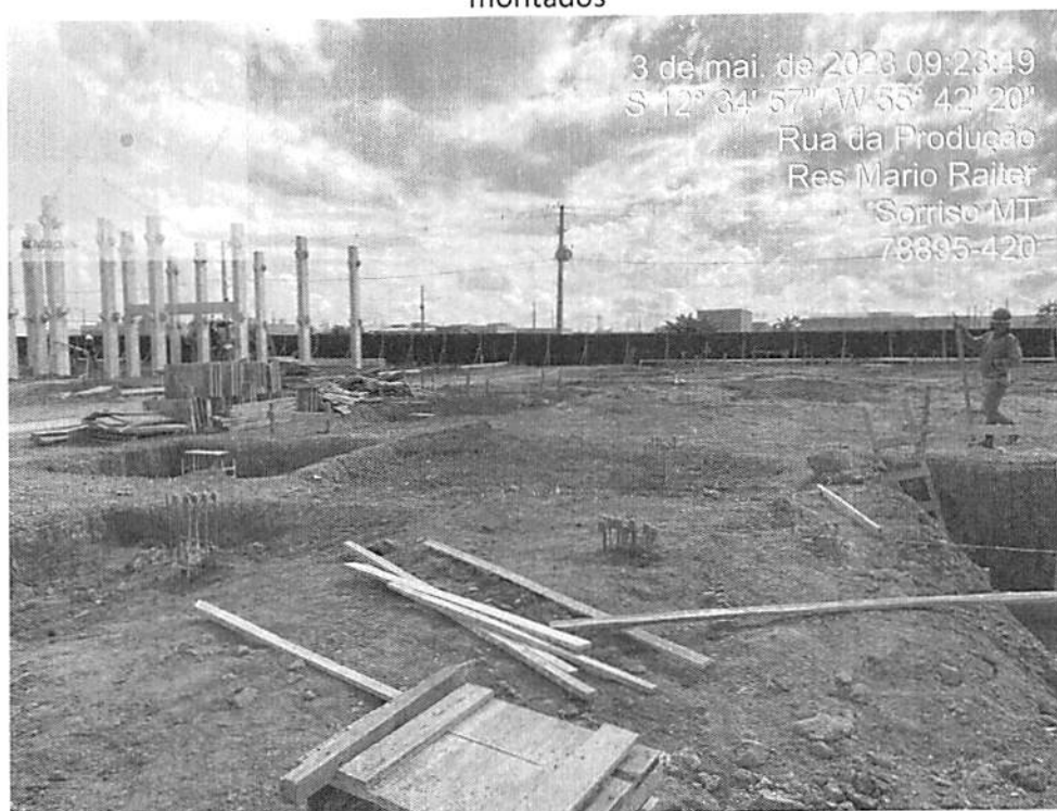
FIGURAS 10 – Pilares de arranque da quadra e pilares pré-moldados do bloco educacional montados
