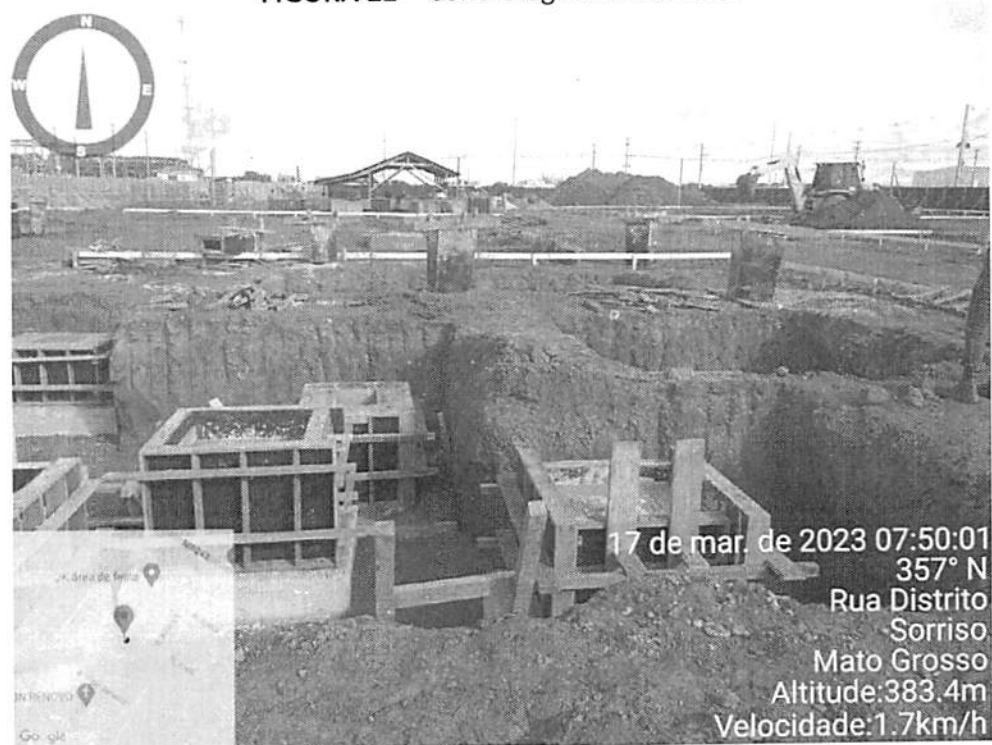
FIGURA 22 – Concretagem dos cálices
