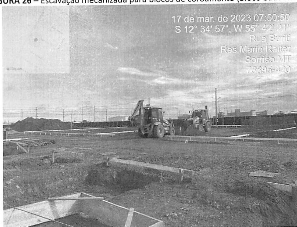
FIGURA 26 – Escavação mecanizada para blocos de coroamento (Bloco educacional)
