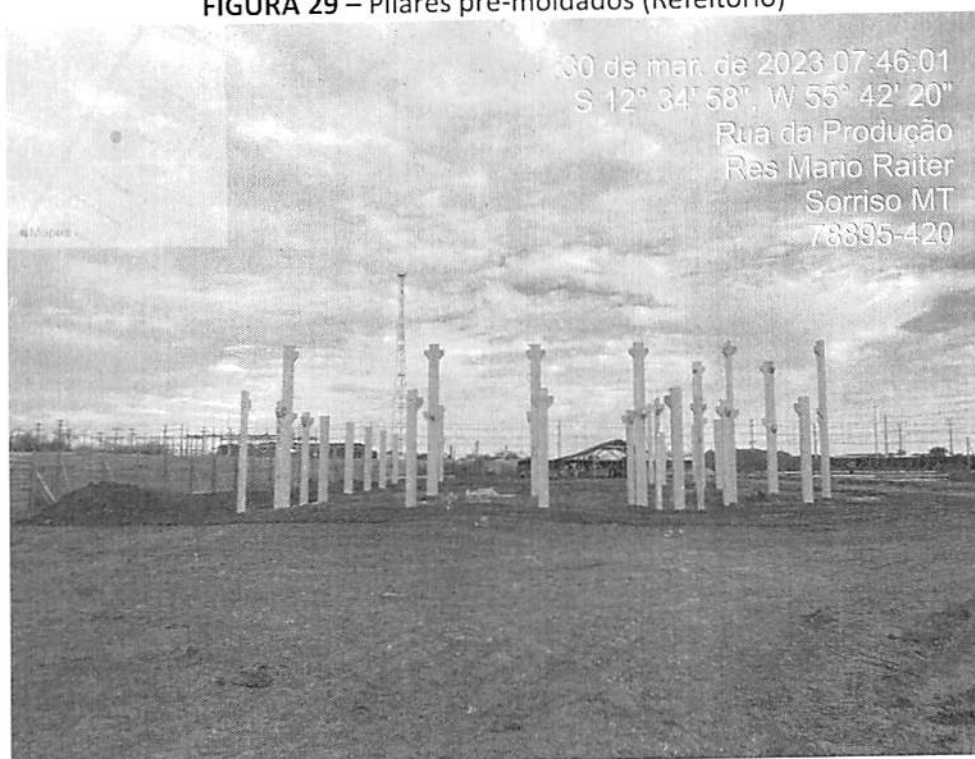
FIGURA 29 – Pilares pré-moldados (Refeitório)
