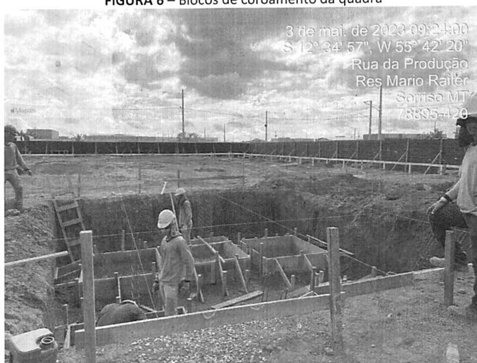
FIGURA 6 – Blocos de coroamento da quadra
