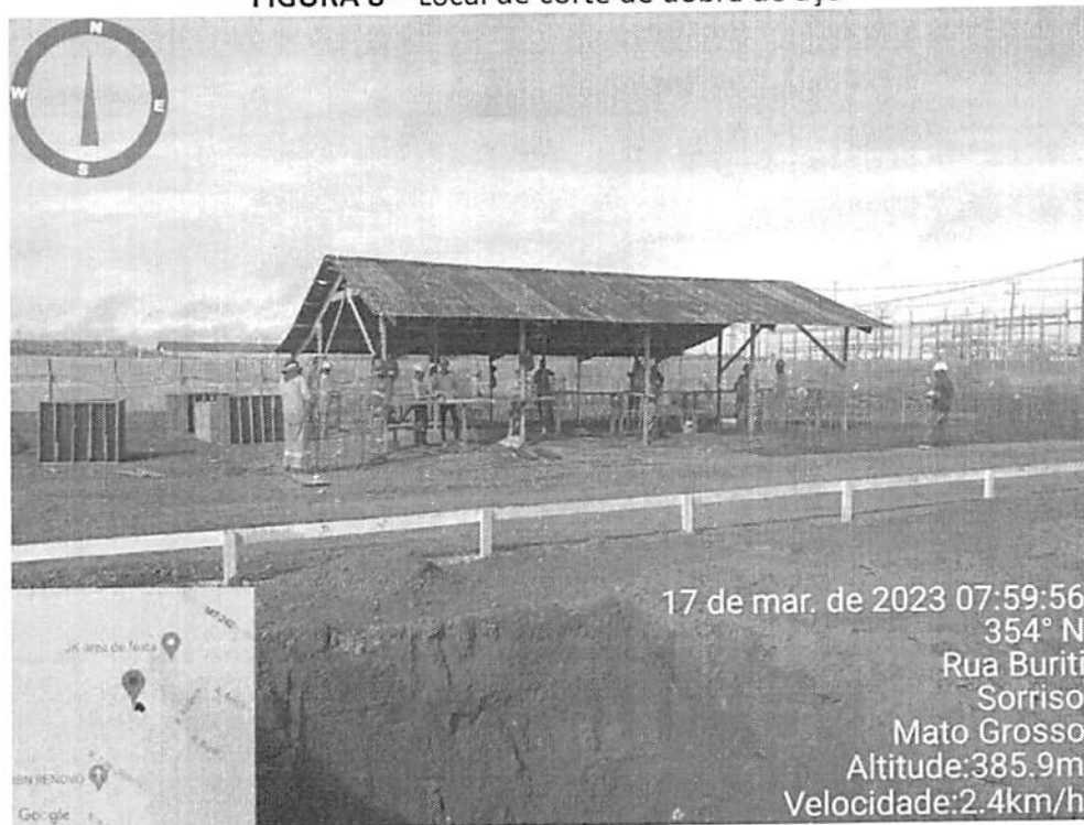
FIGURA 8 – Local de corte de dobra de aço
