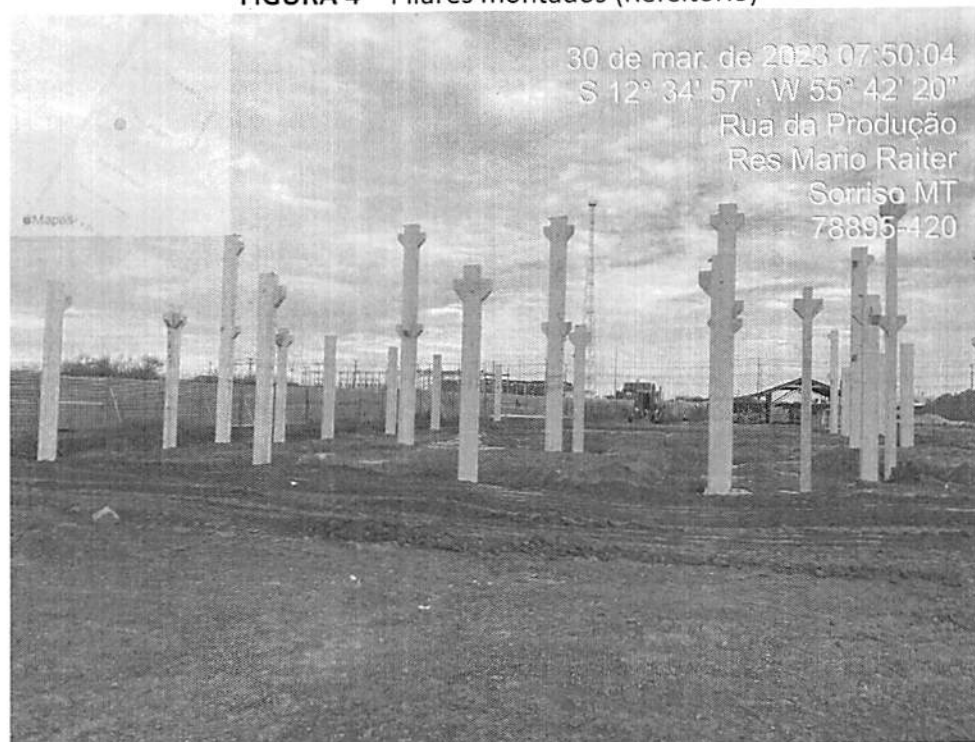
FIGURA 4 – Pilares montados (Refeitório)
