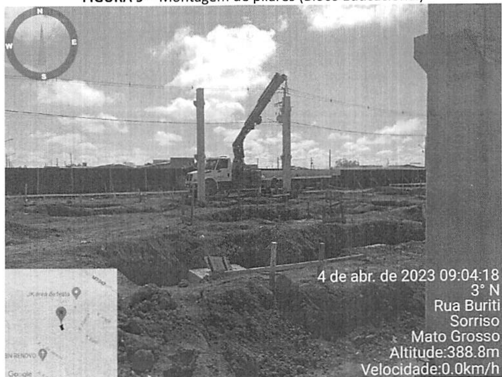
FIGURA 9 – Montagem de pilares (Bloco Educacional)
