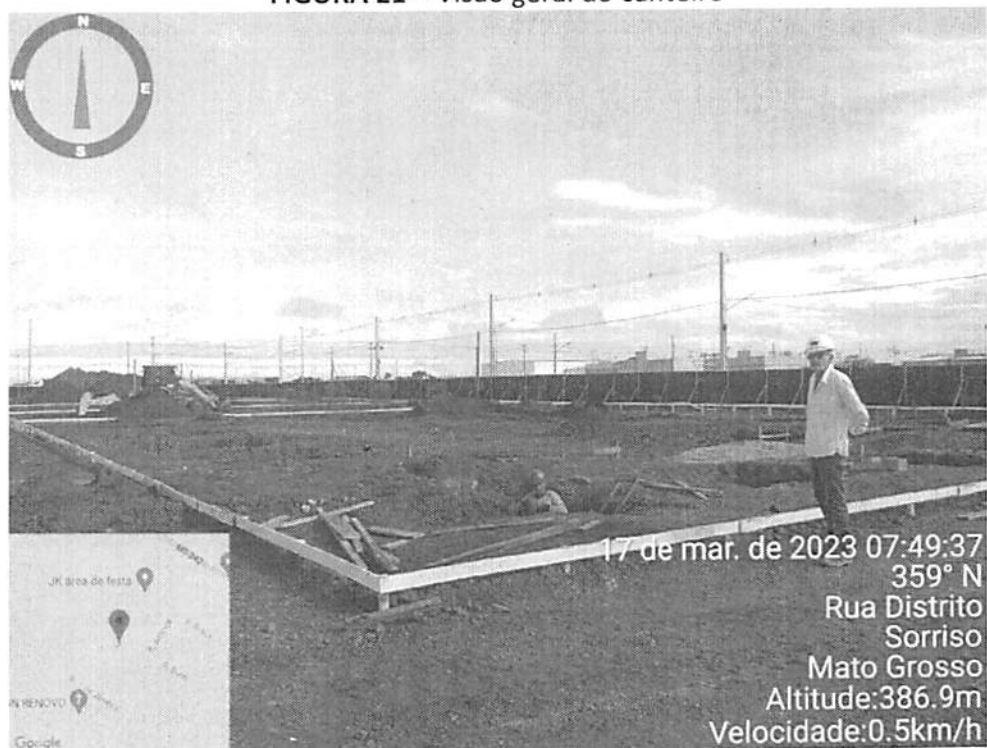
FIGURA 21 – Visão geral do canteiro
