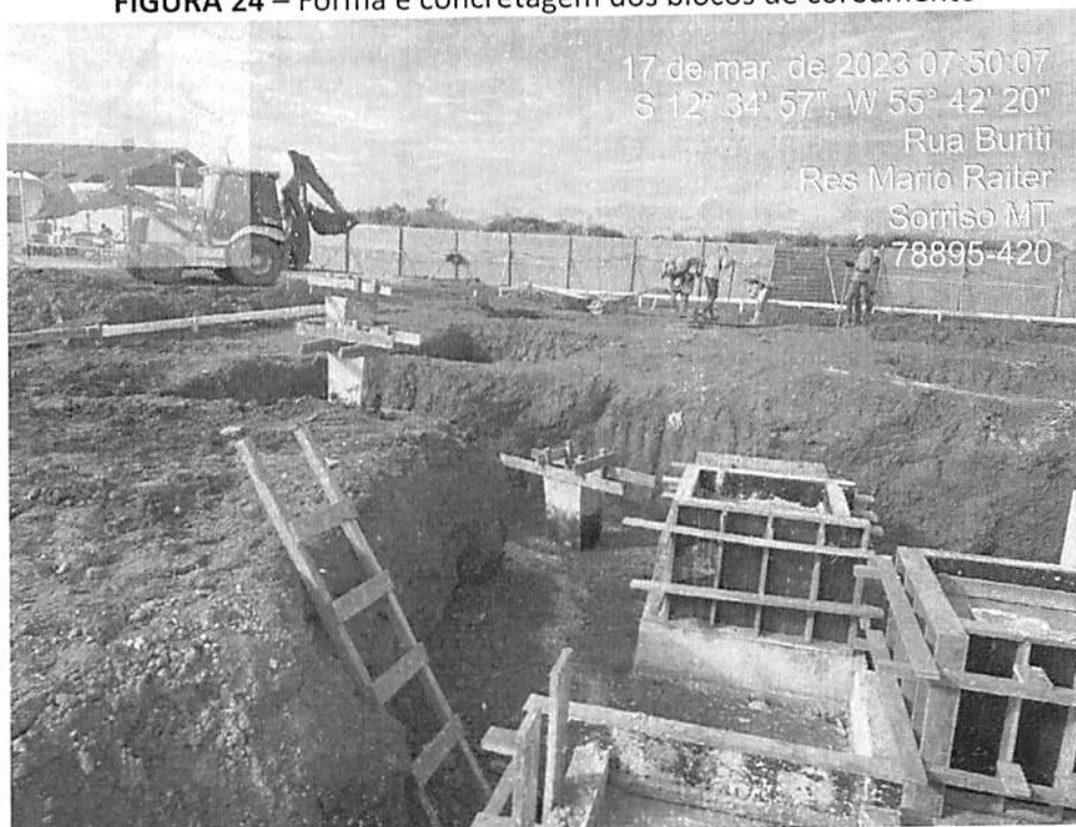
FIGURA 24 – Fôrma e concretagem dos blocos de coroamento
