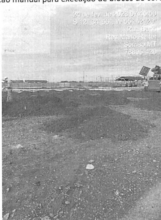
FIGURA 8 – Escavação manual para execução de blocos de coroamento (Refeitório)
