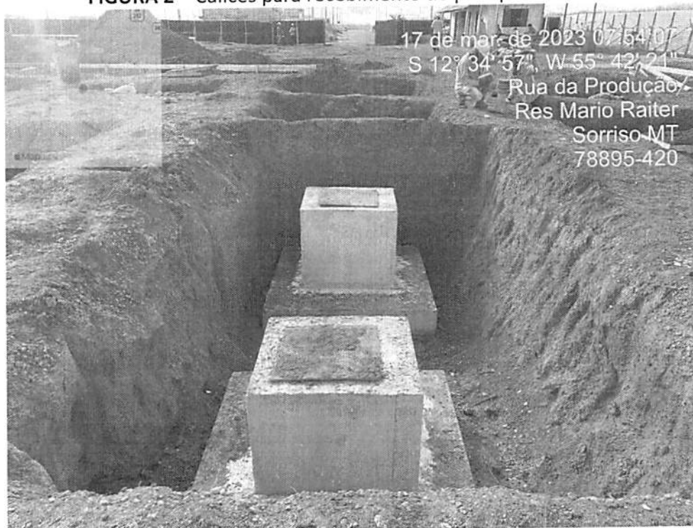
FIGURA 2 – Cálices para recebimento do pilar pré-moldado
