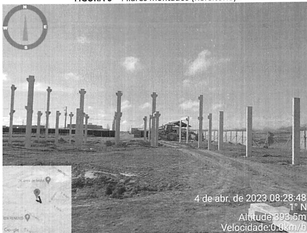
FIGURA 6 – Pilares montados (Refeitório)
