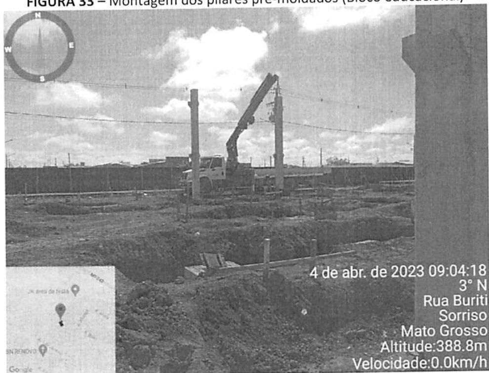
FIGURA 33 – Montagem dos pilares pré-moldados (Bloco educacional)
