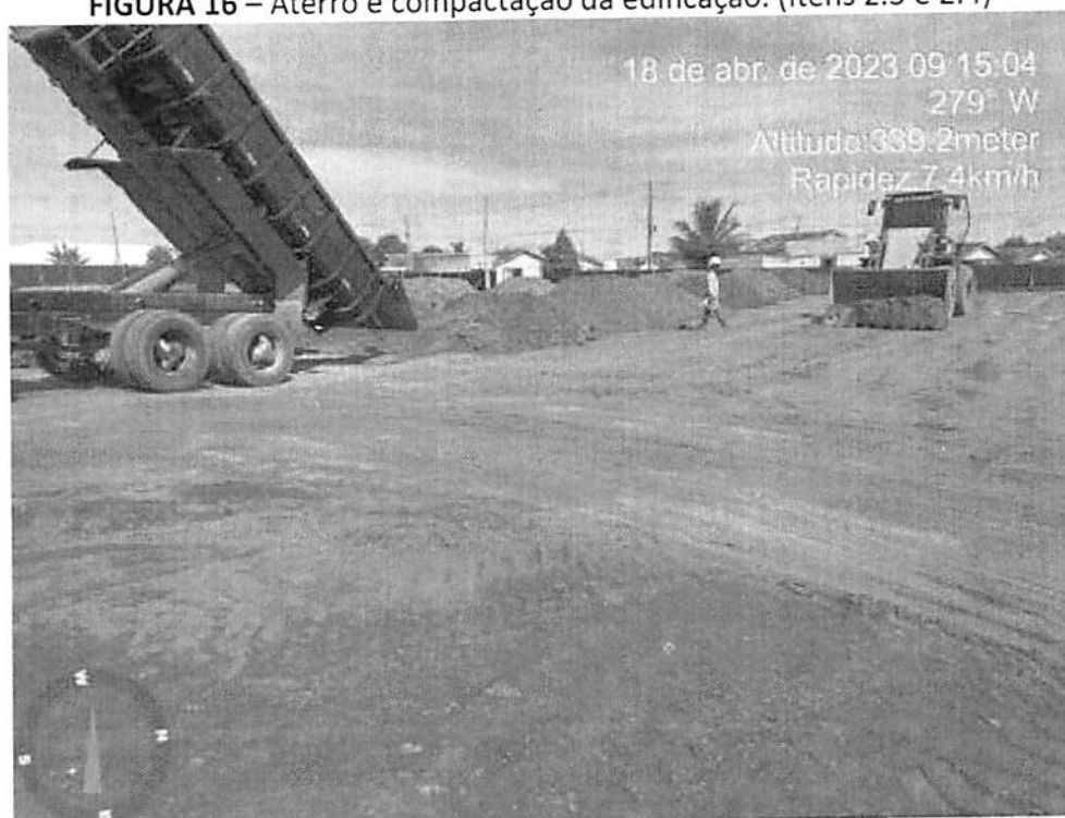
FIGURA 16 – Aterro e compactação da edificação. (Itens 2.3 e 2.4)
