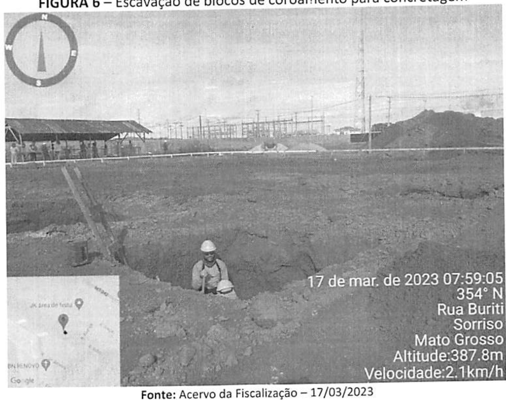
FIGURA 6 – Escavação de blocos de coroamento para concretagem
