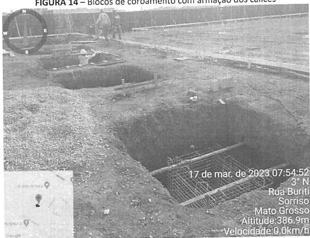
FIGURA 14 – Blocos de coroamento com armação dos cálices
