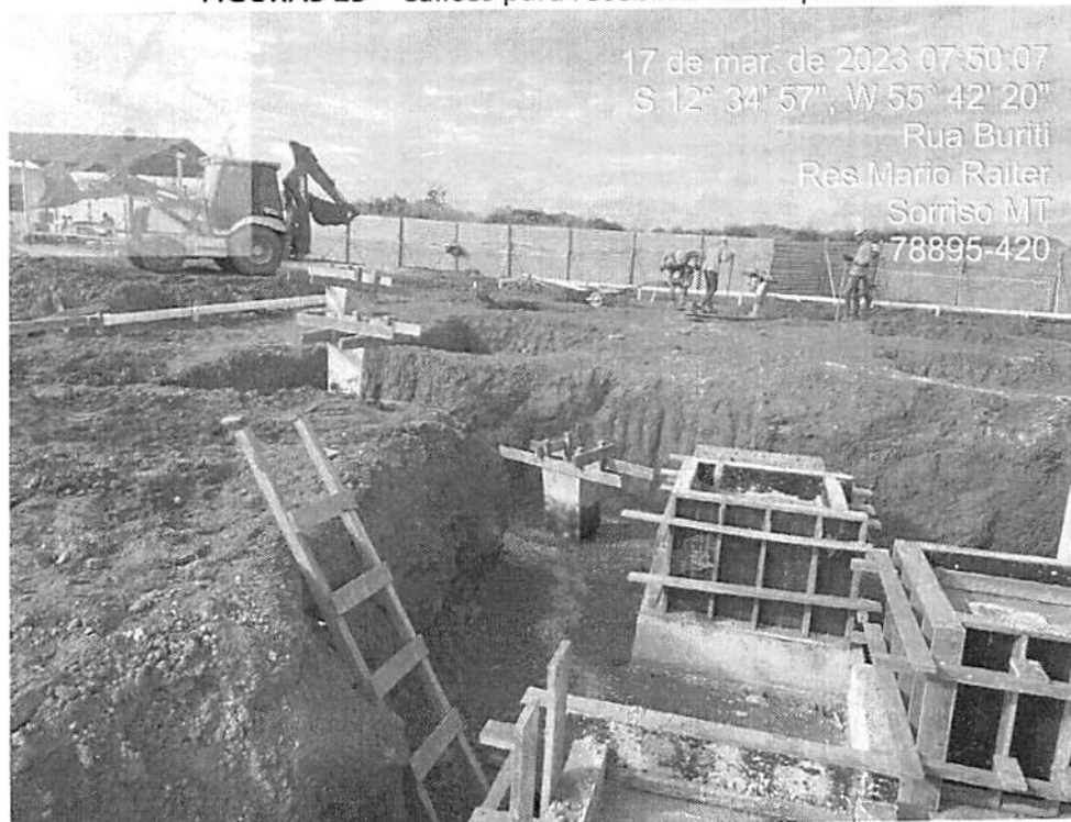
FIGURAS 25 – Cálices para recebimento de pilares
