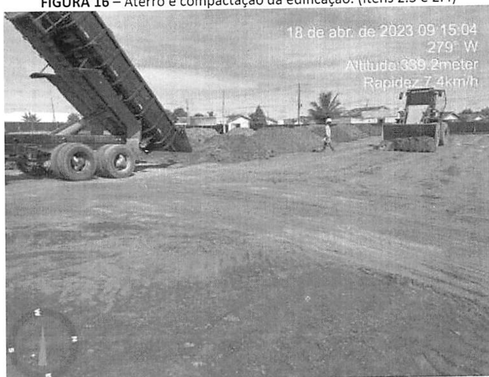
FIGURA 16 – Aterro e compactação da edificação. (Itens 2.3 e 2.4)
