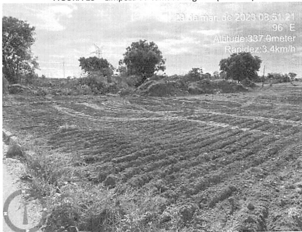
FIGURA 13 – Limpeza da camada vegetal. (Item 2.1)
