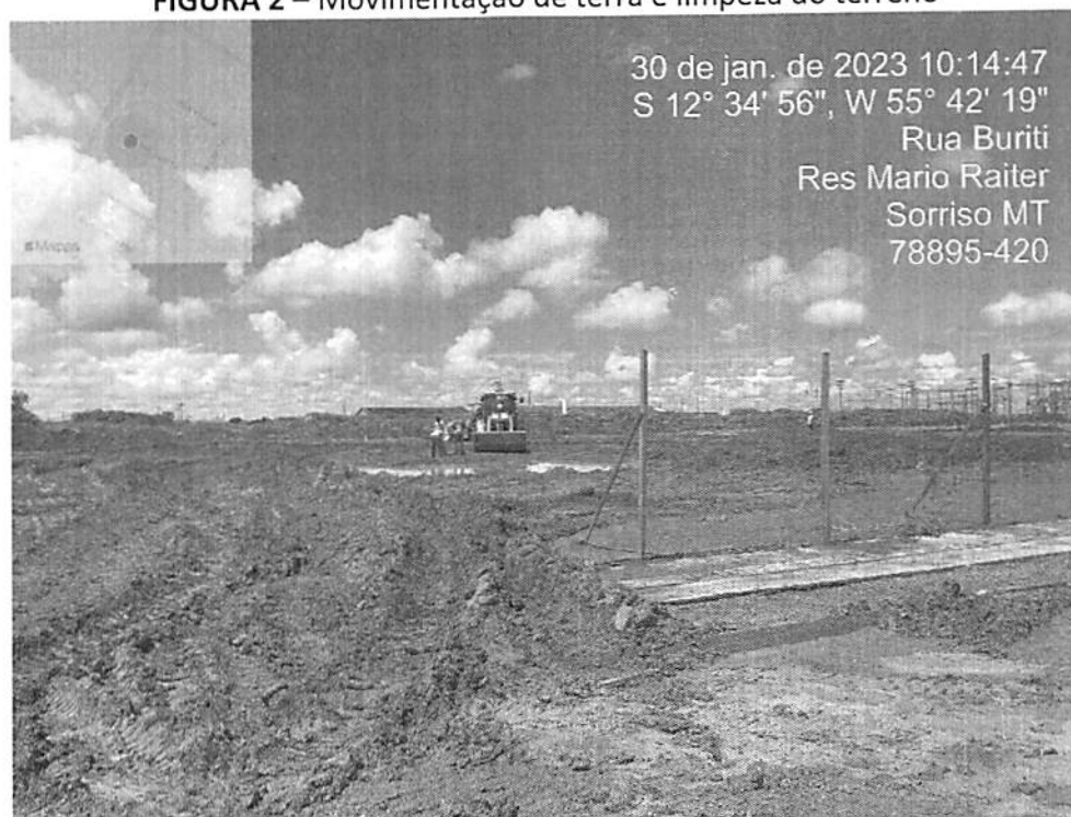
FIGURA 2 – Movimentação de terra e limpeza do terreno
