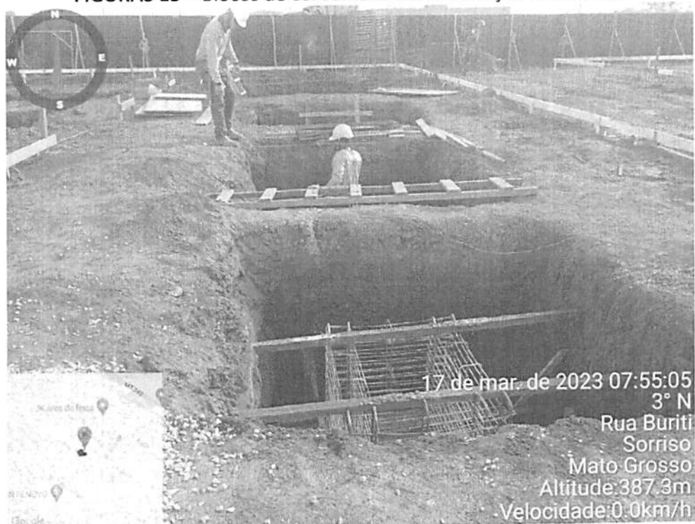
FIGURAS 13 – Blocos de coroamento com armação dos cálices
