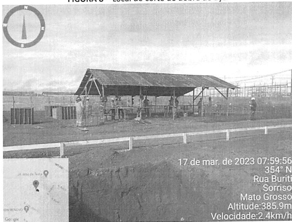
FIGURA 8 – Local de corte de dobra de aço
