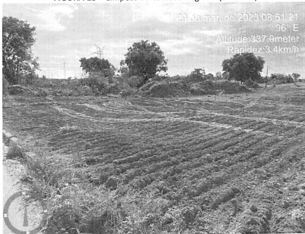
FIGURA 13 – Limpeza da camada vegetal. (Item 2.1)
