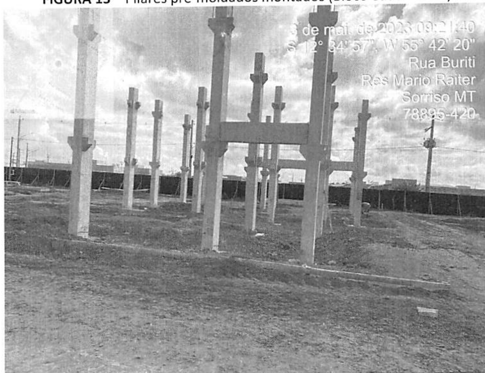
FIGURA 13 – Pilares pré-moldados montados (Bloco educacional)
