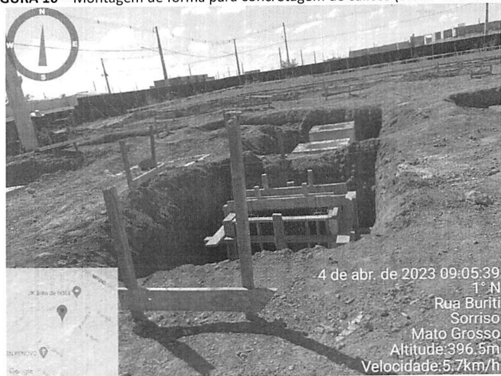
FIGURA 10 – Montagem de fôrma para concretagem de cálices (Bloco Educacional)
