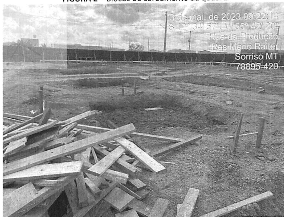
FIGURA 2 – Blocos de coroamento da quadra
