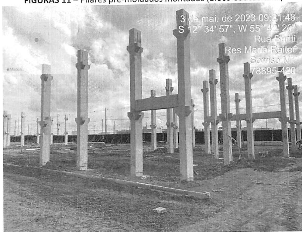
FIGURAS 11 – Pilares pré-moldados montados (Bloco educacional)
