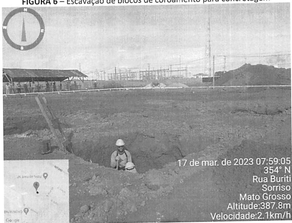
FIGURA 6 – Escavação de blocos de coroamento para concretagem
