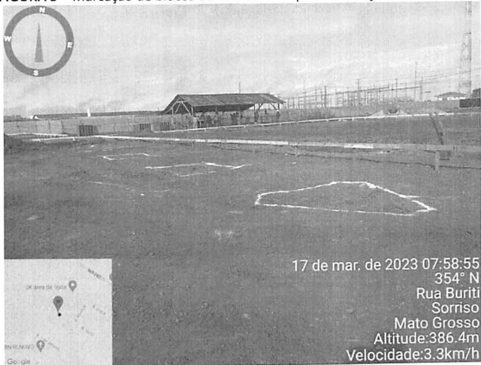
FIGURA 5 – Marcação de blocos de coroamento para escavação e concretagem
