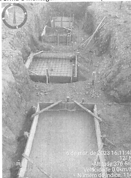
FIGURA 16 – Fôrma e montagem de armadura para blocos coroamento
