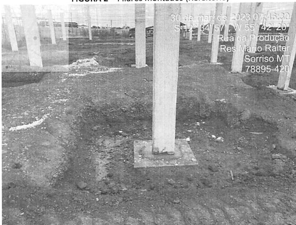
FIGURA 2 – Pilares montados (Refeitório)
