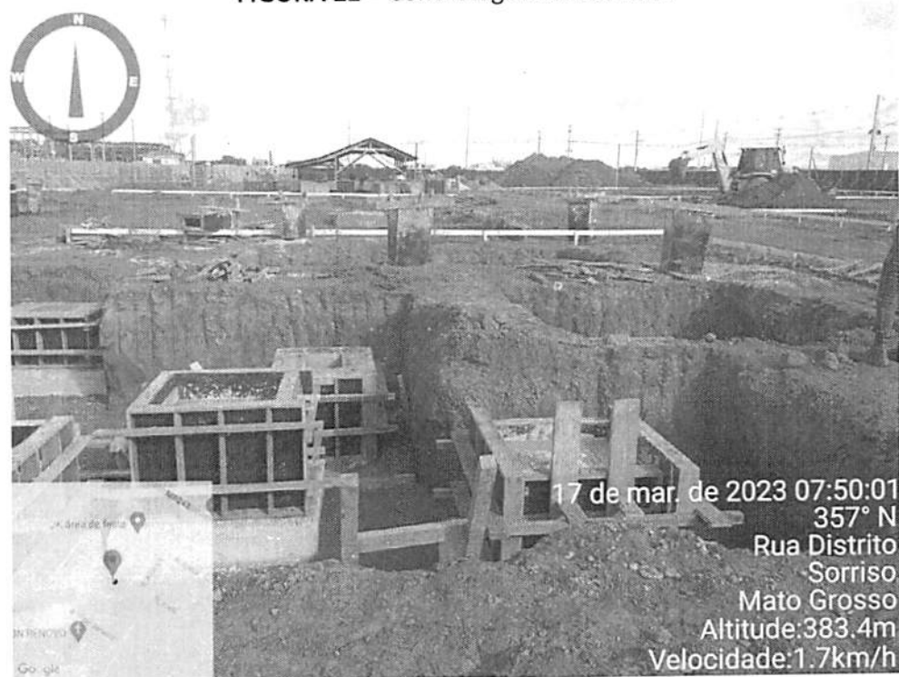
FIGURA 22 – Concretagem dos cálices
