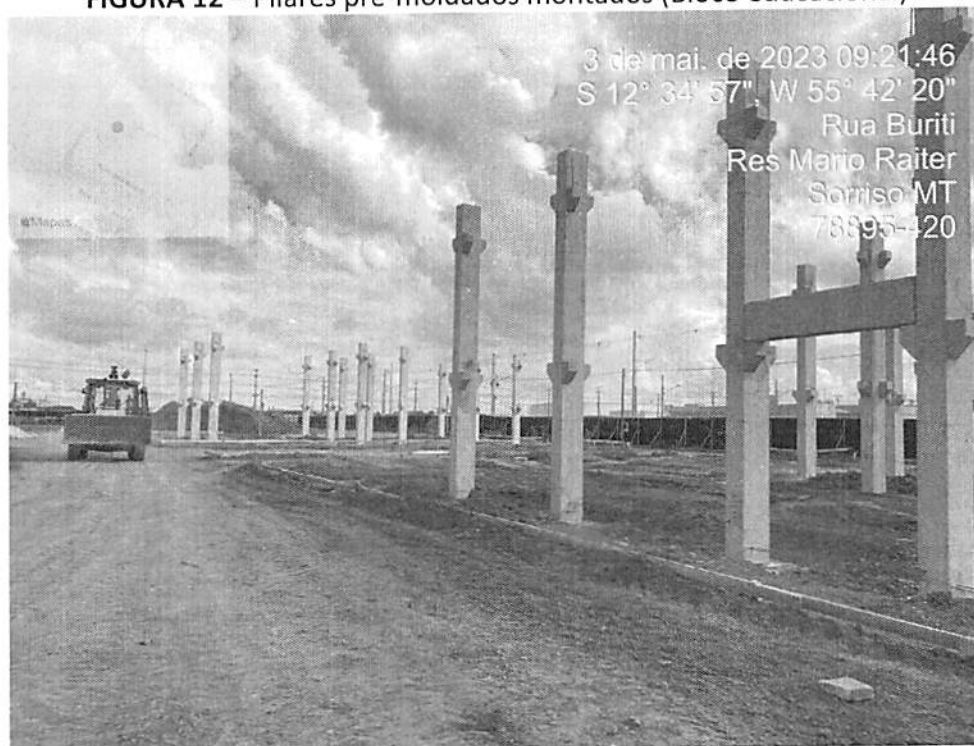
FIGURA 12 – Pilares pré-moldados montados (Bloco educacional)
