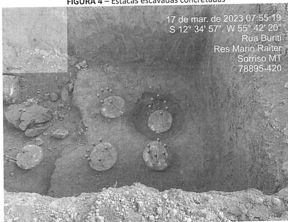
FIGURA 4 – Estacas escavadas concretadas
