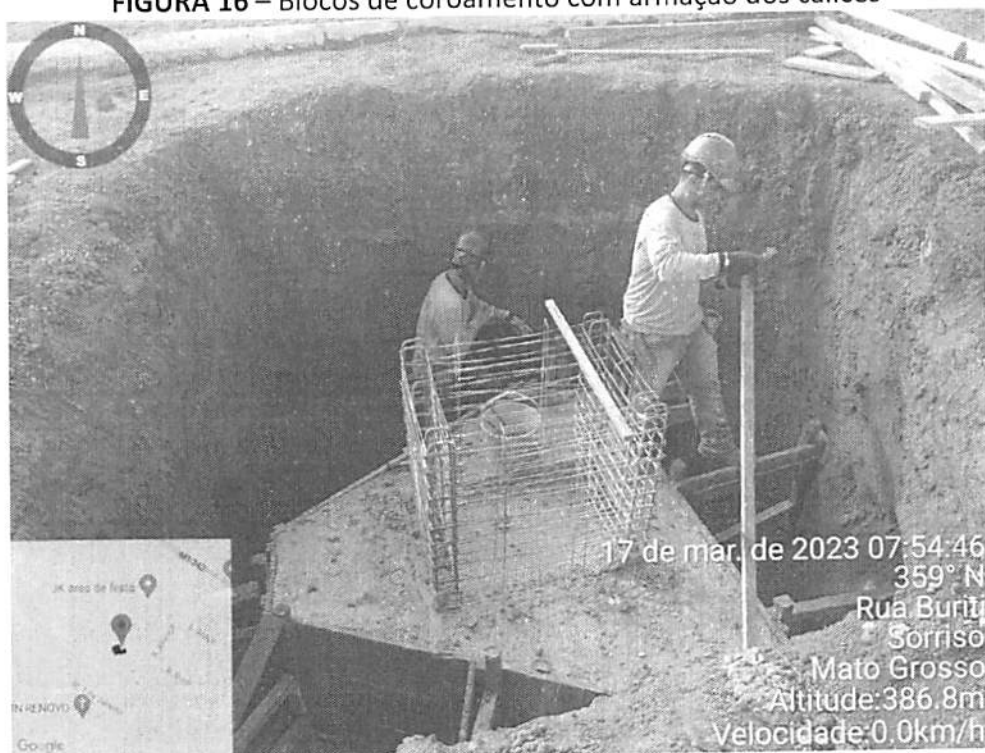
FIGURA 16 – Blocos de coroamento com armação dos cálices
