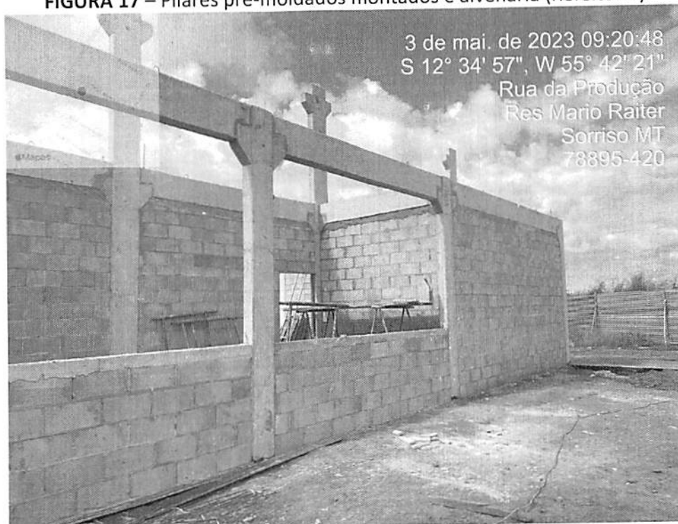
FIGURA 17 – Pilares pré-moldados montados e alvenaria (Refeitório)
