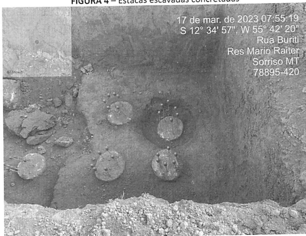
FIGURA 4 – Estacas escavadas concretadas
