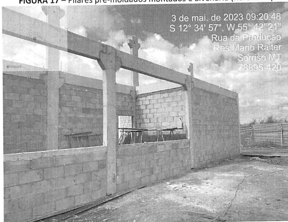
FIGURA 17 – Pilares pré-moldados montados e alvenaria (Refeitório)
