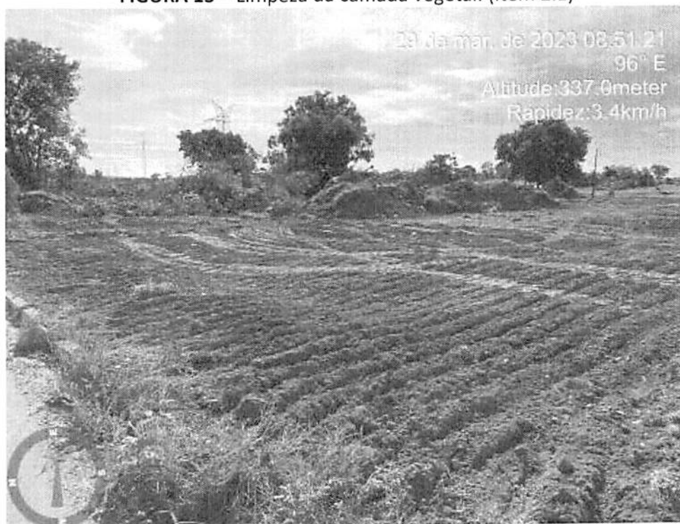
FIGURA 13 – Limpeza da camada vegetal. (Item 2.1)
