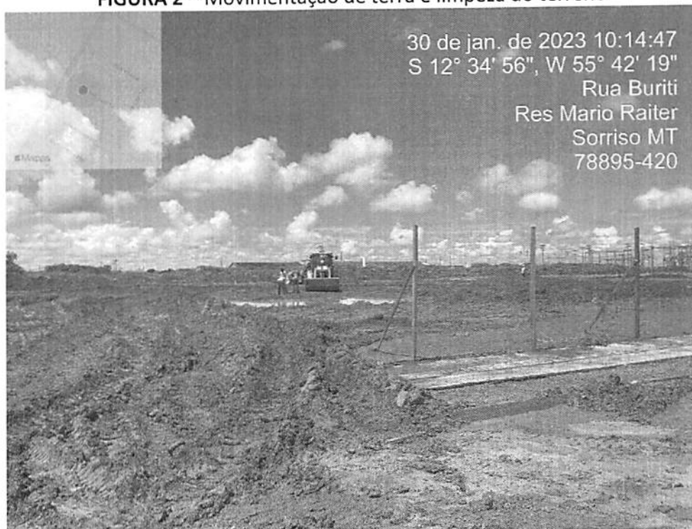
FIGURA 2 – Movimentação de terra e limpeza do terreno
