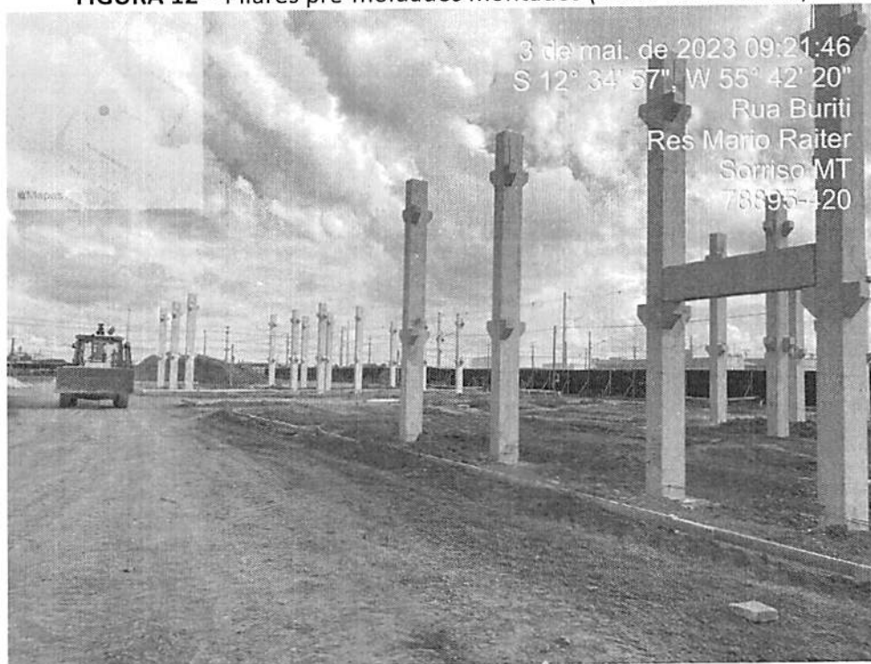
FIGURA 12 – Pilares pré-moldados montados (Bloco educacional)
