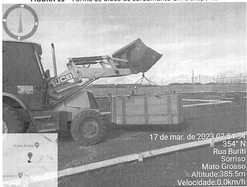
FIGURA 15 – Fôrma de bloco de coroamento em transporte
