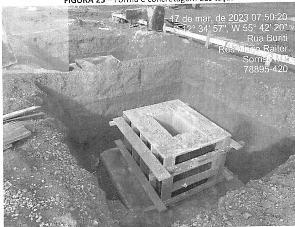
FIGURA 23 – Fôrma e concretagem das taças
