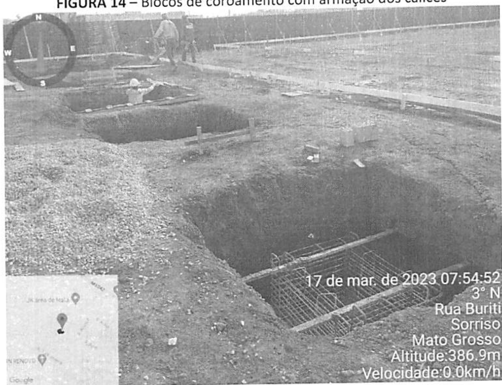
FIGURA 14 – Blocos de coroamento com armação dos cálices
