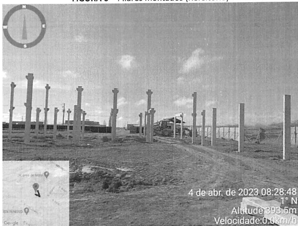
FIGURA 6 – Pilares montados (Refeitório)
