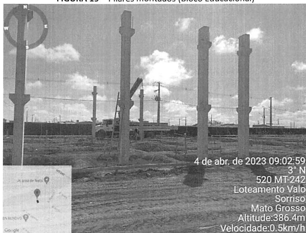
FIGURA 19 – Pilares montados (Bloco Educacional)
