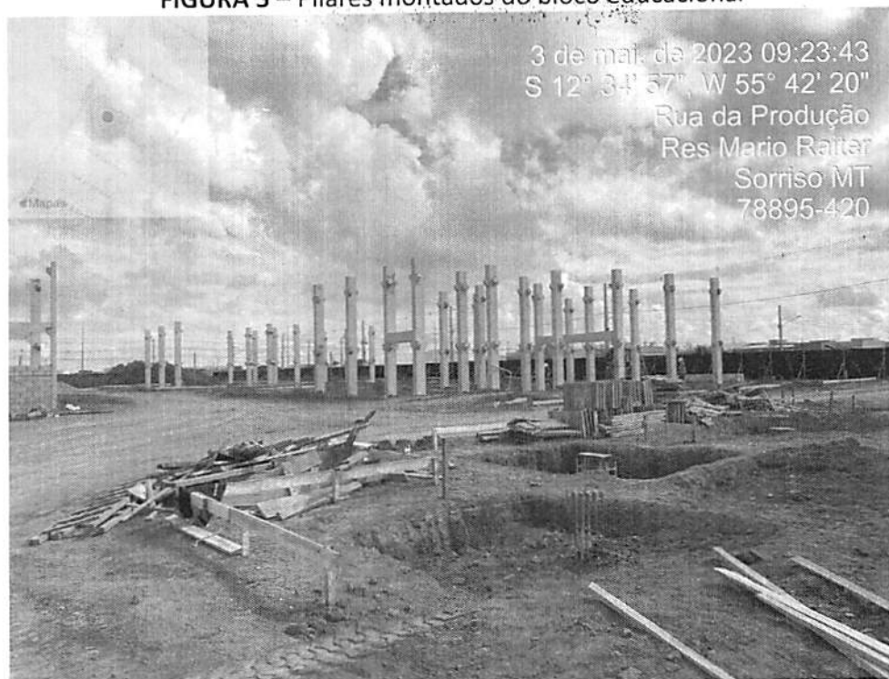
FIGURA 5 – Pilares montados do bloco educacional
