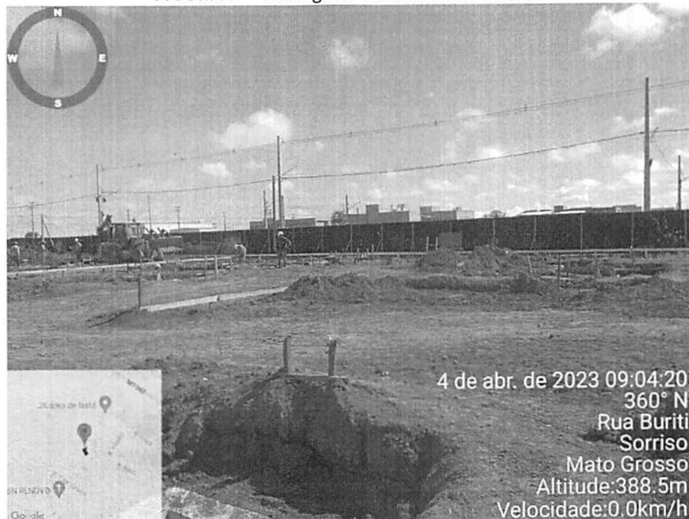
FIGURA 7 – Visão geral do canteiro de obras
