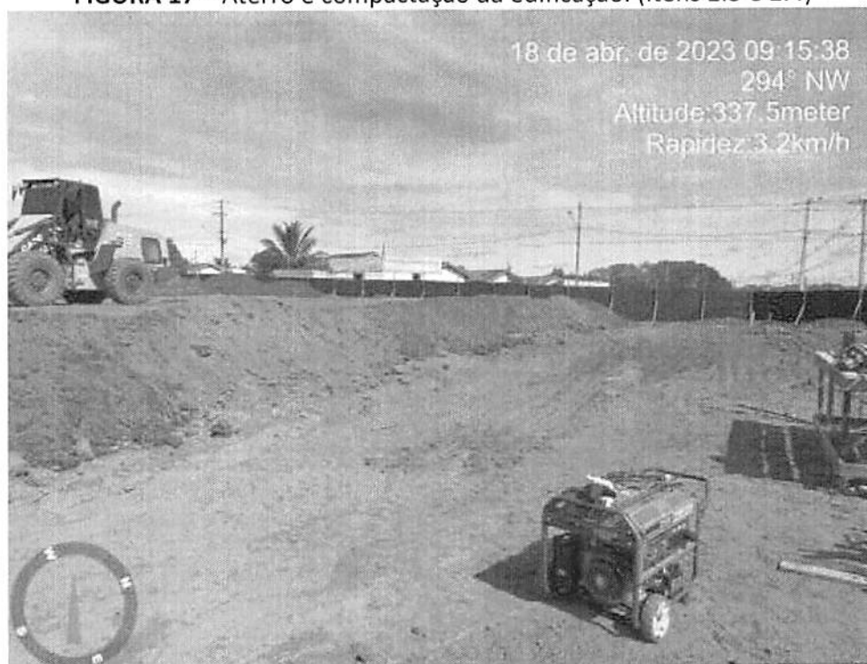
FIGURA 17 – Aterro e compactação da edificação. (Itens 2.3 e 2.4)
