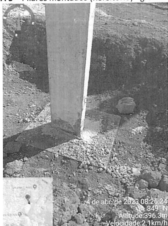
FIGURA 5 – Pilares montados (Refeitório) - grauteamento
