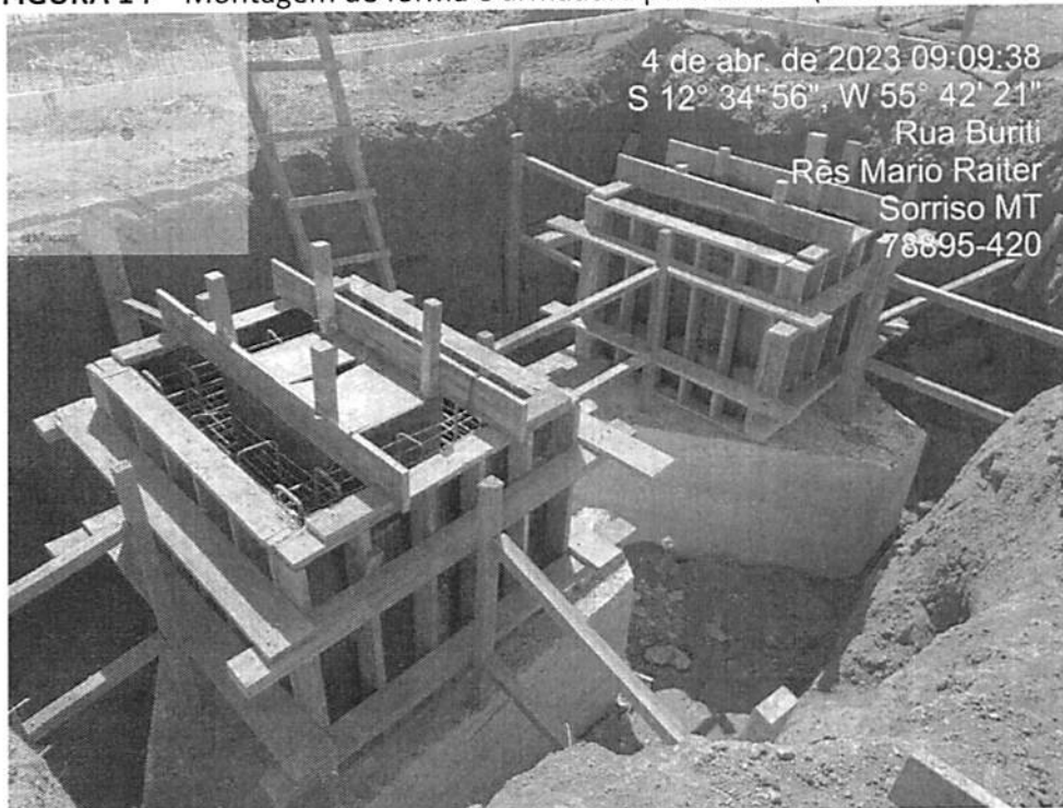
FIGURA 14 – Montagem de fôrma e armadura para cálices (Bloco Educacional)
