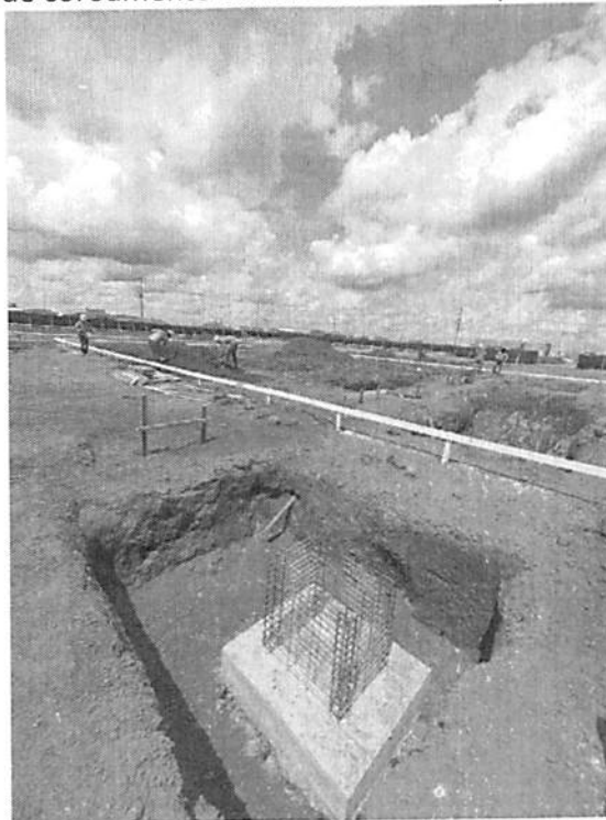
FIGURA 15 – Blocos de coroamento concretados com espera da armadura para taças
