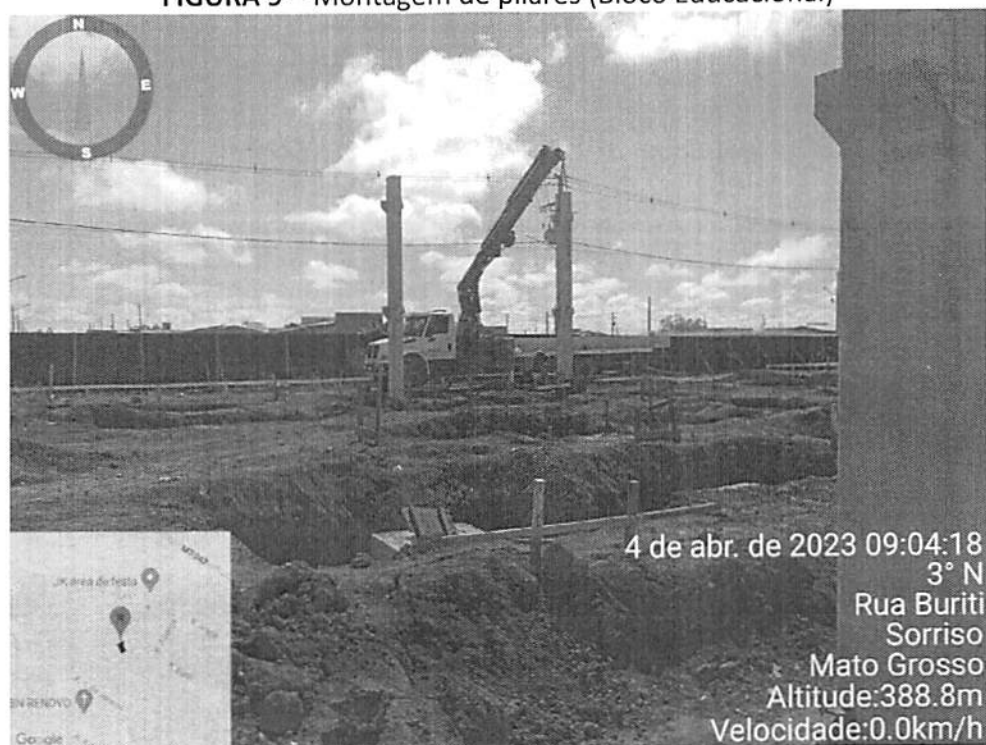
FIGURA 9 – Montagem de pilares (Bloco Educacional)
