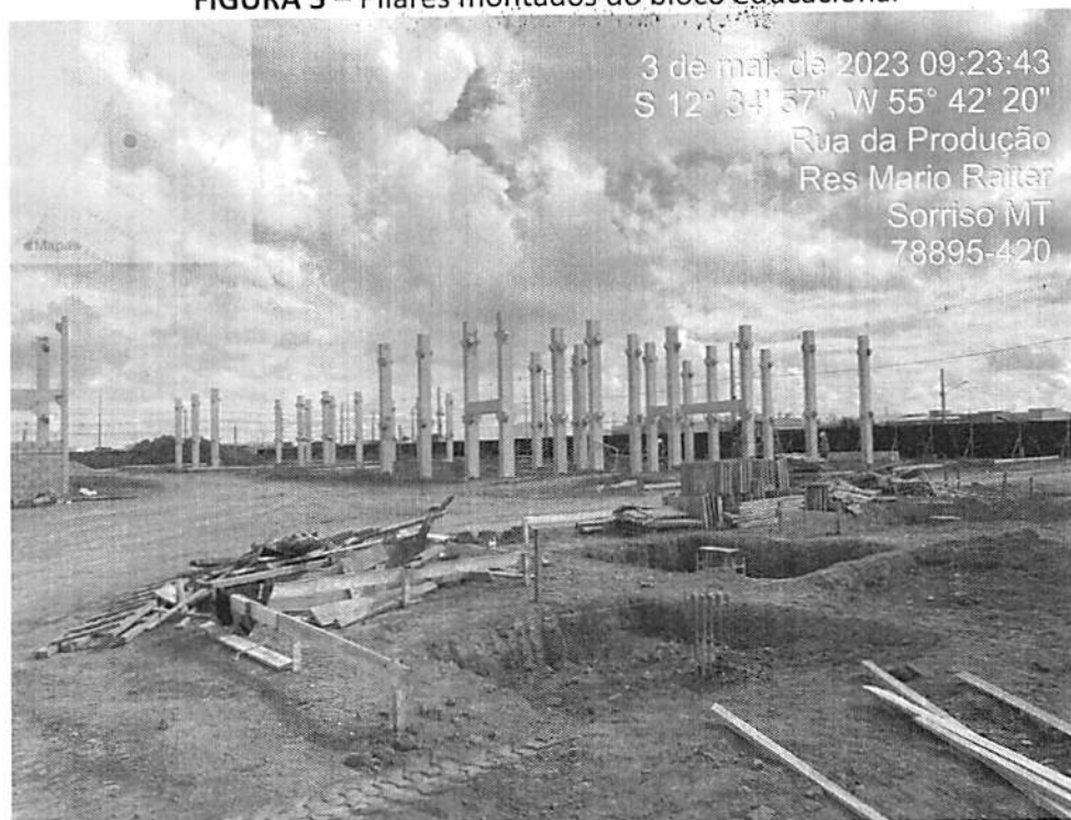
FIGURA 5 – Pilares montados do bloco educacional
