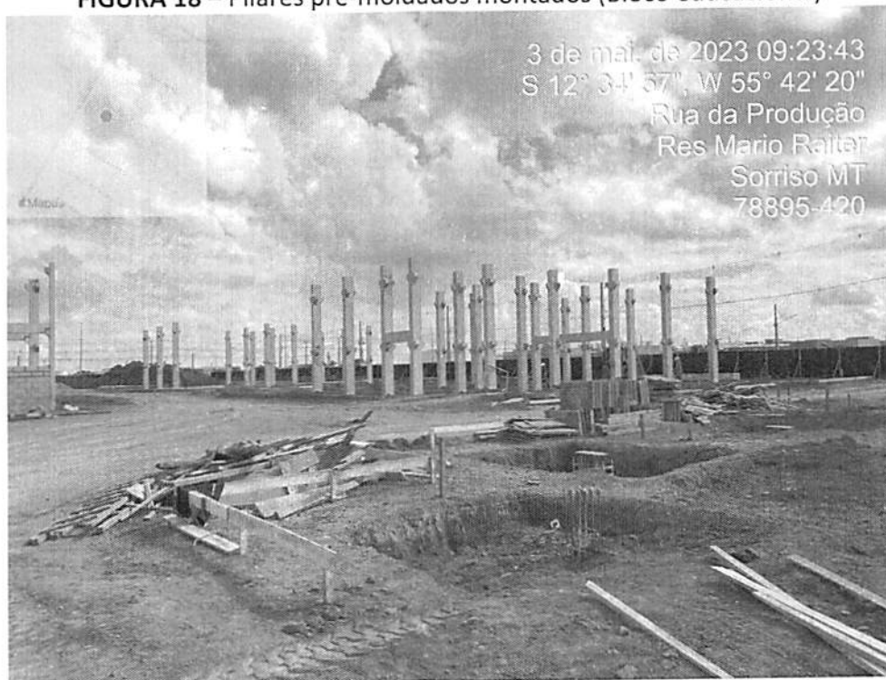
FIGURA 18 – Pilares pré-moldados montados (Bloco educacional)
