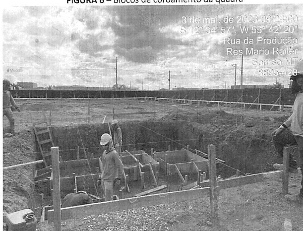
FIGURA 6 – Blocos de coroamento da quadra
