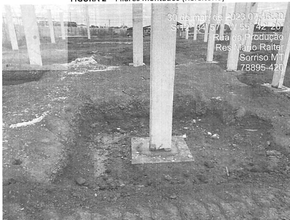
FIGURA 2 – Pilares montados (Refeitório)
