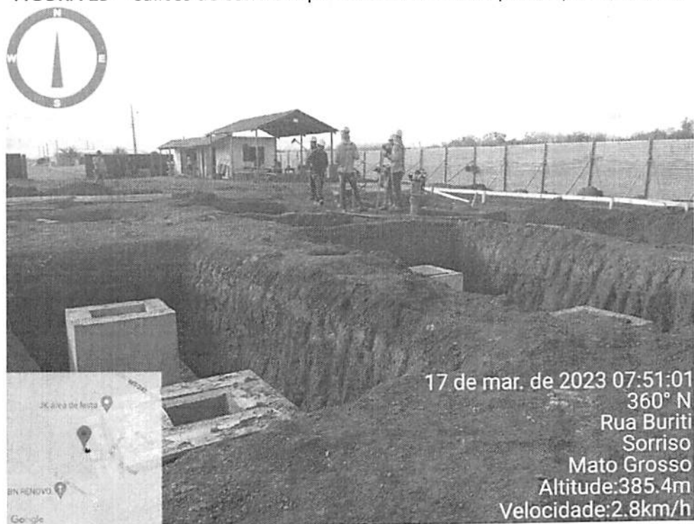
FIGURA 19 – Cálices de concreto para recebimento de pilares pré-moldados
