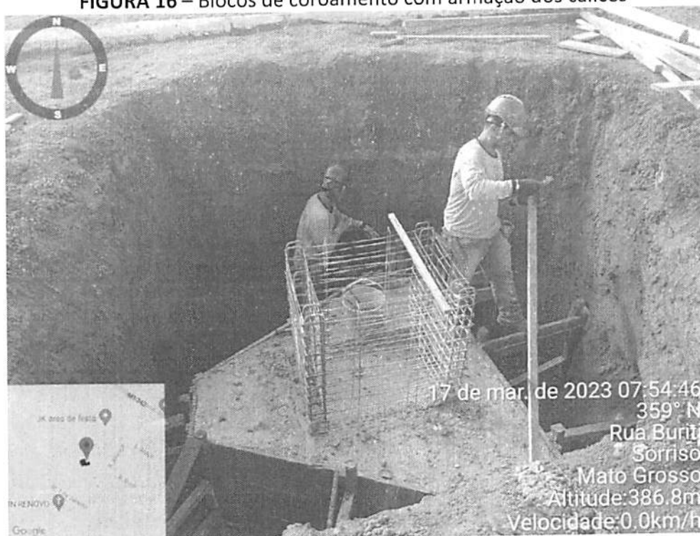
FIGURA 16 – Blocos de coroamento com armação dos cálices
