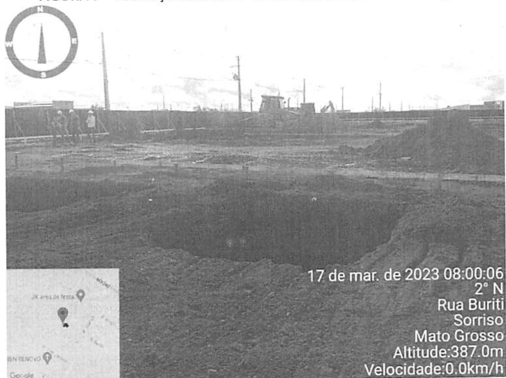
FIGURA 7 – Escavação de blocos de coroamento para concretagem
