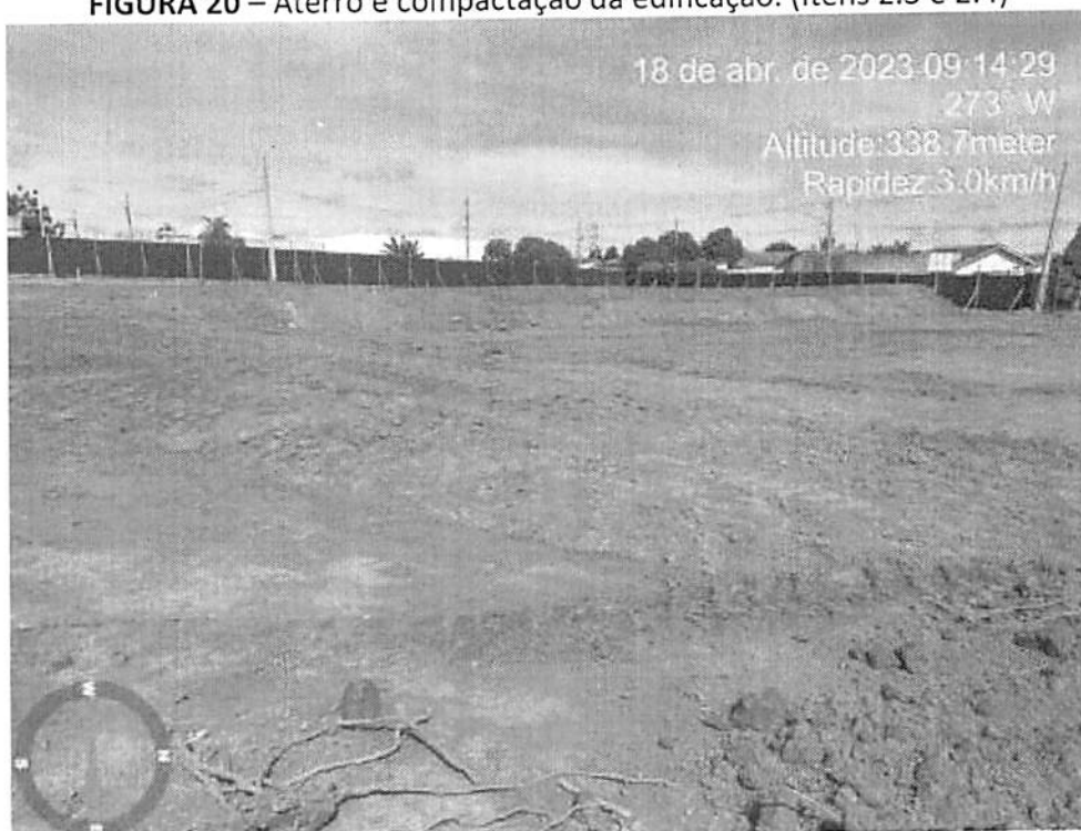
FIGURA 20 – Aterro e compactação da edificação. (Itens 2.3 e 2.4)
