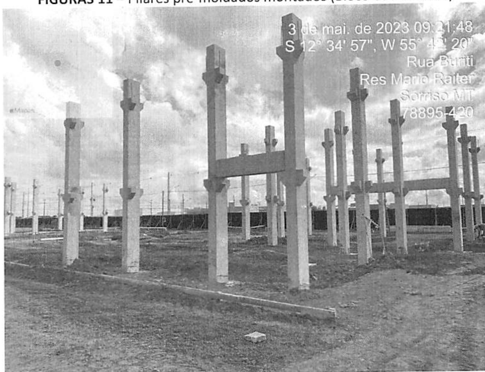
FIGURAS 11 – Pilares pré-moldados montados (Bloco educacional)
