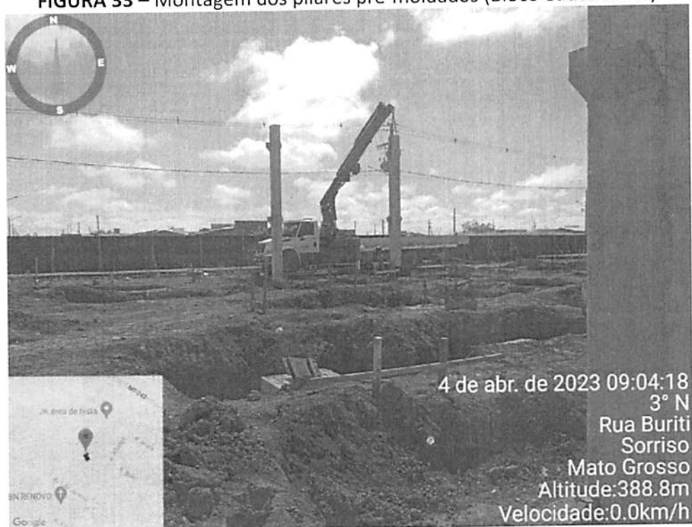
FIGURA 33 – Montagem dos pilares pré-moldados (Bloco educacional)
