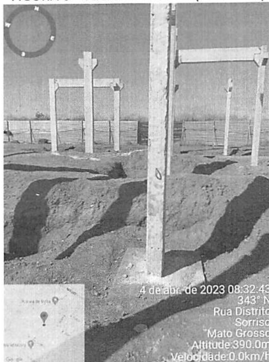
FIGURA 8 – Pilares montados (Refeitório)
