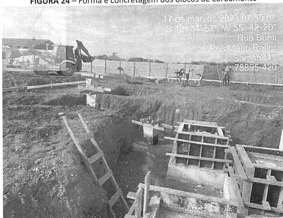
FIGURA 24 – Fôrma e concretagem dos blocos de coroamento
