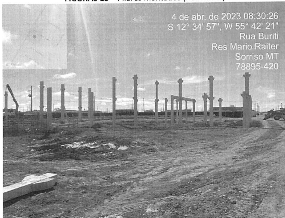
FIGURAS 13 – Pilares montados (Refeitório)
