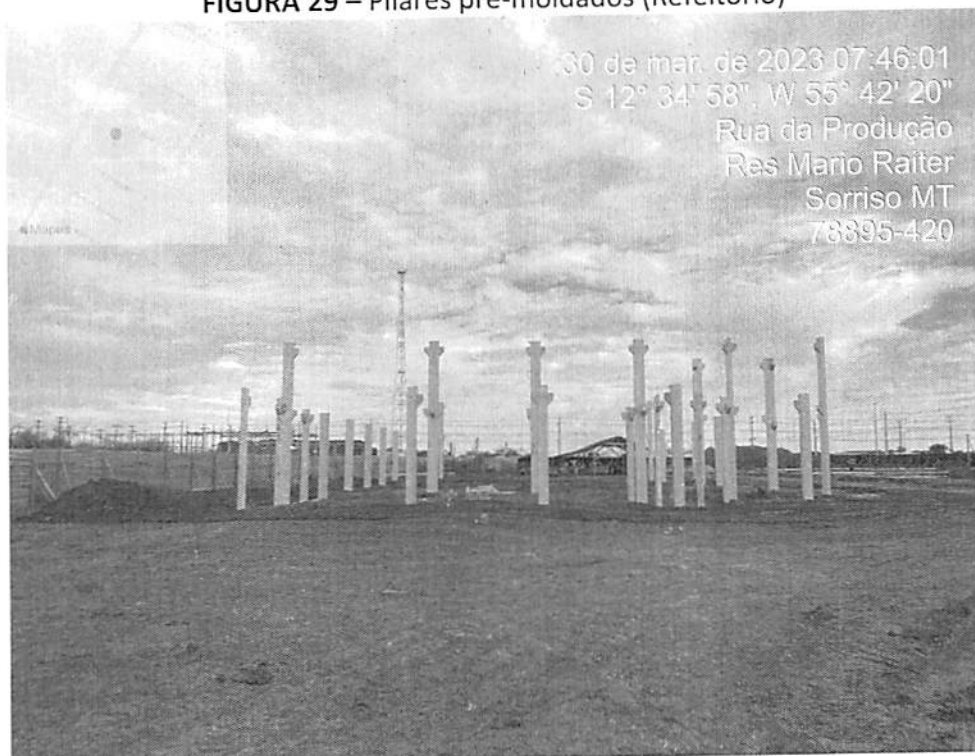
FIGURA 29 – Pilares pré-moldados (Refeitório)
