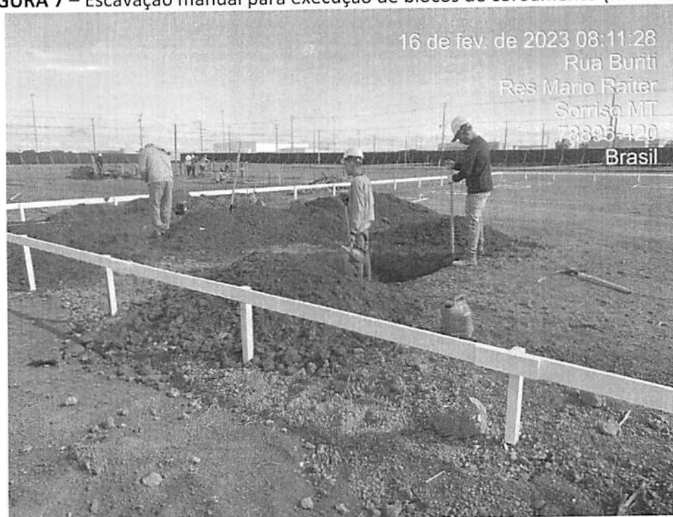
FIGURA 7 – Escavação manual para execução de blocos de coroamento (Refeitório)
