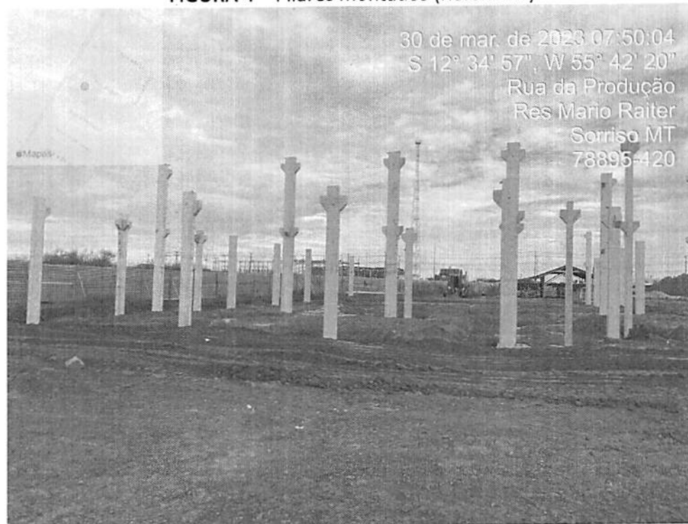
FIGURA 4 – Pilares montados (Refeitório)
