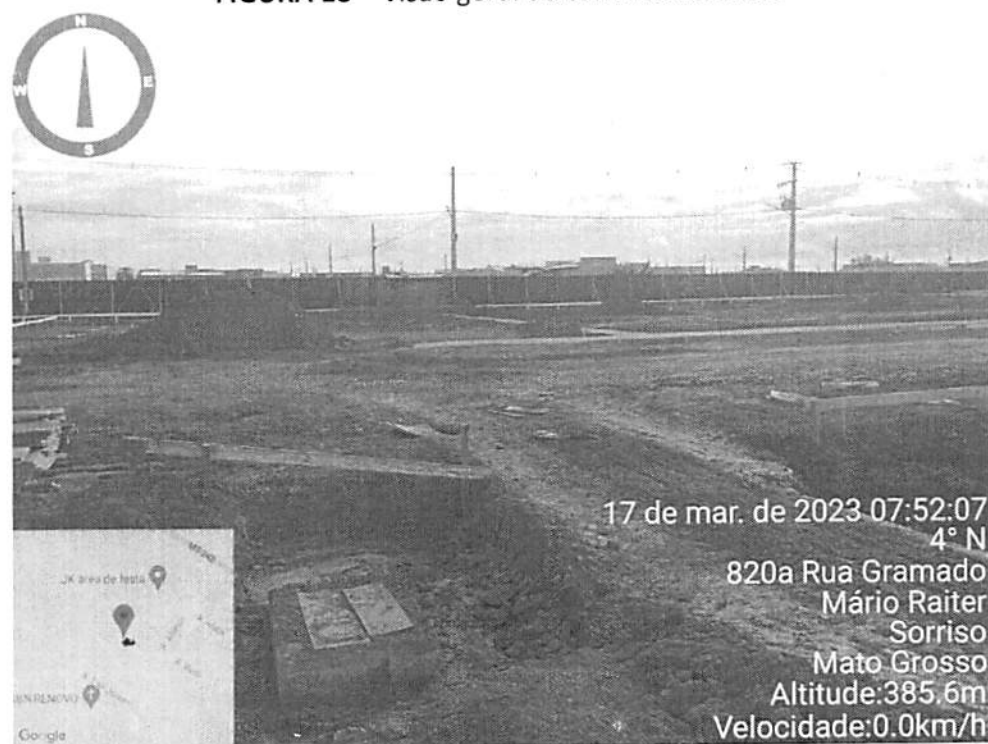
FIGURA 18 – Visão geral do canteiro de obras
