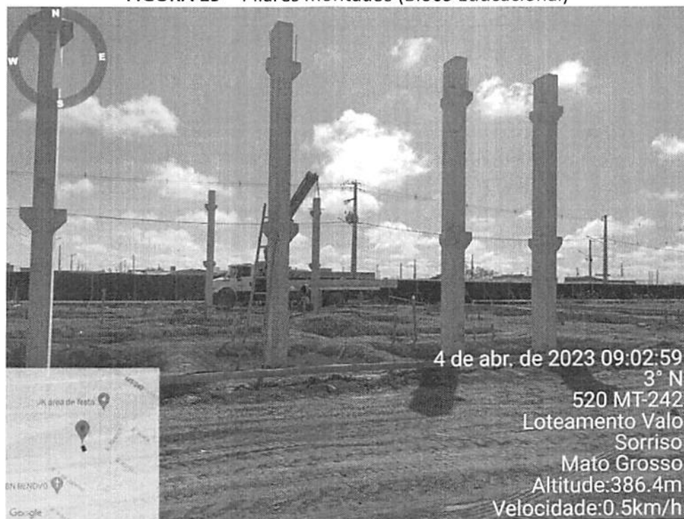
FIGURA 19 – Pilares montados (Bloco Educacional)
