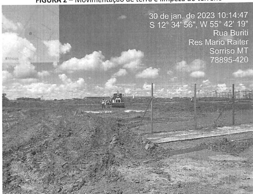
FIGURA 2 – Movimentação de terra e limpeza do terreno
