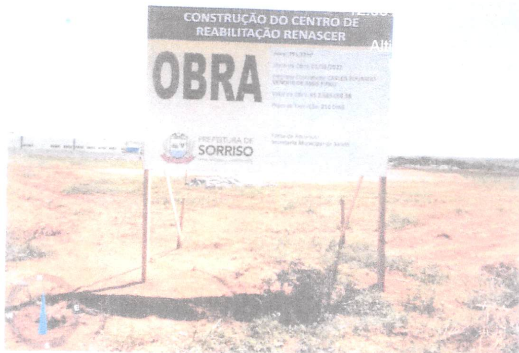
Foto 03: Placa com as informações principais da obra.
