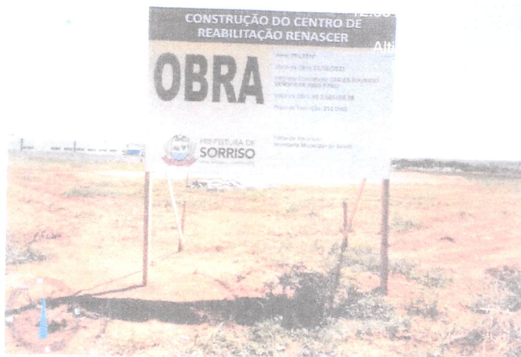
Foto 03: Placa com as informações principais da obra.
