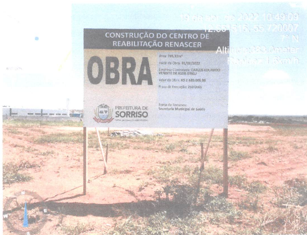
Foto 03: Placa com as informações principais da obra.
