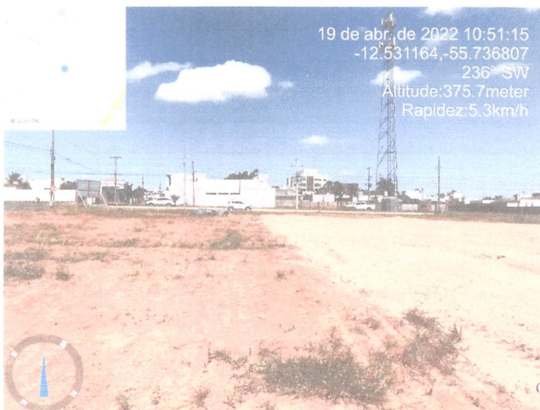
Foto 02: Vista da obra em direção a Avenida Brasil.
