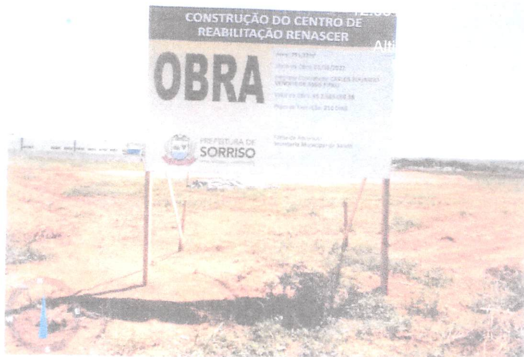
Foto 03: Placa com as informações principais da obra.
