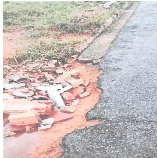
Considerando que, é necessária a construção do meio-fio, pois impede que a pista seja atingida pela erosão, além de ajudar no escoamento das águas, protegendo a pavimentação;
