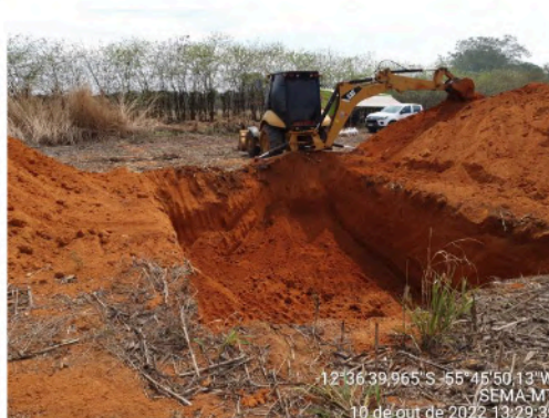
Foto 16. Tanque pulmão em construção
