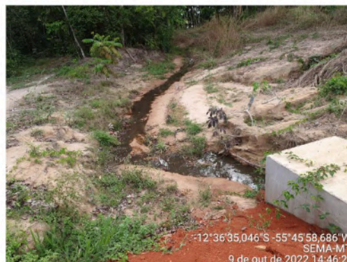
Foto 14. Drenagem de águas pluviais.
