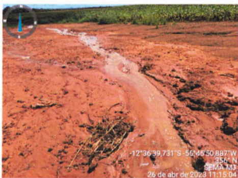
Foto 03. Água escorrendo para o barramento.
