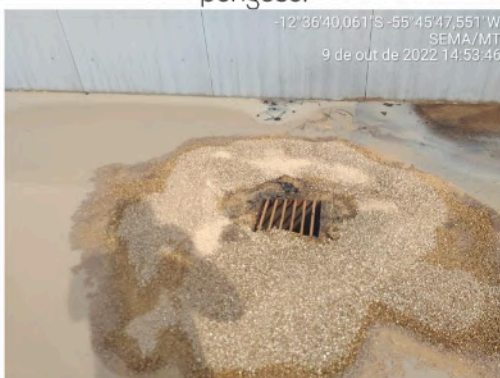
Foto 09. Vermiculita colocada para obstruir o ralo de drenagem.
