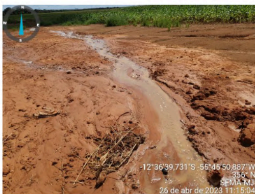
Foto 03. Água escorrendo para o barramento.
