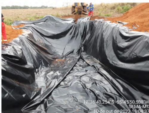
Foto 17. Lona plástica sendo colocada no tanque pulmão 01.
