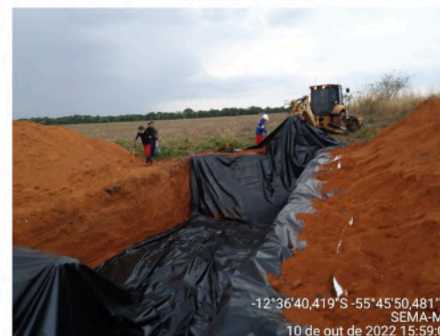
Foto 18. Lona plástica sendo colocada no tanque pulmão 01.
