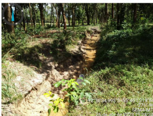
Foto 05. Água escorrendo para propriedade vizinha.
