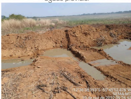
Foto 07. Dique de terra construído para conter o derramamento de produtos perigosos.
