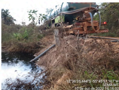
Foto 21. Caminhão realizando a sucção do efluente contaminado contido no barramento.
