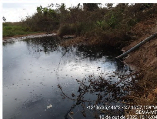
Foto 22. Caminhão realizando a sucção do efluente contaminado contido no barramento.
