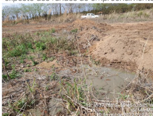
Foto 08. Dique de terra construído para conter o derramamento de produtos perigosos.
