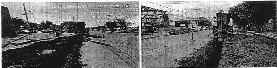
Figura 2. Abertura de vala – Linha de recalque 300
