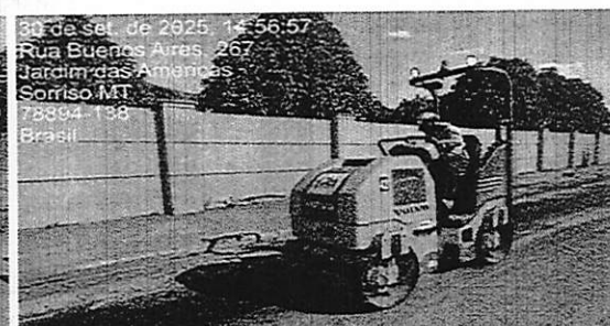
Figura 8. Reparo da pavimentação asfáltica
