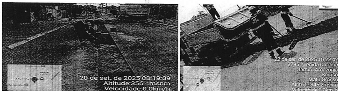
Figura 9. Reparo da pavimentação asfáltica
