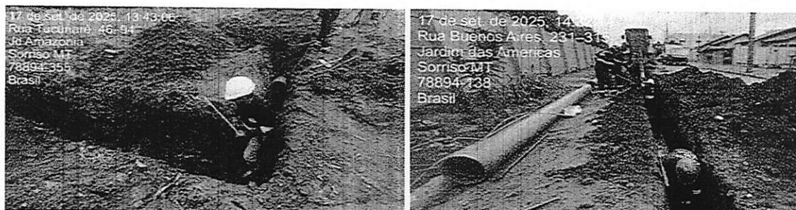
Figura 3. Medições e ajustes na linha – Linha de recalque 300
