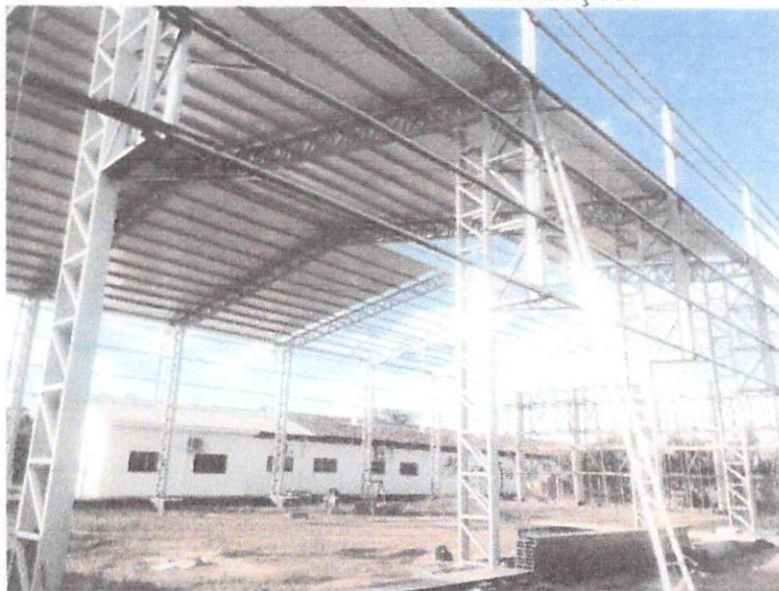
FOTO 03 – Cobertura e instalações
