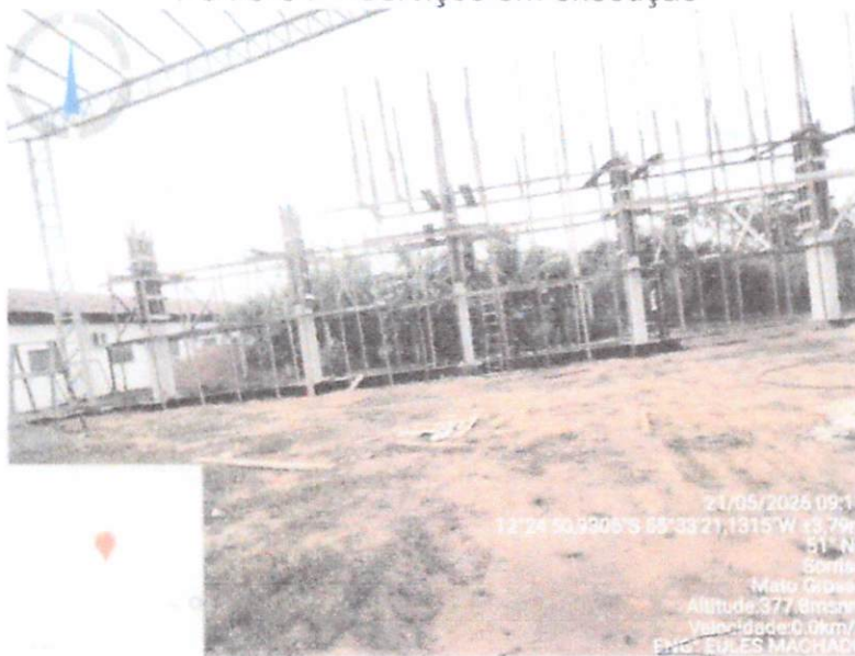
FOTO 04 – Serviços em execução
