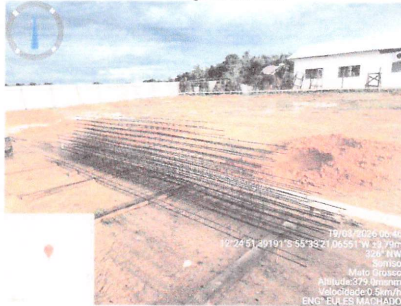
FOTO 07 – Vista geral da obra
