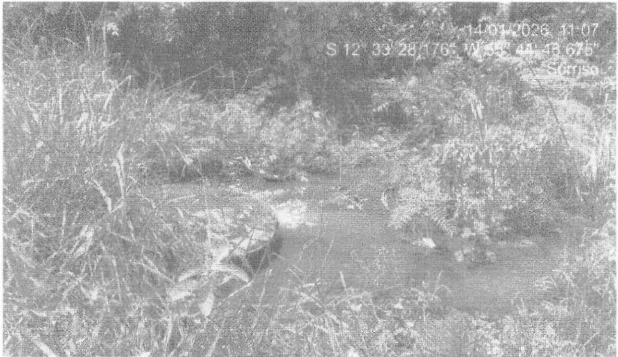
Foto 01 -PV- Esgoto extravasando pelo PV.
