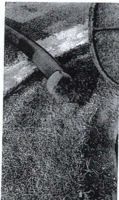
Foto 08 – Resíduo Impróprio ao PV.
