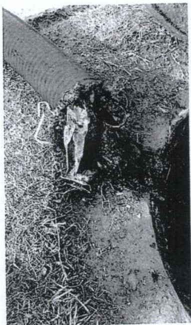
Foto 06 – Sucção dos resíduos que obstruíram o PV.
