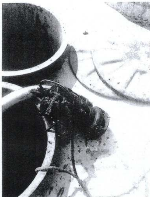
Foto 03 – Visão da peça danificada.
