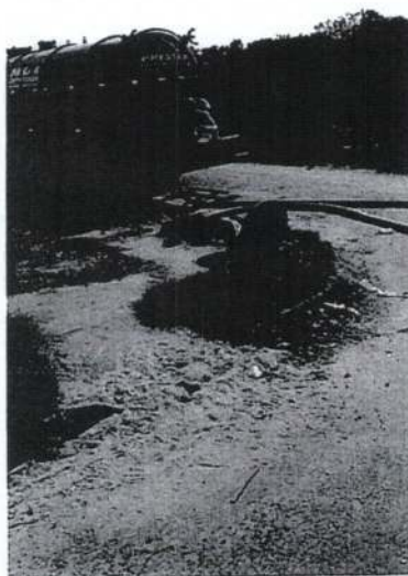
Foto 04 – Limpa – fossa acionado para o atendimento.
