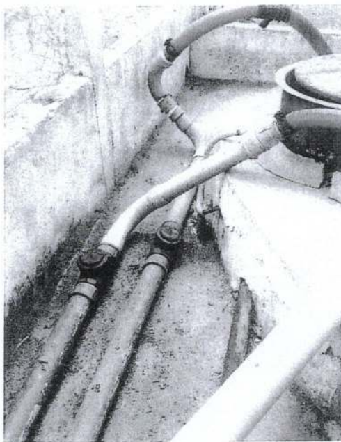
Foto 04 – Local após a manutenção.
