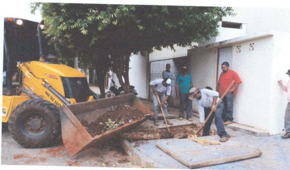
Registro da limpeza da boca de lobo.
