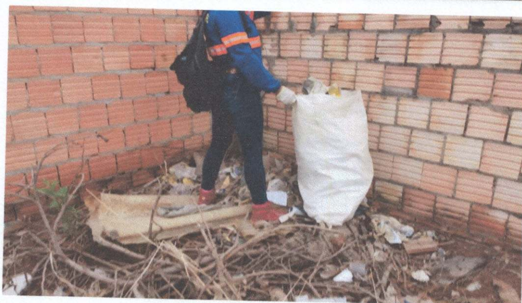
Limpeza do terreno baldio.
