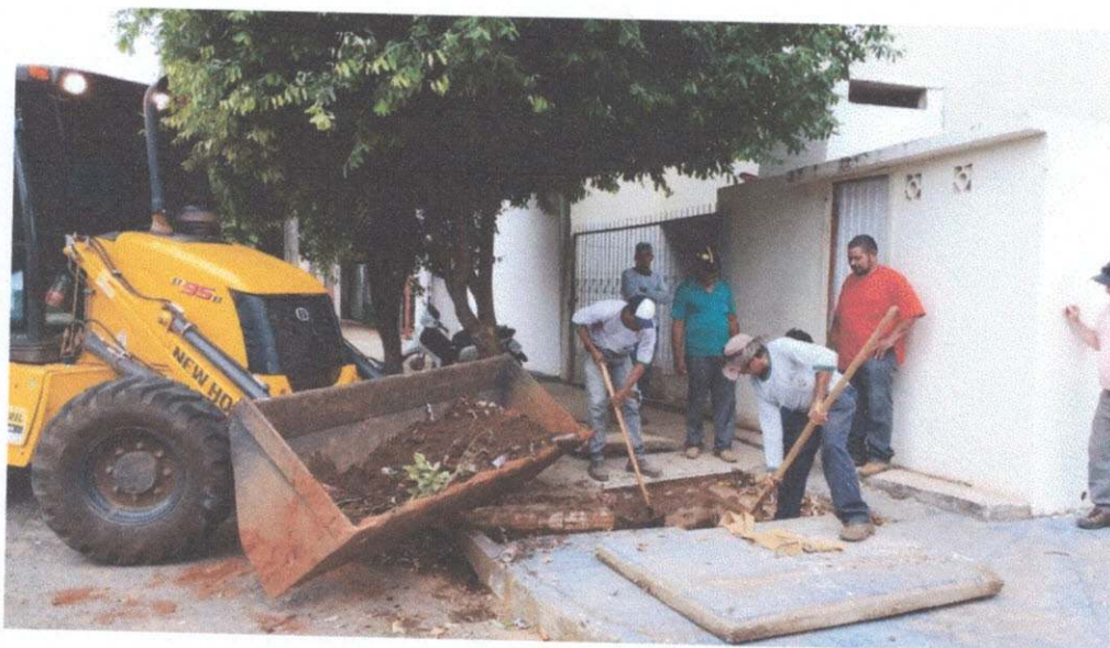
Registro da limpeza da boca de lobo.
