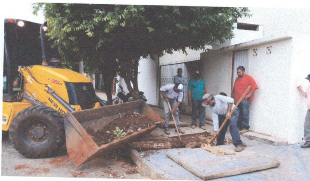
Registro da limpeza da boca de lobo.
