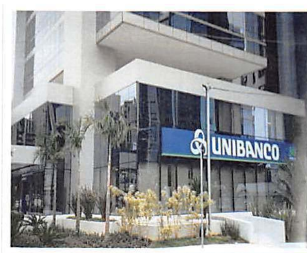
UNIBANCO BERRINI – SP Estrutura, marquises, escadas e esquadrias metálicas 84 ton.
