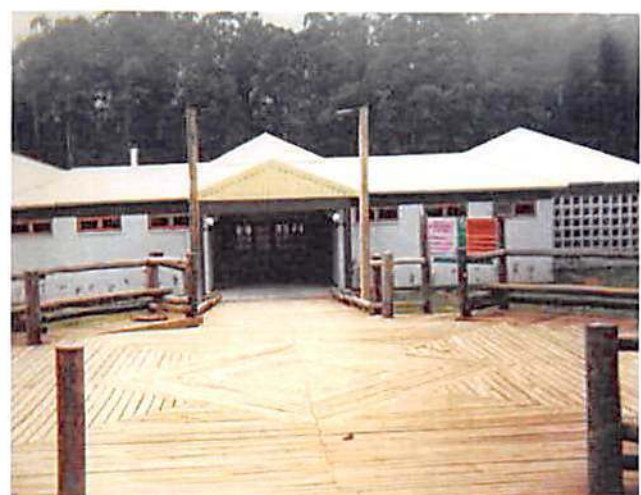
REPRESA GUARAPIRANGA – CONSTR. VARCA SCATENA Estrutura, esquadrias e gradil metálico. 138 ton.
