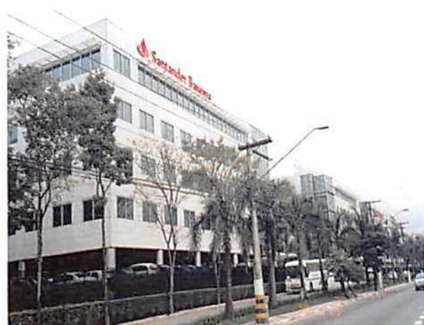
PANAMÉRICA – SP Estrutura e esquadrias metálicas 95 ton.
