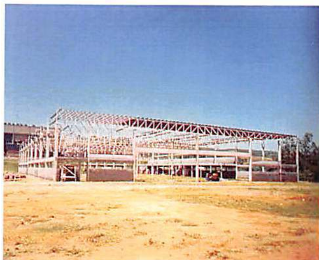
GRÁFICA EMEPE – VINHEDO Cobertura metálica 5.000 m 2
