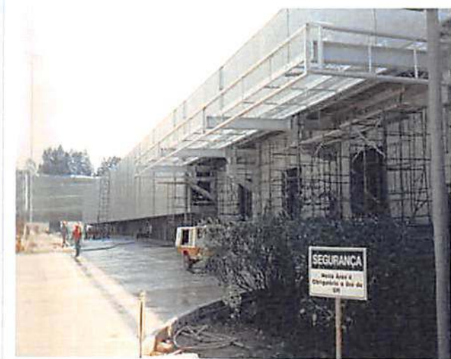
LABORATÓRIO WHITE WITE HALL – SP Estrutura e esquadrias metálicas 39 ton.
