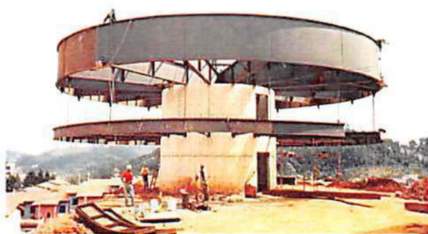
CEU – CENTRO EDUCACIONAL UNIFICADO – SP Estrutura, passarela e esquadrias metálicas 260 ton/obra CEU – SÃO MATEUS
