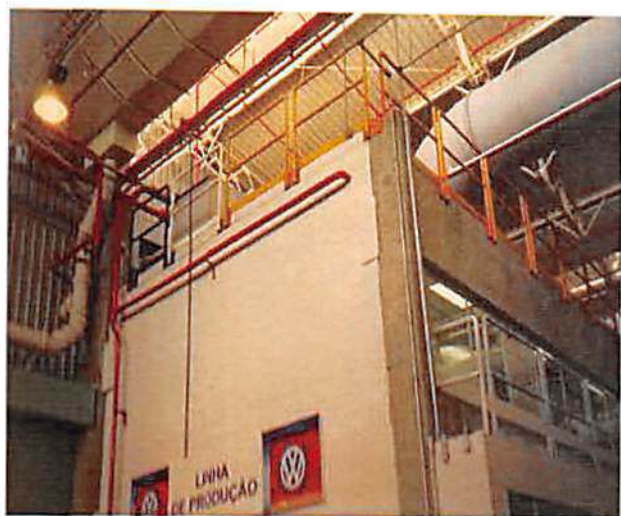
WOLKSVAGEM – SÃO CARLOS Estruturas e esquadrias metálicas 130 ton.
