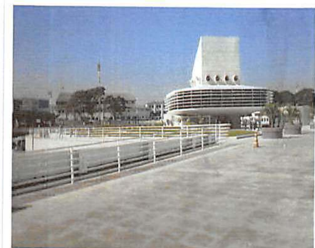
AEROPORTO INTERNACIONAL DE CONGONHAS Guarda-corpo e esquadrias em geral 69 ton.
