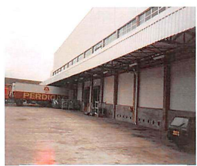
PERDIGÃO – SP Estrutura e esquadrias metálicas 48 ton.
