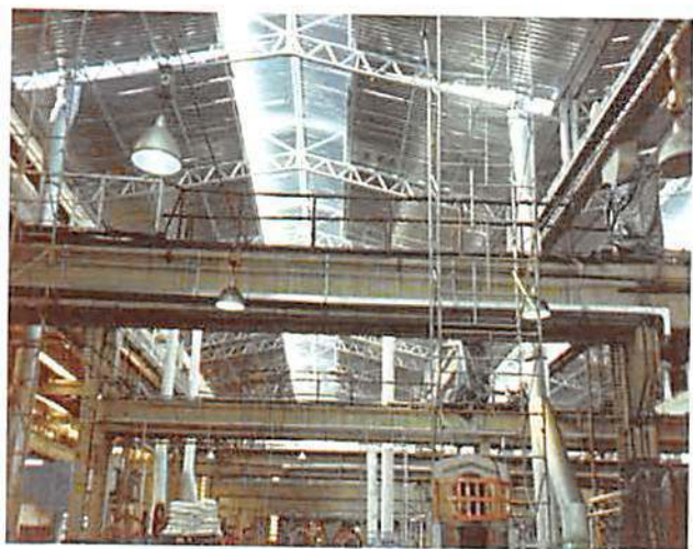
MANGELS – TRÊS CORAÇÕES – MG Estrutura metálica Área: 15000 m 2 180 ton
