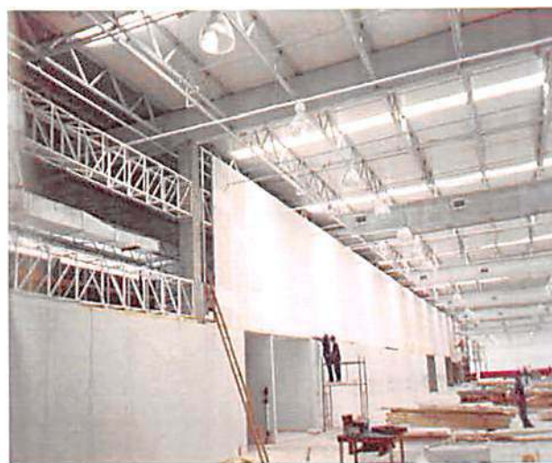
HIPERMERCADO EXTRA SÃO MIGUEL PAULISTA Estruturas e esquadrias metálicas 88 ton.
