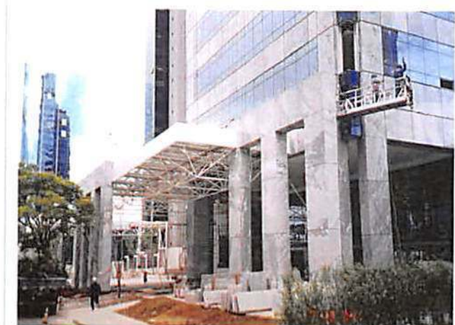
PLAZA I – SP Marquise, pórticos, estrutura para pele de vidro e esquadrias metálicas. 87 ton.
