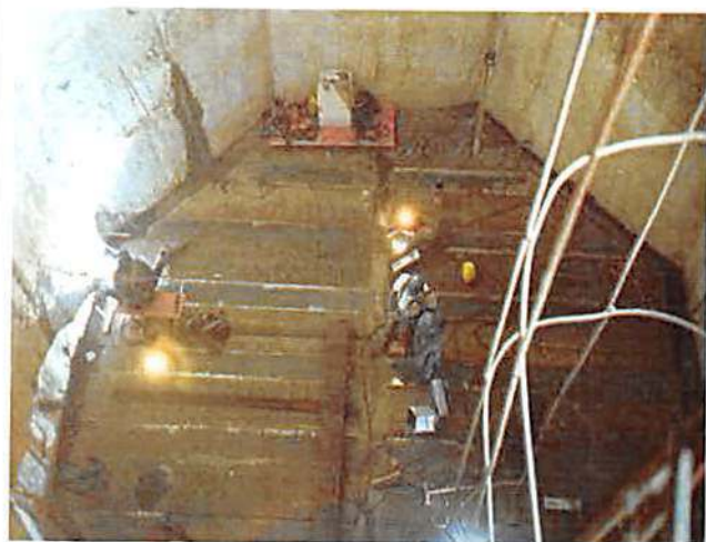
AÇOS VILARES - PINDAMONHANGABA Blindagem em tanques de vácuo com chapa 49 ton
