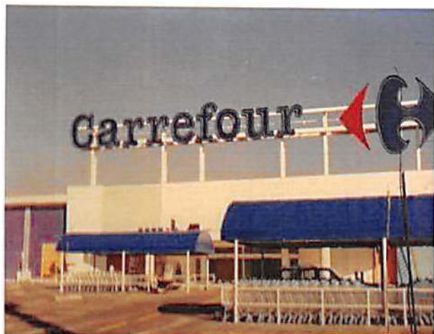
CARREFOUR PIRACICABA – SP Estruturas e esquadrias metálicas em geral 250 ton.
