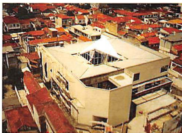
CULTURA INGLESА – SANTANA – SP Cobertura, escadas e esquadrias metálicas 64 ton.
