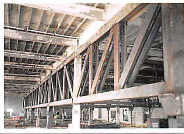
EXTRA – MOOCA Estruturas metálicas para suportar laje 187 ton.
