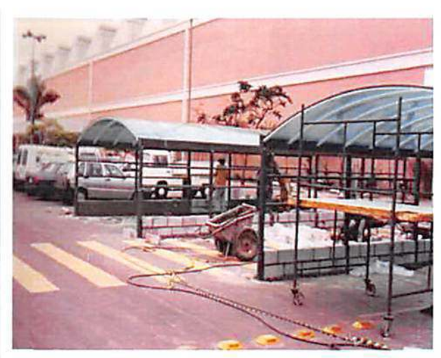
EXTRA – SANTO ANDRÉ Estruturas e esquadrias metálicas 38 ton.
