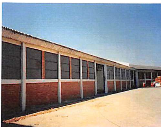
EUCATEX – ITÚ – SP Estruturas e esquadrias metálicas 42 ton.
