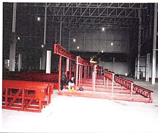
CINEMA Estruturas metálicas para arquibancada 79 ton.
