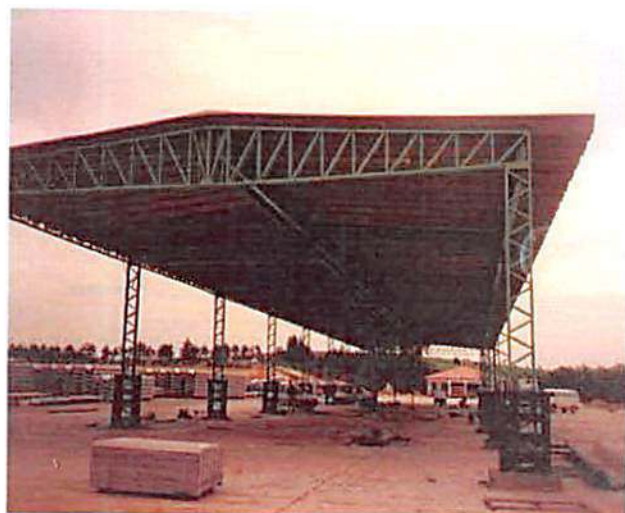
ETERBRÁS – CAPIVARÍ – SP Estrutura metálica 25 ton.
