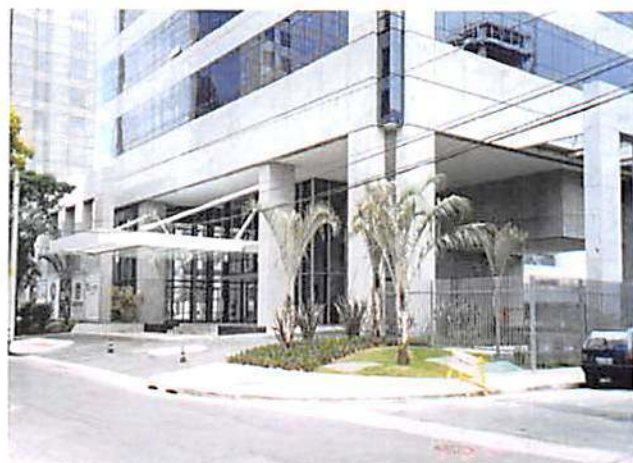
PLAZA II – SP Marquise, pórticos e esquadrias metálicas 75 ton.
