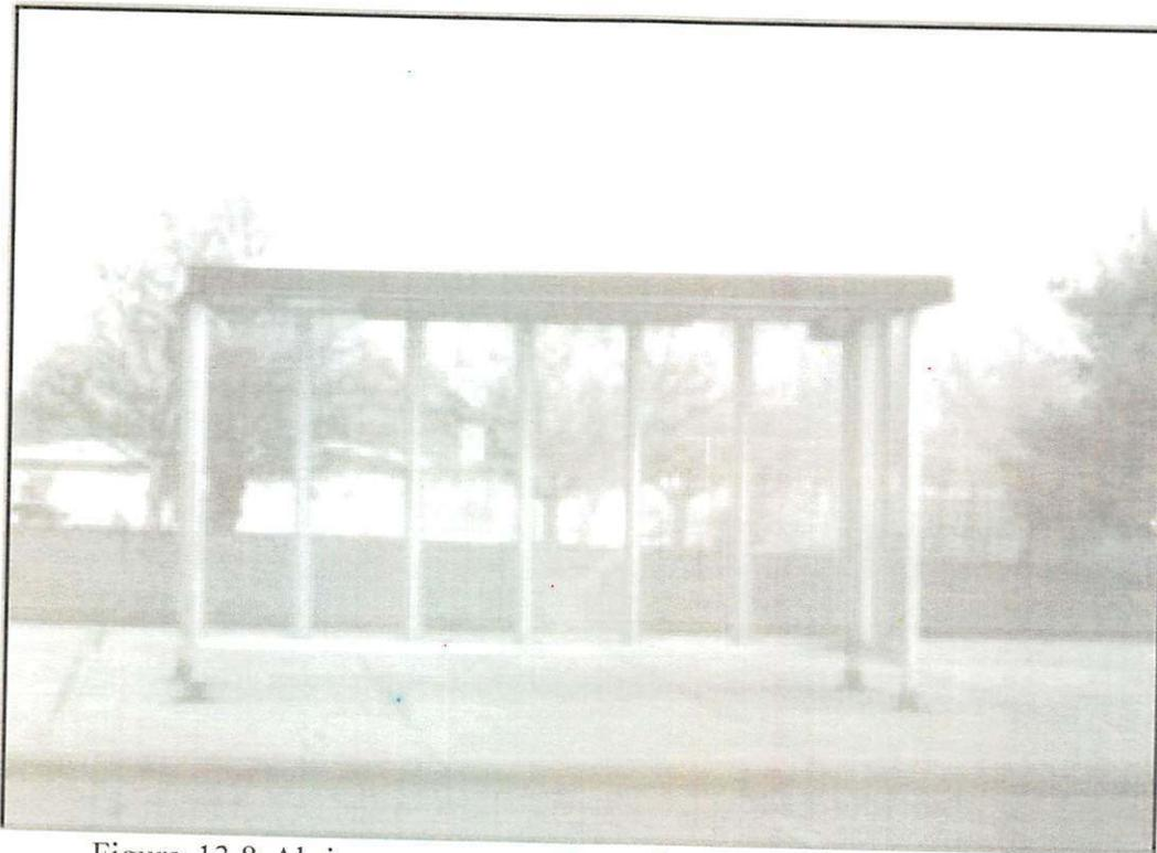
Figura 13.8 Abrigo com estrutura e cobertura metálicas e fechamento com vidro, em Bruxelas, Bélgica.
